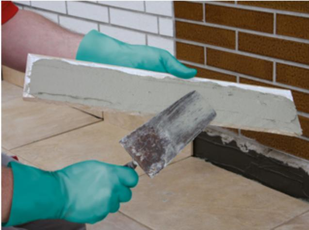
19) Auftragen eines Sopro Flexklebers (z. B. Sopro FKM® XL) auf die Rückseite der zurechtgeschnittenen Sockelfliese ...
