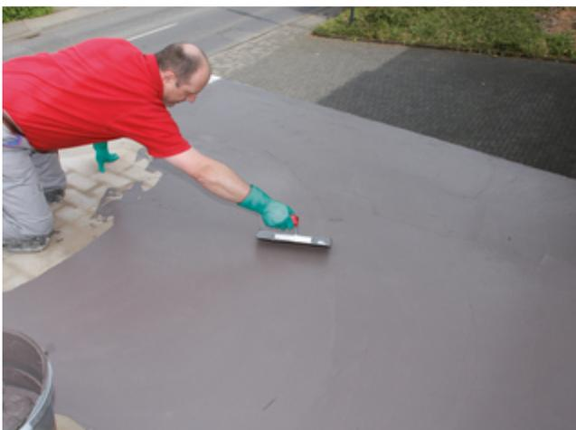
11) Glätten der Sopro TurboDichtSchlämme 2-K mittels Glättkelle.
