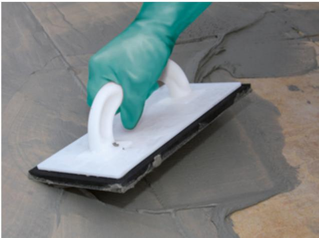
21) Einfügen einer Sopro Fugenmassen (z. B. Sopro FlexFuge FL) nach Erhärtung des Sopro Flexklebers
