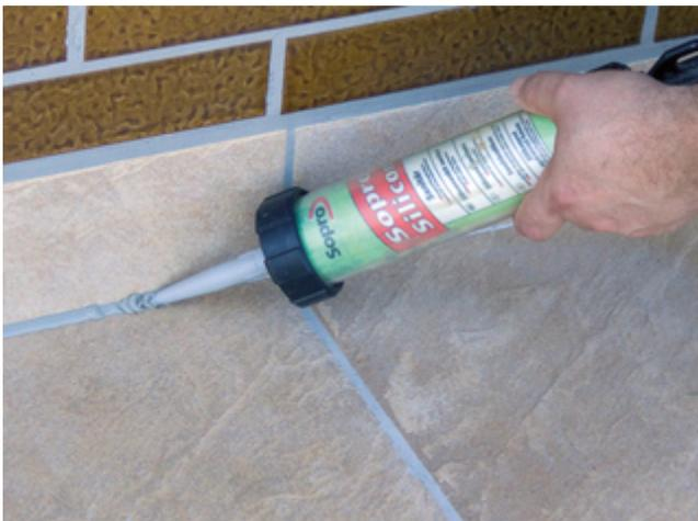
23) Einbringen von Sopro QuattroTec Dichtstoff matt in die Anschluss- und Bewegungsfugen.
