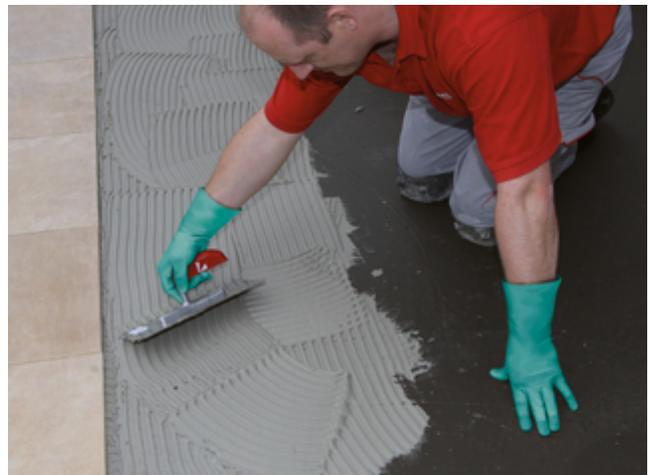
16) Auftragen des zweikomponentigen Flexklebers Sopro megaFlex S2 oder Sopro megaFlex S2 turbo auf die ausgehärtete Abdichtung.
