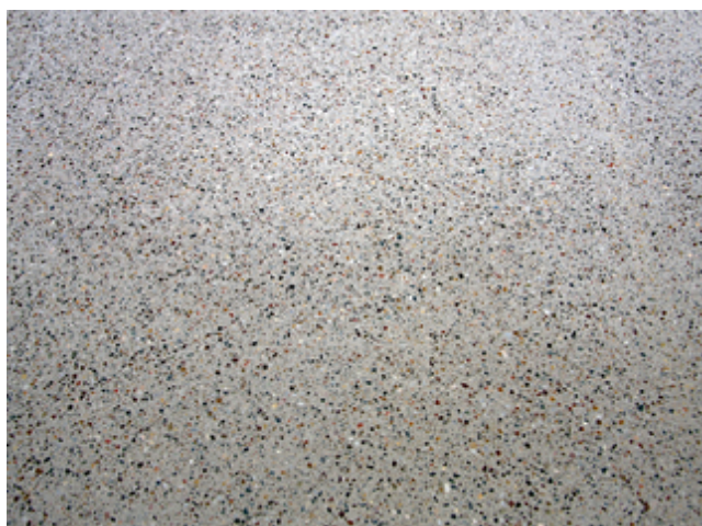
Sopro Rapidur® FE FließEstrich, geschliffen und nachbehandelt als direkt nutzbare Fläche.
