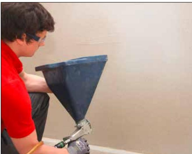
**5** Nach 5–10 Minuten die 2. Abdichtungsschicht mit Sopro QS 511 Quarzsand grob gründlich absanden.
