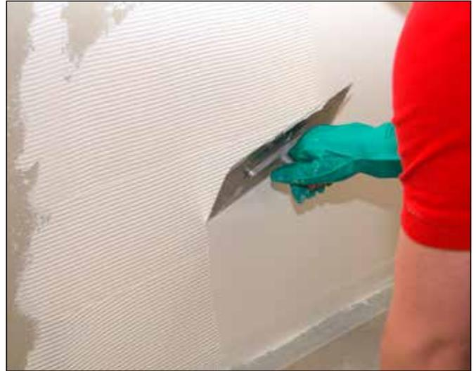
**2** Sopro PU-FlächenDicht Wand aufzahn und anschliessend die Kammstege umlegen. Erforderliche Nass-Schichtdicke pro Abdichtungsschicht: 0,6 mm.
