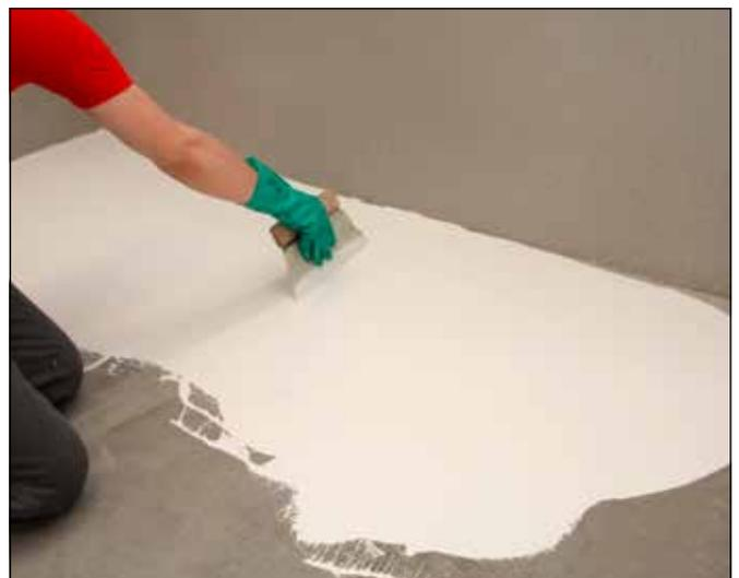
**6** Im Bodenbereich das selbstverlaufende Sopro PU-FlächenDicht Boden mittels Sägezahnleiste in zwei Schichten auftragen, mittels Stachelwalze entlüften und die zweite Abdichtungsschicht mit Sopro QS 511 Quarzsand grob im Überschuss absanden.
