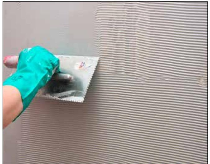
**4** Der Auftrag der zweiten Abdichtungsschicht erfolgt analog der 1. Schicht durch Aufzahn und Umlegen der Kammstege.
