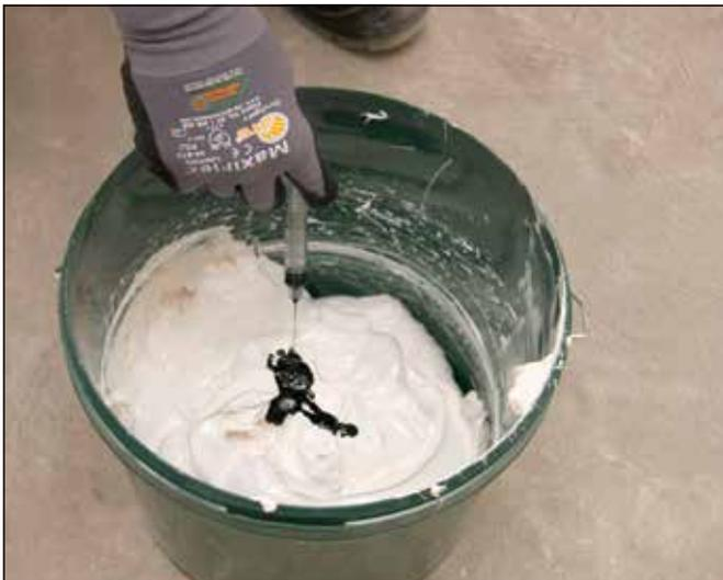
**3** Nach 8–24 Stunden die zweite Abdichtungsschicht aufbringen. Zur besseren Unterscheidbarkeit kann die zweite Abdichtungsschicht mit Sopro PU-FlächenDicht Kontrastfarbe eingefärbt werden.
