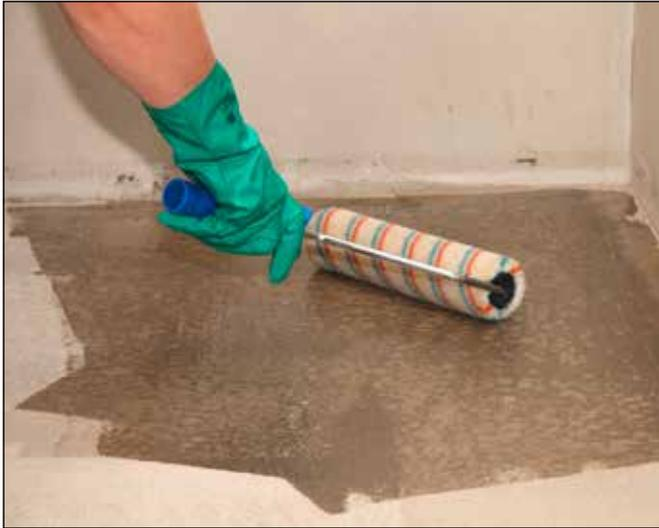
**1** Den Untergrund mit Sopro EPG 522 Epoxi-Grundierung vorbereiten und mit Sopro Quarzsand fein im Überschuss absanden.
