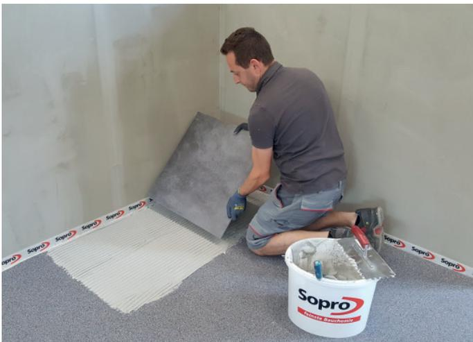
9 Verlegen der keramischen Fliesen (mind. 10 mm dick) im Floating-Buttering-Verfahren
