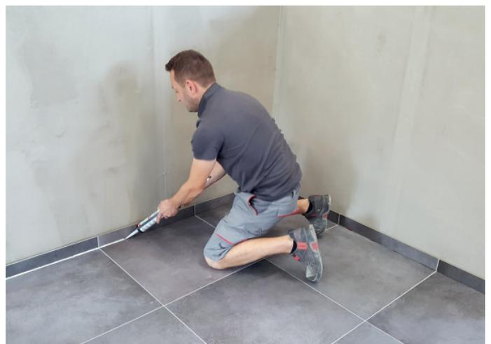
12 Schließen der Anschluss- und Bewegungsfugen mit Sopro Sanitär-Silikon
