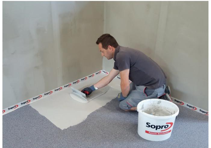
8 Einbringen des Kammbetts in die Kontaktschicht
