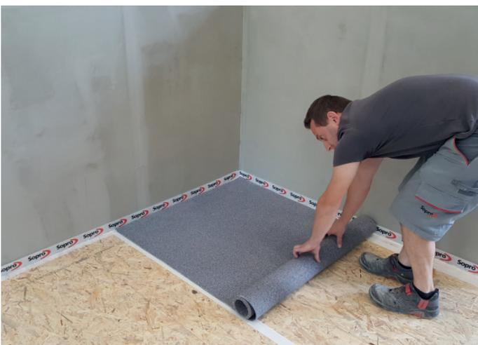
5 Fixierung der Bahn unter Hilfe der doppelseitigen Klebebänder
