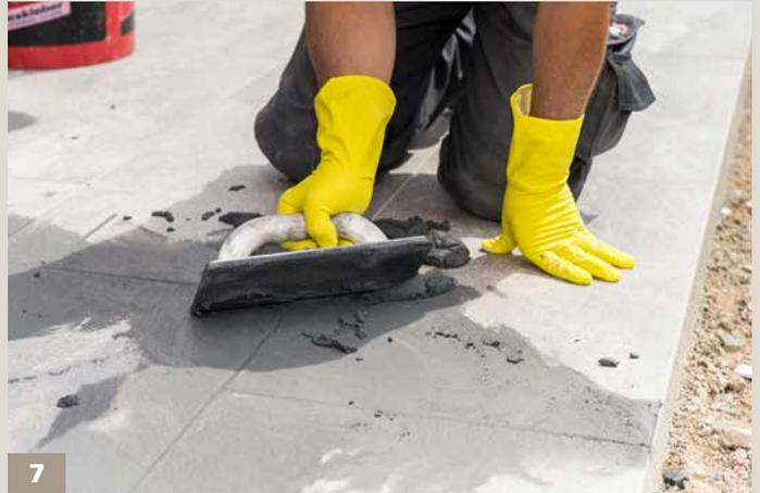
Den Fugenmörtel mit der Fugscheibe einbringen.
