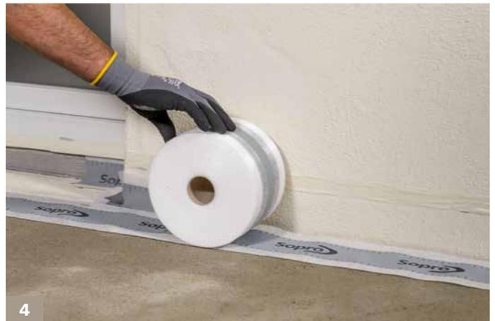
4 Im Übergangsbereich von Wand zu Boden wird das Sopro Dichtband eingebaut.
