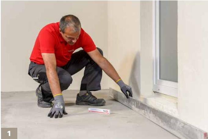
1 Vor Beginn der eigentlichen Arbeiten, die Ebenflächigkeit der Fläche (hier: Betonplatte) mittels Wasserwaage überprüfen.
