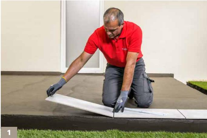
Vor Beginn der Verlegung ist der Fliesenbelag einzuteilen. Hierzu die Fliesen ausmessen bzw. lose auslegen.
