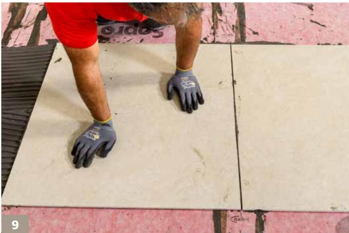
9 Folgeplatten werden in gleicher Weise verlegt.
