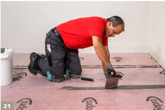
Sopro TurboDichtSchlämme 2-K im Stoßbereich auftragen.
