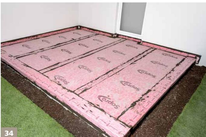
Mit Sopro AEB® plus abgedichtete Fläche – mit wasserdicht verklebten Stößen, abgedichtetem Sockelbereich und abgedichteter Stirnseite. Die so vorbereitete Fläche ist bereit für die nachfolgende Fliesenverlegung.
