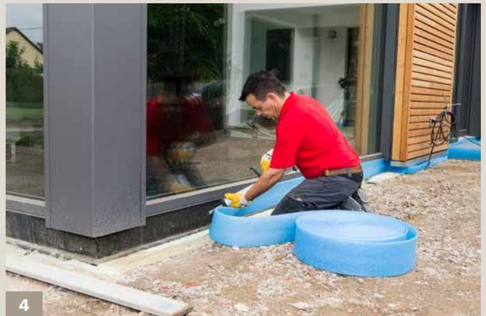
Im Bereich aufgehender Bauteile einen Sopro Randdämmstreifen stellen, um Randeinspannungen zu vermeiden.
