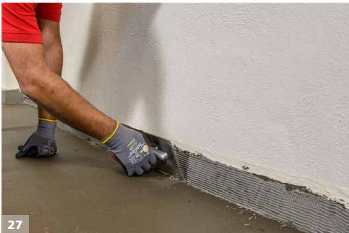
Im Anschluss erfolgt die zweite Abdichtungsschicht im Sockelbereich. Ebenfalls durch Aufzählen ...
