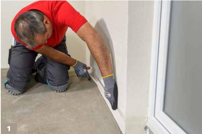
1 Die Abdichtung sollte grundsätzlich bis auf Sockelhöhe hochgezogen werden. Hierzu die Höhe ausmessen und den abzudichtenden Bereich abkleben.
