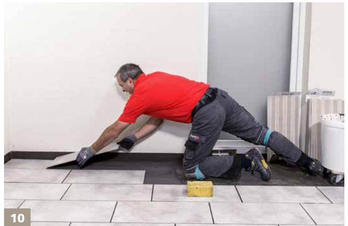
Die Verlegung der Fliesen erfolgt an der Vorderkante beginnend nach hinten und anschließend aus der Ecke heraus.
