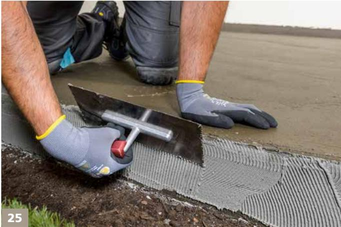
Nach Trocknung der ersten Schicht, erfolgt der Auftrag der zweiten Abdichtungsschicht, ebenfalls durch Aufzählen ...
