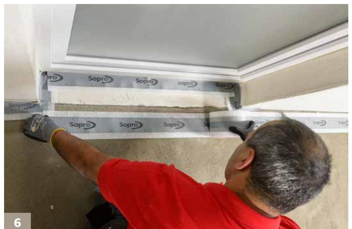
6 Dehnfugen sind ebenfalls mit einem Dichtband zu überarbeiten.
