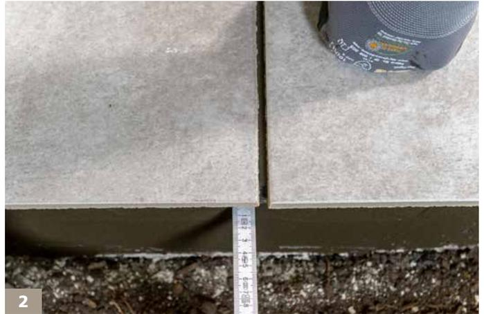
Die Fugenbreite und den Kantenabschluss (in diesem Fall Überstand der Fliese) einkalkulieren.
