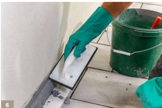
6 Der obere Sockelabschluss am Übergang zur Hauswand wird zementär verfugt. Auch hier den Fugenmörtel mit einer Fugscheibe einbringen.
