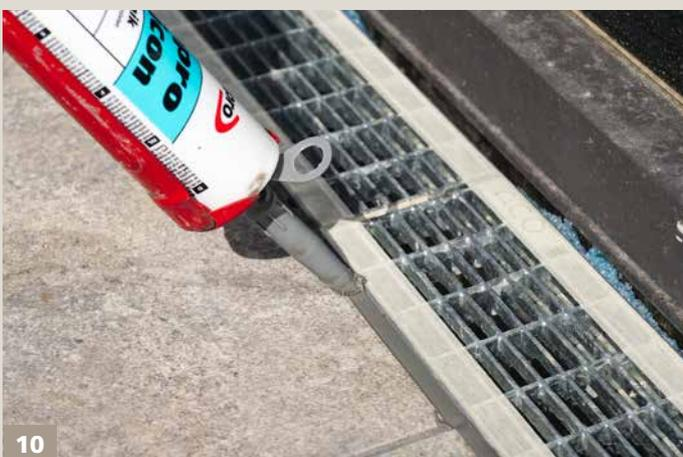
Anschluss- und Bewegungsfugen werden elastisch verfugt. Das Silikon in die Fuge einbringen, ...
