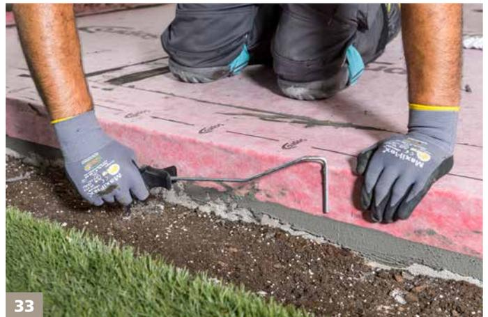
Sopro AEB® Dichtband andrücken. Den vorderen Bereich zum Erdreich mit Sopro TurboDichtSchlämme 2-K überspachteln, um ein Einziehen von Feuchtigkeit unter die Bahn zu vermeiden.
