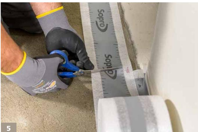
5 Die Dichtbänder lassen sich einfach mittels Schere auf die gewünschte Länge zuschneiden.
