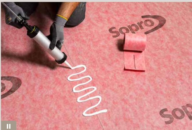
II Racofix® Montagekleber aus der Kartusche auf den Stoß auftragen ...
