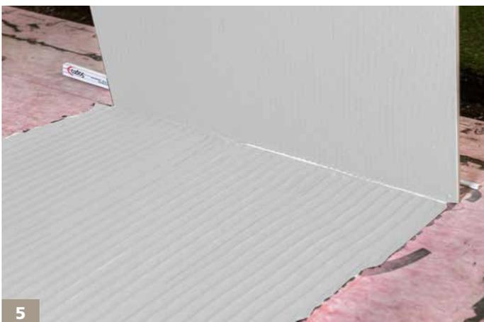
Beim Einlegen der Platte darauf achten, dass die Kammstege auf der Plattenrückseite und dem Untergrund parallel zueinander verlaufen und so ineinander greifen.
