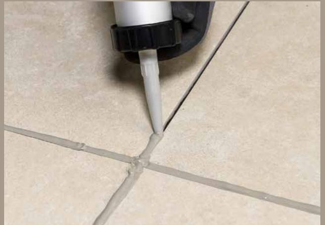
Das Einbringen des Silikons erfolgt in gleicher Weise wie bei den Anschluss- und Bewegungsfugen.
