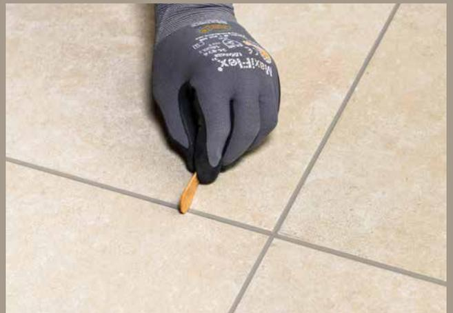
Die mit Silikon gefüllte Fuge mit Sopro Glättmittel einsprühen und gleichmäßig sauber abziehen.
