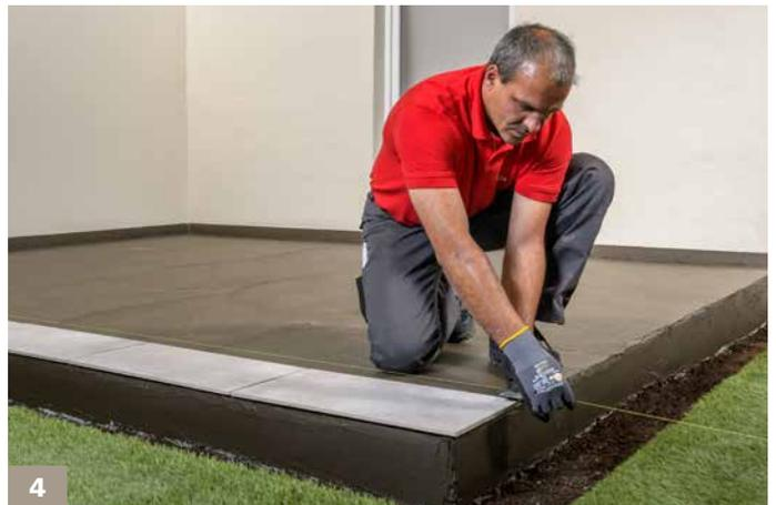
... und die Gummischnur über die Längsseite der Fläche spannen.
