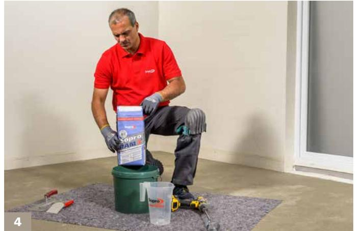
Für die Spachtelarbeiten im Schichtstärkenbereich 3–60 mm eignet sich besonders Sopro RAM 3®. Zum Anmischen Wasser vorgeben, das Trockenpulver hinzugeben ...
