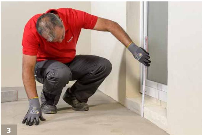
3 Ausmessen der vorhandenen Aufbauhöhe: Kalkulieren Sie hierbei die notwendige Höhe zur Erreichung des Gefälles, die Aufbauhöhe für Abdichtungs- und Verlegearbeiten sowie die Stärke der Keramik ein.
