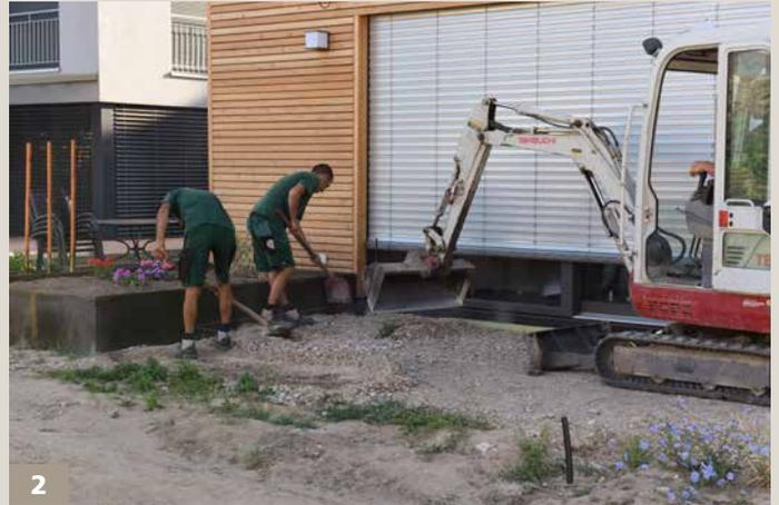
Die Schotterschicht soll die Frostsicherheit gewährleisten und ist daher ausreichend zu dimensionieren. Außerdem sollte die Schotterschicht bereits ein Gefälle von mindestens 1,5 – 2,0 % aufweisen.
