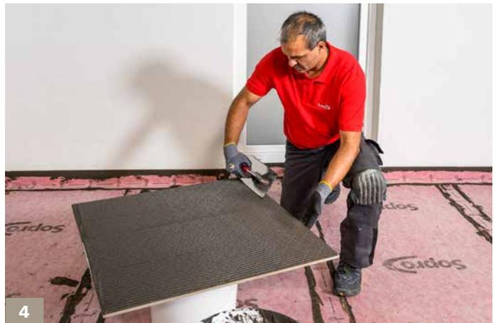
... anschließend eine Zahnung auf die Plattenrückseite aufziehen – hier: Verwendung einer 6 mm Zahnung bei einem Plattenformat von 80x80 cm.
