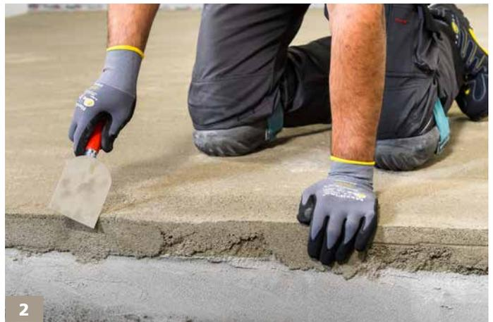
2 Scharfe Außenkanten sind zu entgraten, um diese später mit der Abdichtung überarbeiten zu können.
