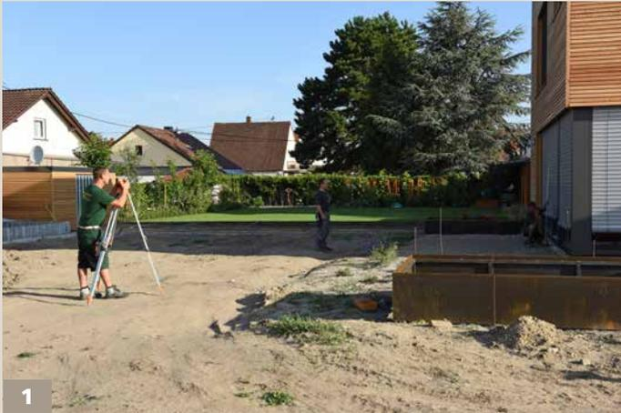
Für das anschließende Schottern und Planieren zunächst das Höhenniveau vermessen.
