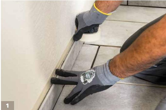
1 Um die Hauswand beim Verfugen vor Verschmutzungen zu schützen, diese an der zu verfugenden Sockeloberkante abkleben.
