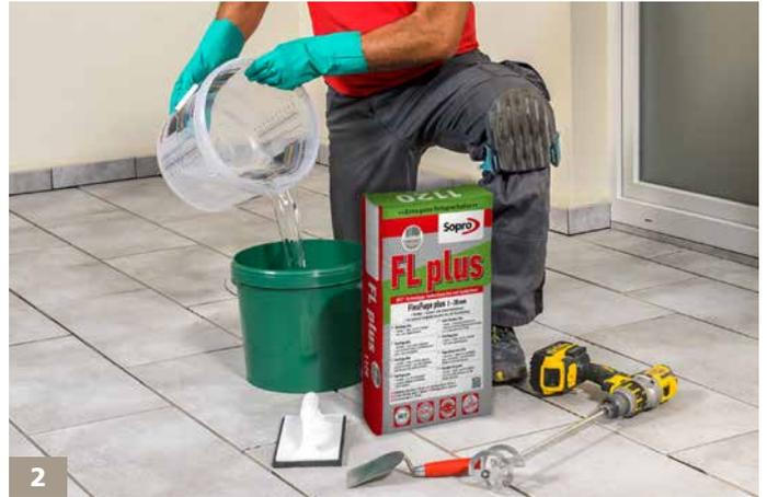
2 Zum Anmischen von Sopro FlexFuge plus zunächst Wasser vorgeben. Auf eine genaue Wasserdosierung achten. Anschließend das Trockenpulver hinzugeben ...
