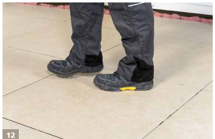
12 Mit Sopro megaFlex S2 verlegte Flächen sind nach ca. 12 Stunden begehbar. Bei der Verwendung von Sopro megaFlex turbo Silver kann die Fläche bereits nach ca. 3 Stunden begangen werden.
