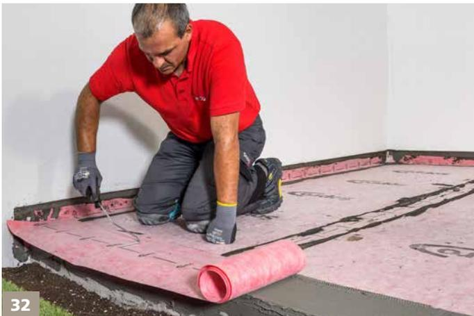
Über die Stirnkante das Sopro AEB® Dichtband einlegen, das für Anwendungsfälle dieser Art auch in einer Breite von 30 cm erhältlich ist.
