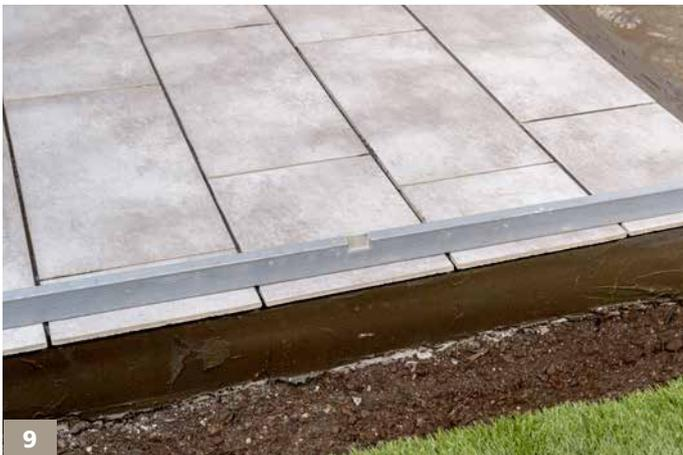
Die Ebenflächigkeit regelmäßig mittels Wasserwaage überprüfen.
