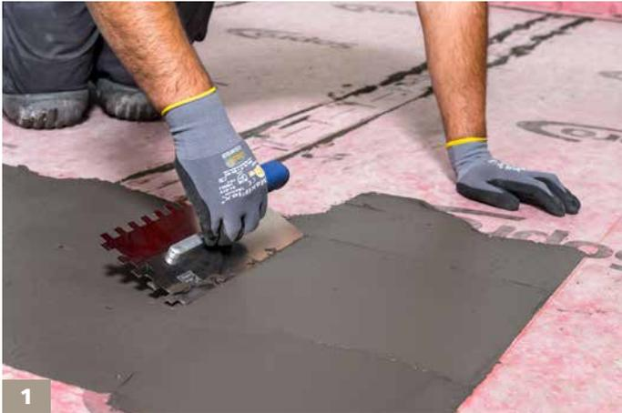
Bei der Verlegung auf der Sopro AEB® plus in gleicher Weise vorgehen und an der Hilfslinie beginnend zunächst eine Kontaktschicht aufziehen. Da in diesem Beispiel Teilstücke am Rand angeordnet werden, beginnt die Verlegung mit einer ganzen Fliese nicht direkt an der Terrassenkante.
