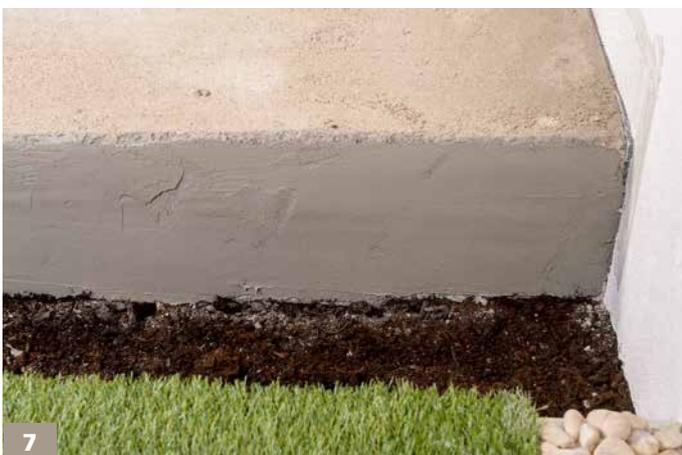
Die so vorbereitete Stirnseite – ebenflächig, ohne scharfe Kanten – ist nach Erhärten des Spachtels optimal vorbereitet für die nachfolgende Abdichtung.
