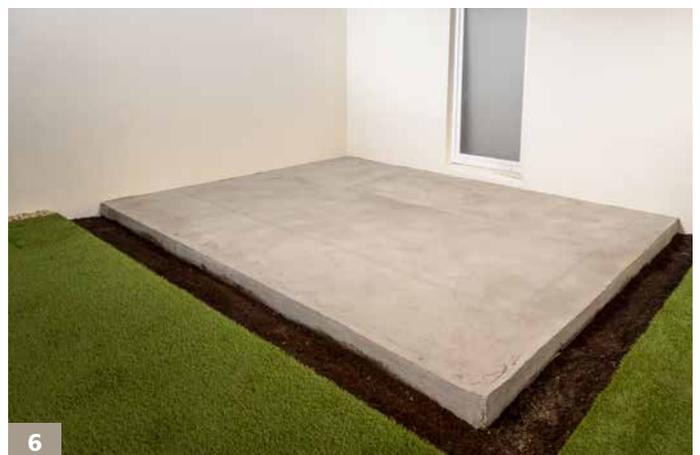
6 Die so vorbereitete, saubere Fläche ist bereit für nachfolgende Arbeiten. Je nach Baustellensituation können dies Gefälleestrich- bzw. Spachtelarbeiten oder direkt Abdichtungsarbeiten sein.
