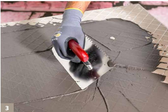
Die Verlegung im Außenbereich erfolgt im Battering-Floating-Verfahren. Hierzu auch die Plattenrückseite abspachteln. Zunächst eine Kontaktschicht, ...
