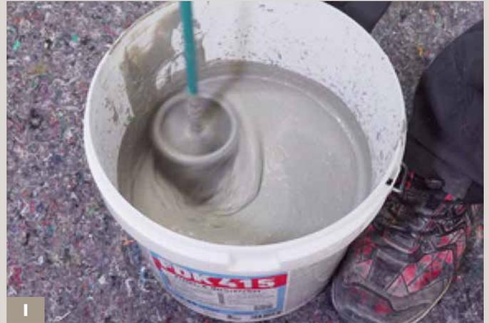
I Eine weitere Variante zur Abdichtung des Stoßbereiches bietet der zweikomponentige, mineralische Reaktivkleber Fixier- & DichtKleber 2-K.
