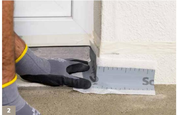
2 Die systemgeprüften Sopro Dichtbänder und -ecken vorbereiten. Im Bereich von Ecken und Vorsprüngen kommen die vorgeformten Sopro Dichtecken außen ...
