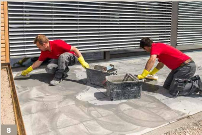
Nach ausreichender Standzeit des Fugenmörtels, diesen diagonal zum Fugenverlauf vorwaschen.
