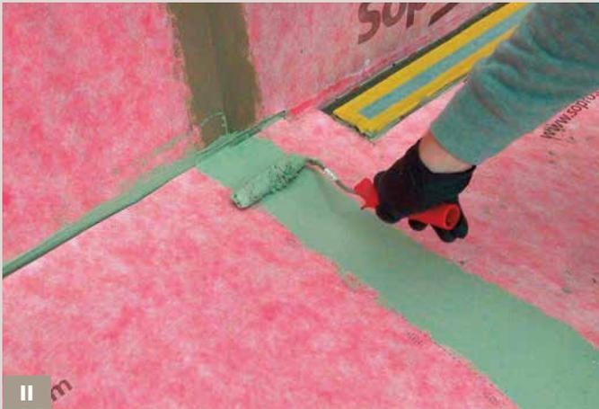
Fixier- & DichtKleber 2-K im Stoßbereich satt auftragen, ...
