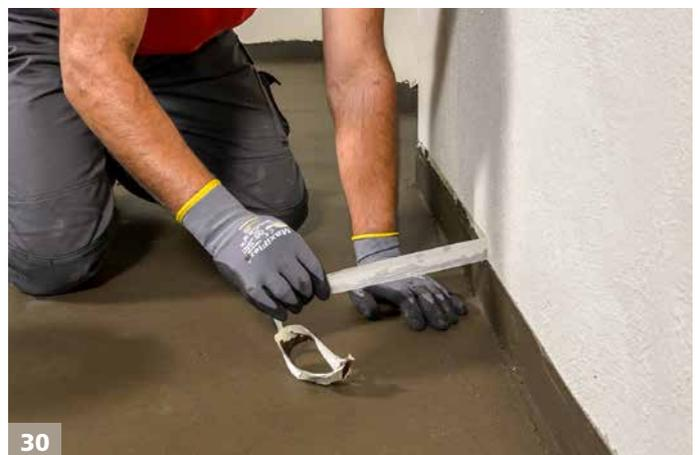
Nach Abschluss der Abdichtarbeiten und Begehbarkeit der zweiten Dichtschicht, das Klebeband im Sockelbereich vorsichtig entfernen.
