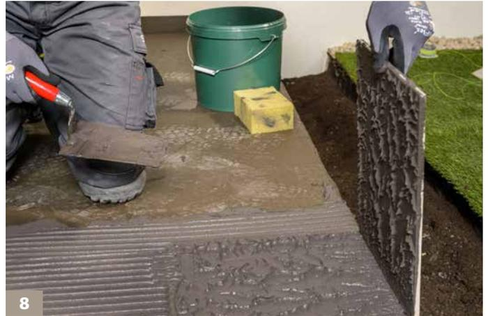
Die nachträglich herausgenommene Fliese zeigt deutlich eine vollsattete Rückseitenbenetzung, wie sie gerade im Außenbereich von besonderer Bedeutung ist.
