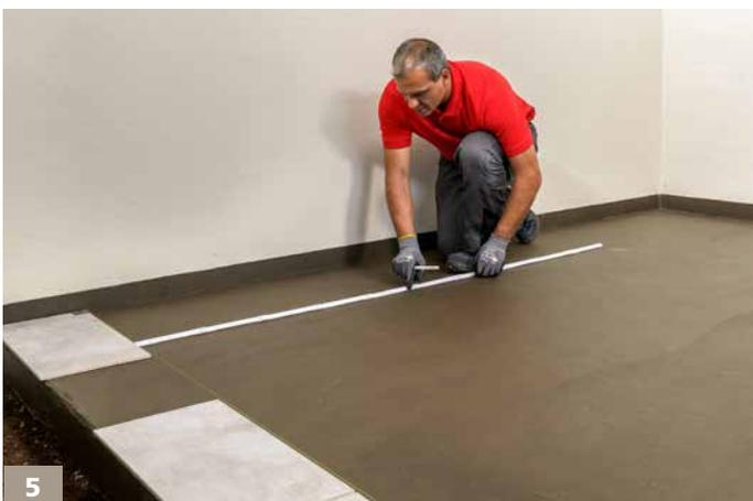
Die Breite der Fläche (Senkrecht zur Schnur) vermessen, um anschließend die Fliesen auswinkel zu können.
