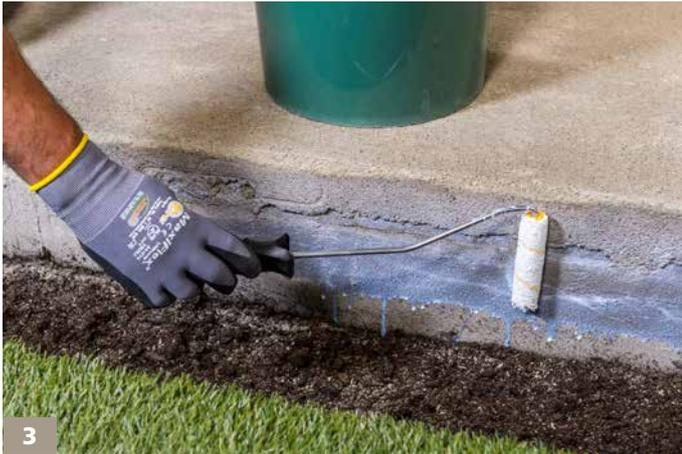
Die Betonplatte sowie der Zementestrich sind saugende Untergründe und werden mit Sopro Grundierung vorbehandelt.
