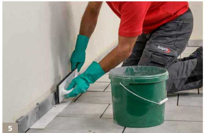
5 Den Fugenmörtel zunächst im Sockelbereich einbringen. Die Anschlussfuge Wand/Boden wird elastisch verfugt und ist daher zunächst auszusparen – die offene Fuge ggf. abdecken.
