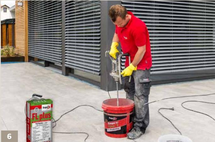
Zum Verfugen breiterer Fugen eignet sich besonders der zementäre Fugenmörtel Sopro FlexFuge plus. Zum Anmischen zunächst Wasser vorgeben, anschließend das Trockenpulver hinzugeben und mittels Rührquirl klumpenfrei anmischen. Reifezeit beachten.
