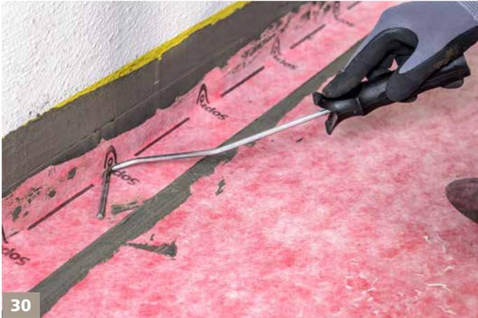
Sopro AEB® Dichtband einlegen und gut andrücken, sodass keine Luftschlüsse unter dem Band verbleiben.
