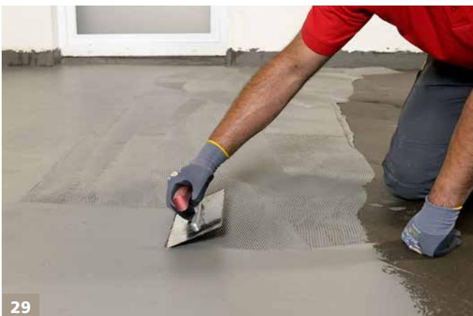
Zuletzt wird die zweite Schicht der Flächenabdichtung aufgetragen. Die Abdichtung in zwei Arbeitsgängen ist seitens der Regelwerke vorgeschrieben, um Fehlstellen zu vermeiden.
