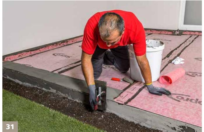
An der Stirnseite die Abdichtung aus Sopro TurboDicht-Schlämme 2-K bis ans Erdreich heranführen.
