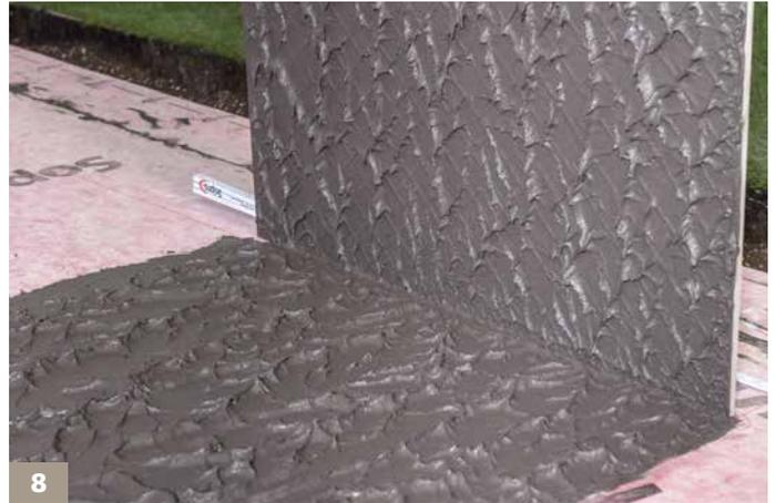
8 Die nachträglich herausgenommene Fliese zeigt deutlich eine vollsattete Rückseitenbenetzung, wie sie gerade im Außenbereich von besonderer Bedeutung ist.
