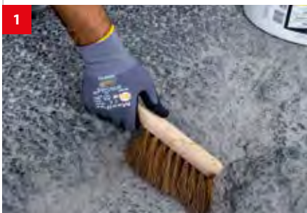
Očistenie poškodeného miesta
