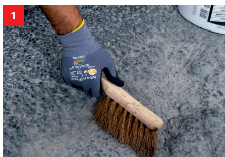
1 Očistite poškodovano mesto.
