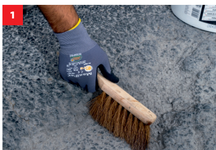
Očistite oštećeno mjesto
