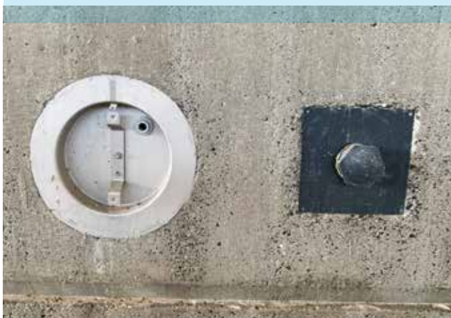
Éléments en acier inoxydable et PVC encastrés dans la paroi du bassin.
