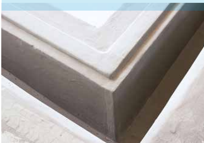
Étanchéité et modelage d'une tête de bassin.
