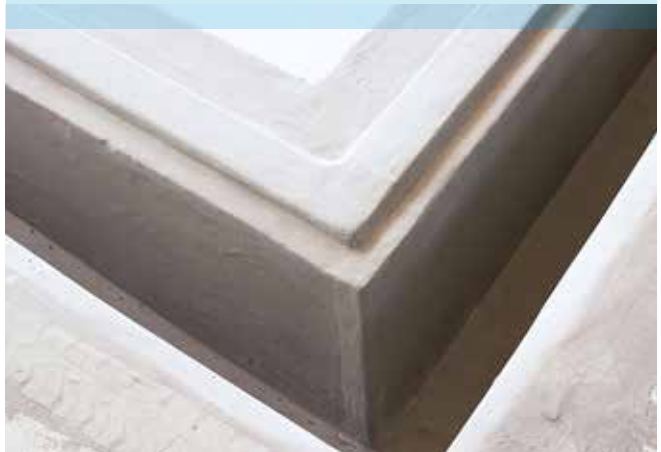
Altaan reunan vedeneristys ja muotoilu.
