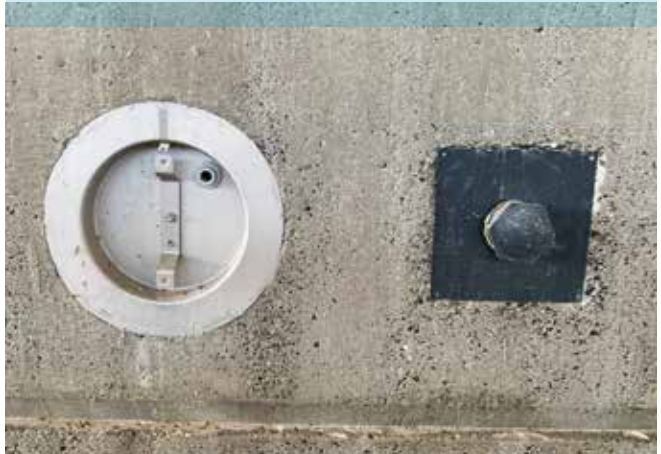
Allasseinän yksityiskohdat ruostumattomasta teräksestä ja PVC:stä.
