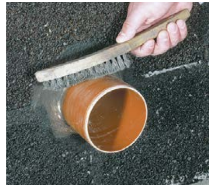
2 Nach Aushärtung der Hohlkehle wird die Oberfläche des Rohres mit einer Drahtbürste oder grobem Schleifpapier aufgeraut.
