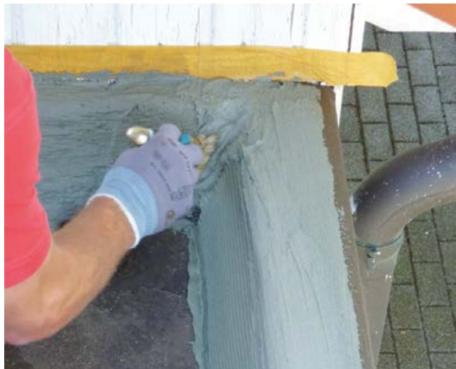
Abdichten einer Betonaufkantung an einem Dach.
