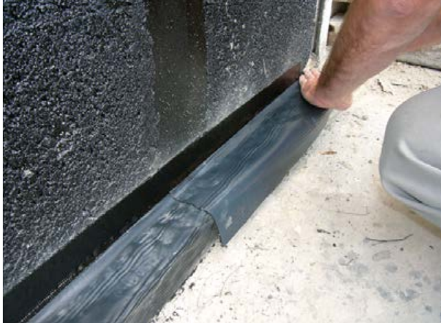
7 Die Teilstücke sind überlappend zu verkleben.
