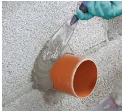
1 Zunächst wird eine Hohlkehle aus Sopro RAM3® Renovier- & Ausgleichsmörtel ausgebildet.
