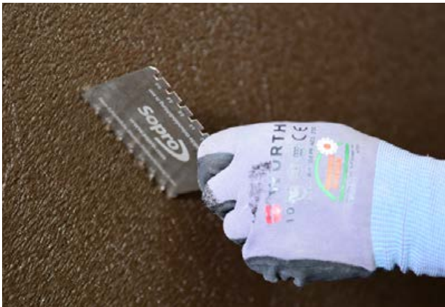
1 Die einzelnen Aufträge werden mit einem Schichtdickenmesser in ihrer Nassschichtstärke gemessen.
