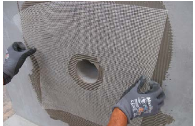
Eindichten der Durchdringung mit dem Abdichtstoff – mit Einlage eines Armierungsgewebes.
