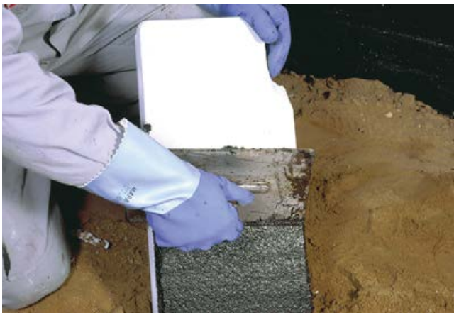
3 Zur Messung der Trockenschichtdicke wird eine Referenzprobe erstellt und unter Baustellenbedingungen gelagert. Der Durch-trocknungsgrad wird mit einem Keilschnitt durch das Material er-mittelt. Erst bei vollständiger Durchtrocknung dürfen die Dämm-oder Drainageplatten mit der Abdichtung verklebt werden.
