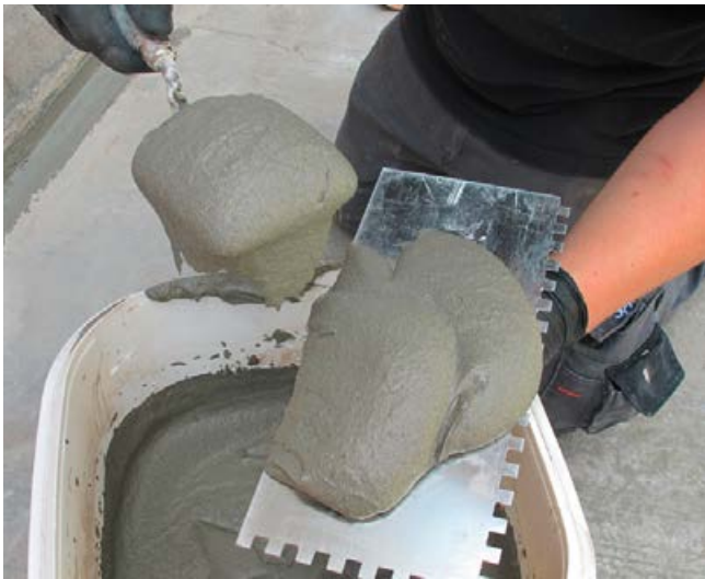
Sopro ZR Turbo MAXX steht fluffig auf der Kelle damit Lunker und Unebenheiten in dicker Schicht spachtelbar sind.
