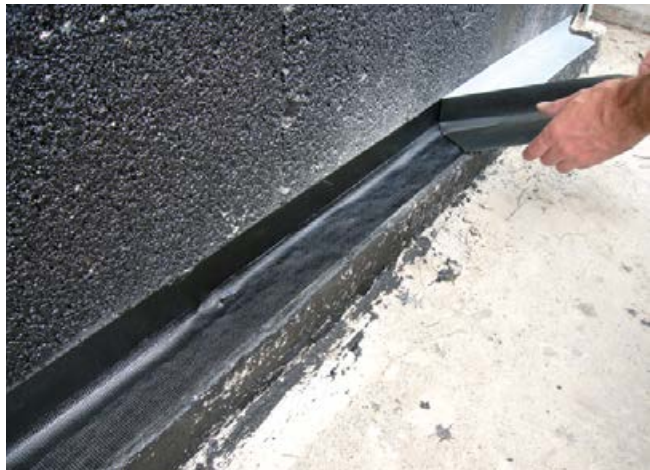
4 Abziehen der Schutzfolie vom Sopro-There® Klebeband (Verschweißungsband).
