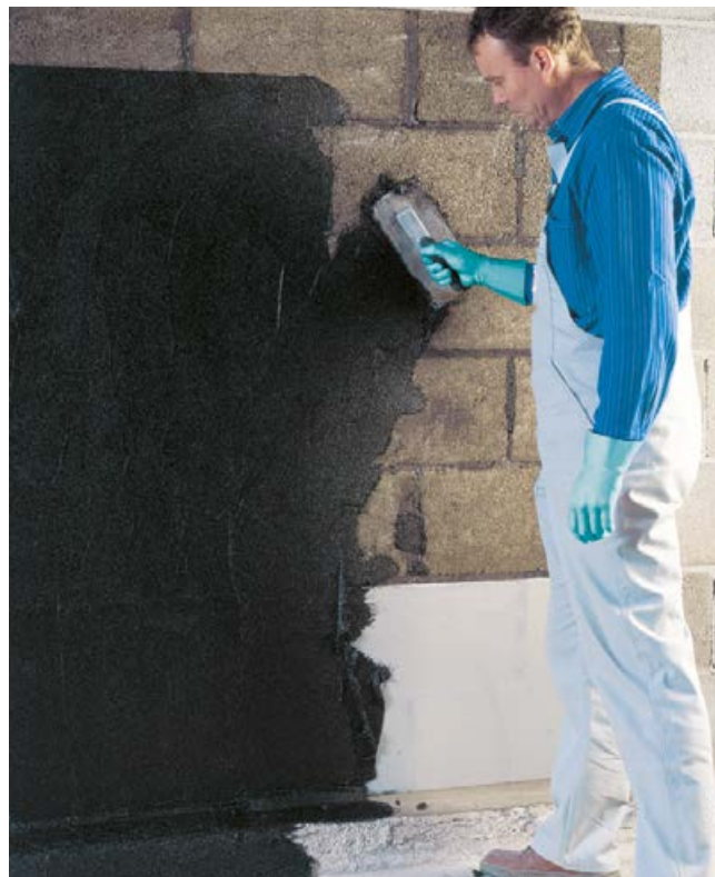
Auftrag der Dickbeschichtung (PMBC) auf der Kelleraußenwand.
