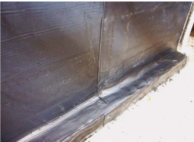
17 Abgedichtete Fläche mit Fußpunkt.a
