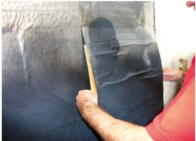
16 Ansetzen der nächsten Bahn.
