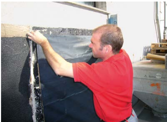
9 Ansetzen der SoproThene® an der Kellerwand.
