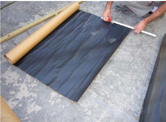
3 Zuschneiden der notwendigen SoproThere® Teilstücke.
