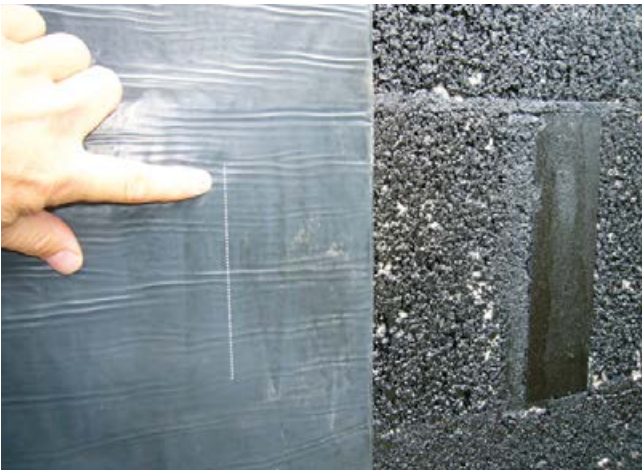
15 Arbeitserleichterung durch Überlappungsmarkierungen für die nächste Bahn.
