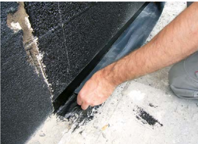
5 Aufkleben der SoproThere®-Teilstücke mittig auf dem SoproThere® Klebeband (Verschweißungsband).
