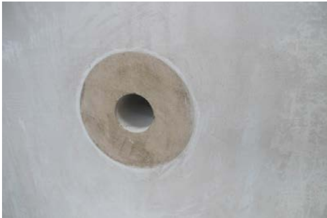
Wanddurchdringungsbauteil in der Wand eingemauert (System Doymar).
