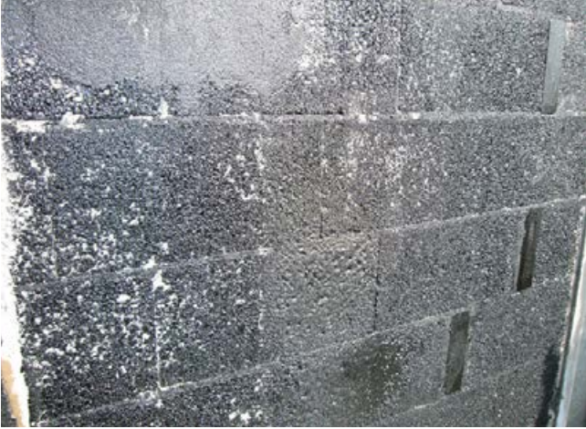
1 Wandfläche vorbereitet mit SoproThere® Voranstrich.
