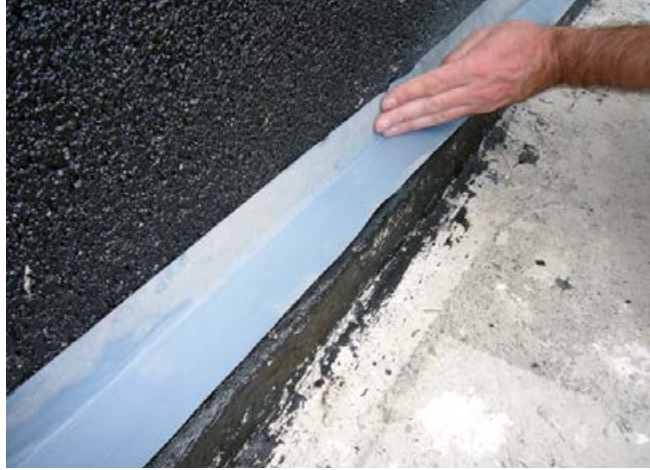
2 Aufkleben von SoproThere® Klebeband (Verschweißungsband) auf Innen- und Außenecken.
