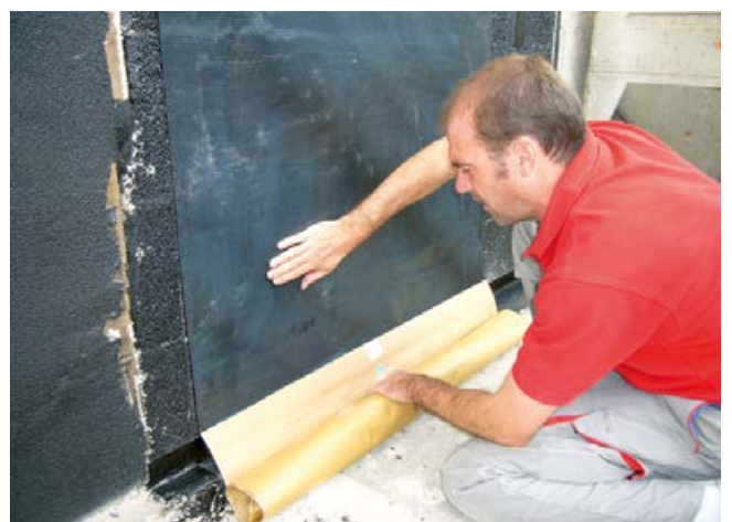
12 Andrücken der SoproThene® über die gesamte Wandfläche.
