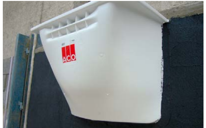
Kunststofflichtschacht (Firma ACO).
