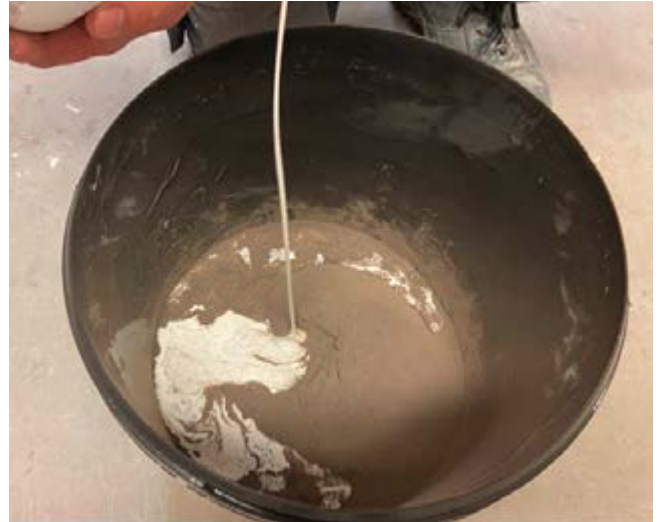
Zugabe der flüssigen Kunststoffdispersion zur Pulverkomponente.
