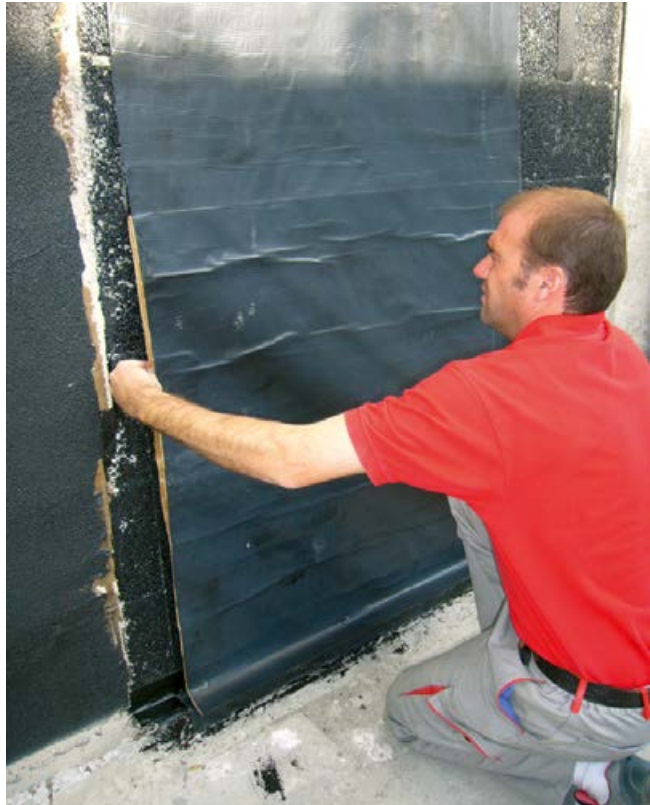
Abdichten eines Kellers nach DIN 18533 mit SoproThene® Bitumen-Abdichtungsbahn.
