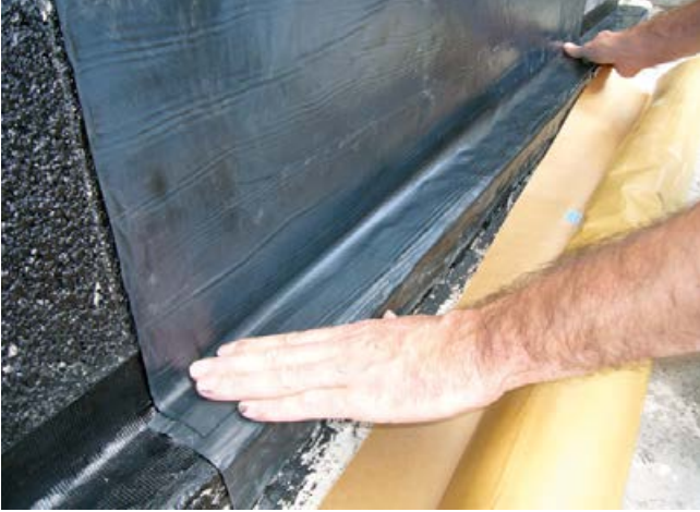
13 Schutzpapier vollständig entfernen und im Stoßbereich auf SoproThene® Klebeband (Verschweißungsband überlappend verkleben.
