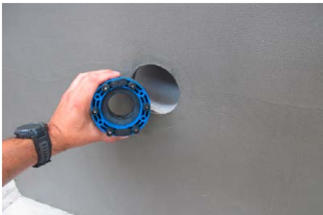
Fertig eingedichtete Durchdringung mit Einbauteil.
