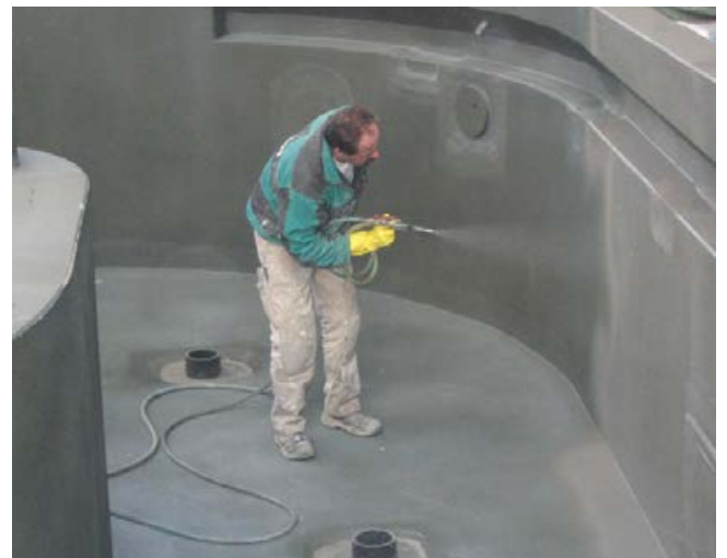
Abdichten eines Beckens im Spritzverfahren mit einer zementären flexiblen Dichtungsschlämme (z. B. Sopro DichtSchlämme Flex RS).
