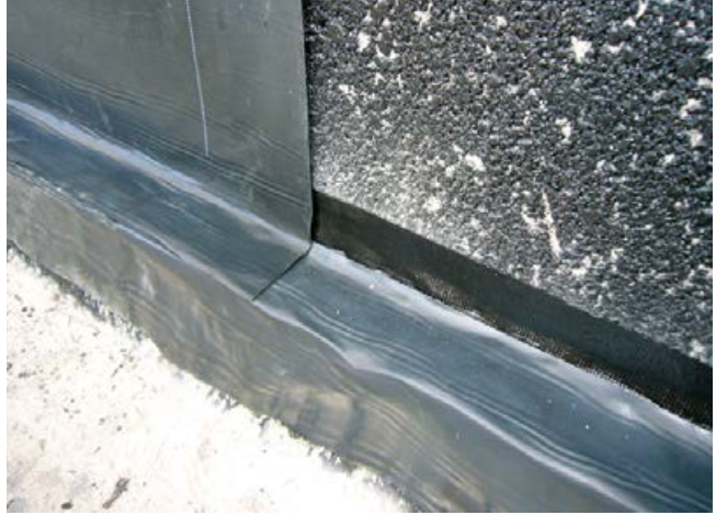
14 Stoßbereich ist durch SoproThene® Klebeband (Verschweißungsband) zusätzlich gesichert.
