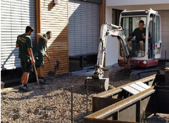
Einbau der ungebundenen Frostschutzschicht.
