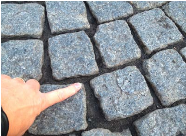
Die Fugen des alten Pflasters sind tief ausgespült und lassen sich schlecht begehen.
