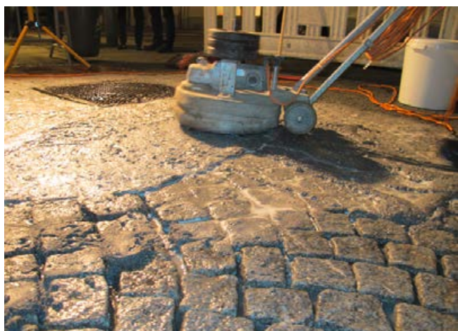
Durch das maschinelle Einbringen erhält der Fugenmörtel einen besonders guten Verdichtungsgrad.
