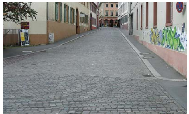
Speziell bei Endlosbauwerken (z. B. Straßen, Rinnen etc.) ist die Anordnung von Bewegungsfugen erforderlich.
