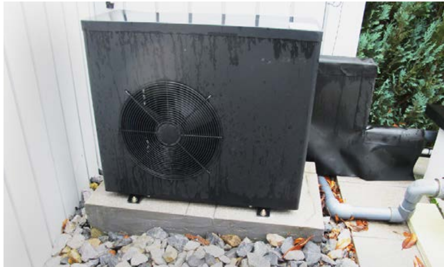
Fundament mit Wärmepumpe.
