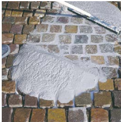
Fugenfüllendes Einbringen des Mörtels.
