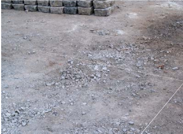
Kies-/Schotterschicht, verdichtet bei leichter bis mittlerer Beanspruchung.
