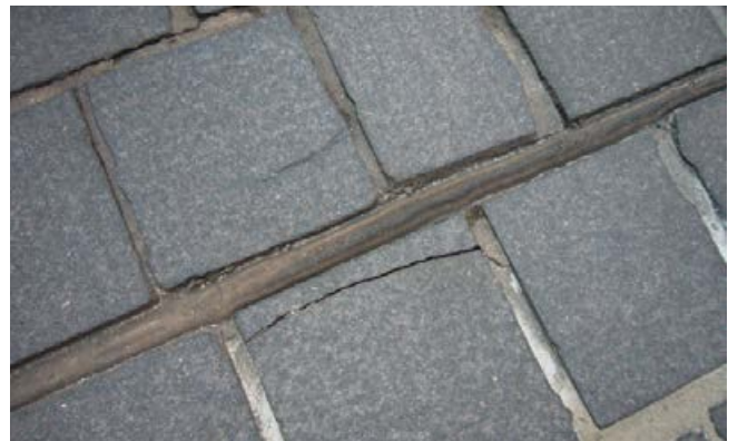
Pflasterreihen reißen ab, wenn sie kein Widerlager haben und bewegen sich Richtung Bewegungsfuge.
