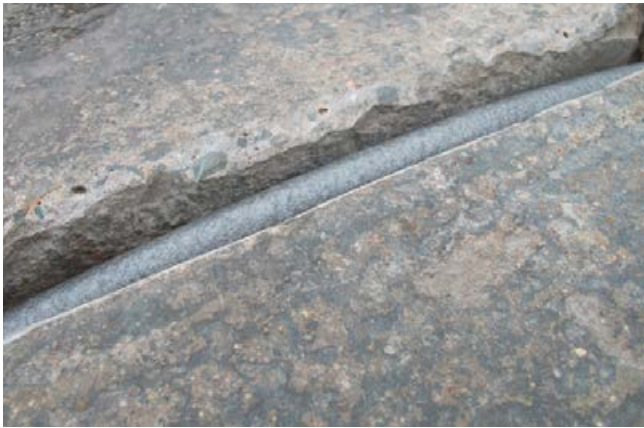
Einlegen der Hinterfüllschnur.
