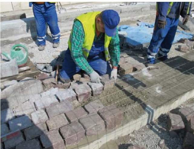
Versetzen der Naturwerksteinpflastersteine im Verbund auf dem Balkenfundament.
