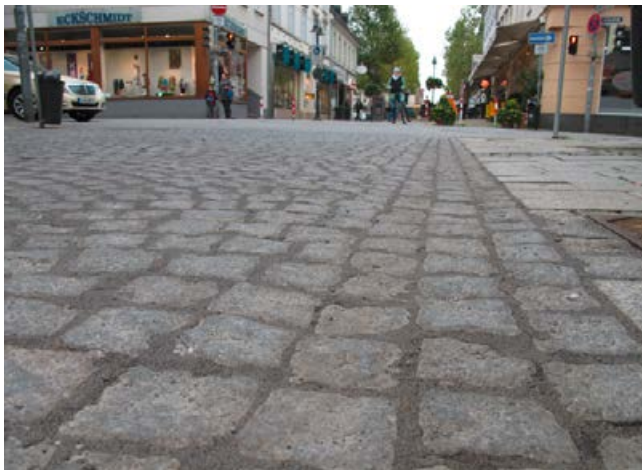
Nach Abschluss der Arbeiten ist die Pflasterfläche oberflächenbündig geschlossen, ist wartungsarm und lässt sich angenehm begehen.
