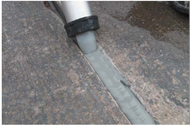
Einbringen des Dichtstoffs (Sopro PU-Dichtstoff).
