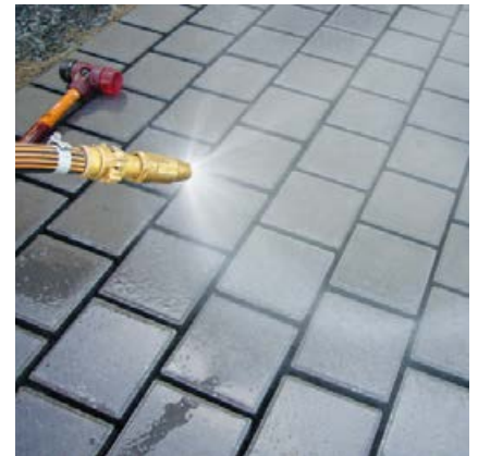
Betonsteinpflaster gut vornässen.
