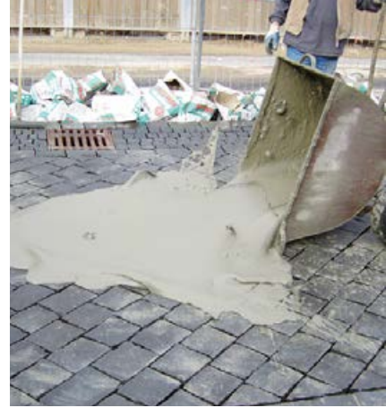
Leichtes Verfüllen der Fugen aufgrund hervorragender Verlaufeigenschaften des Fugenmörtels.
