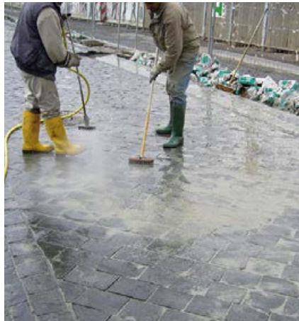
Reinigung mittels Sprühlanze.
