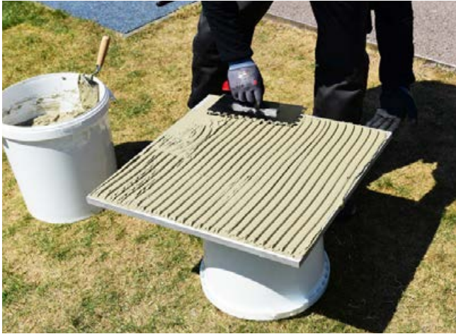
Kleber (z. B. Sopro's No.1) wird auf der Plattenrückseite aufgetragen.
