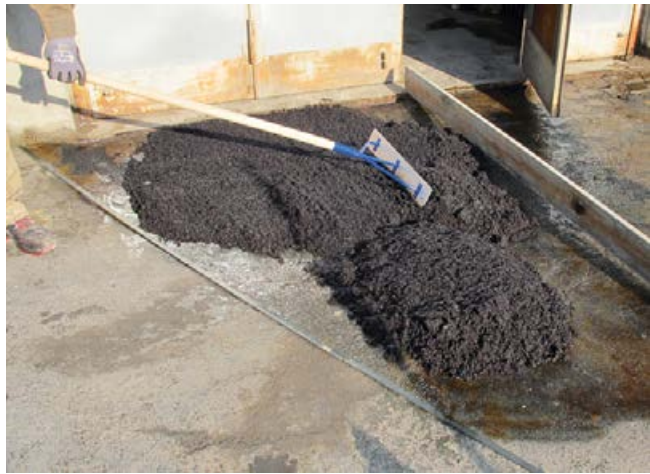
Der KaltAsphalt wird aufgetragen ...
