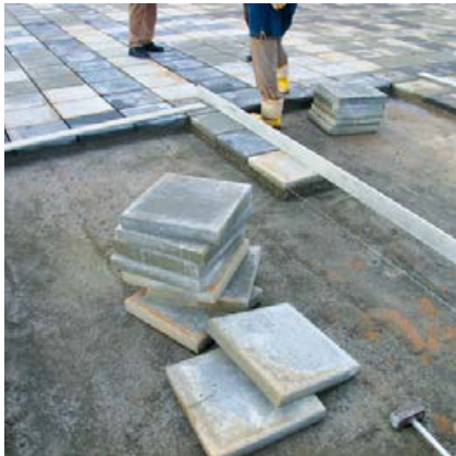
40x40 cm Betonplatten im Dickbett auf einer Tragschicht verlegt.
