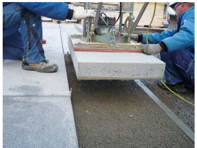
Für die Gestaltung von Plätzen werden heute neben Naturwerksteinplatten auch großformatige Betonplatten verwendet.
