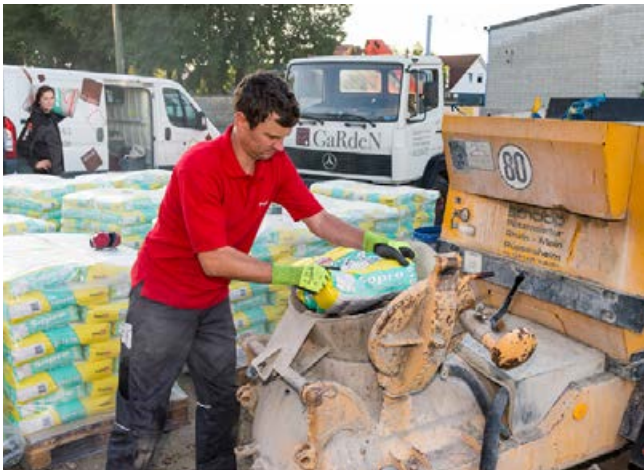
Anmischen des Sopro DrainageMörtels für die Bettungsschicht mittels Estrichpumpe.
