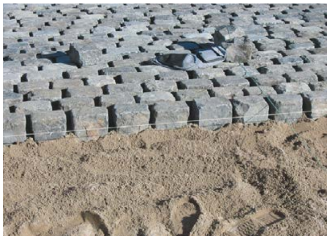
Pflastersteinverlegung mit ungebundenem Unterbau, versetzt im Sand-Kiesbett.
