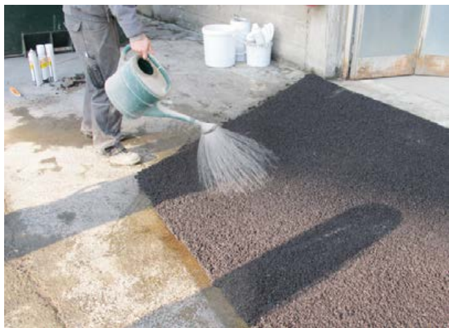
Vor dem Verdichten wird die Fläche mit Wasser befeuchtet.
