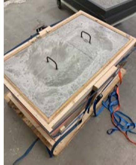
Aushärten in der Schalung.
