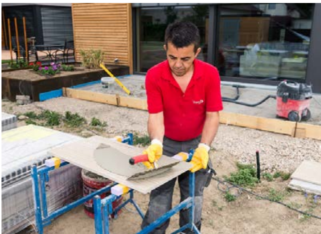
Aufkämmen von Sopro megaFlex S2 Flexkleber auf der Rückseite der Platte für die Verlegung im Buttering-Verfahren.
