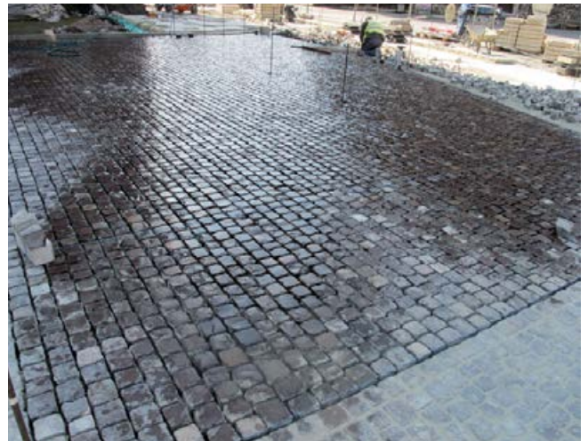
Straßenbereich, befestigt mit Naturwerksteinpflaster.
