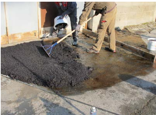
... und etwas überhöht auf der Fläche verteilt.
