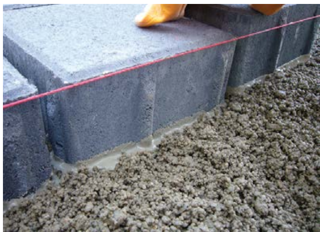
Optimaler Haftverbund zwischen Bettungsmörtel (Sopro DrainageMörtel) und Pflasterstein durch den Einsatz von Sopro HaftSchlämme Flex.
