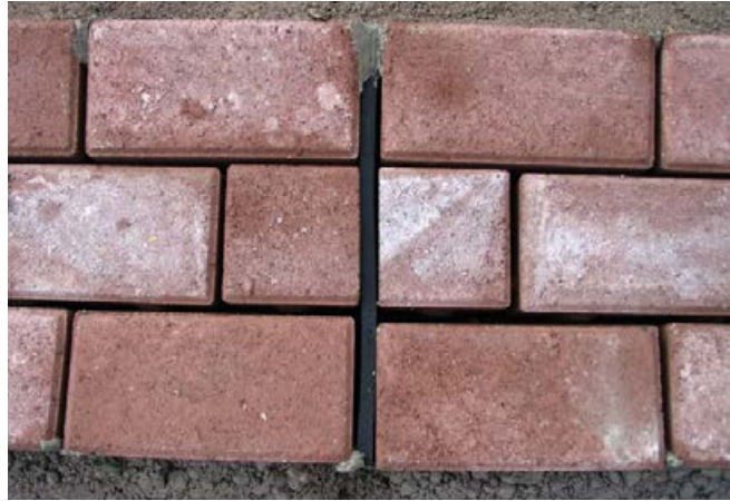
Eingebaute Gummischeibe bei Betonpflasterbelägen als Bewegungsfuge.
