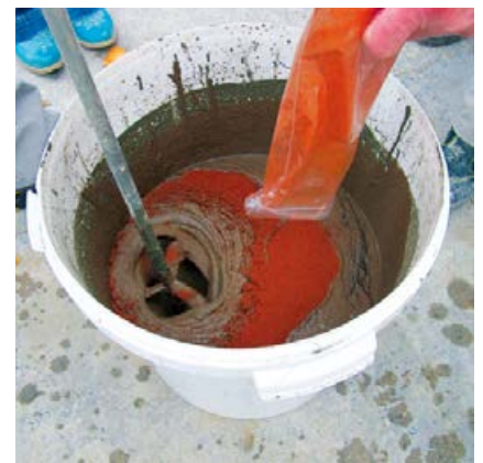
Durch Zugabe von Pigmenten lässt sich die Sopro BetonSteinFuge verschiedenfarbig einstellen.
