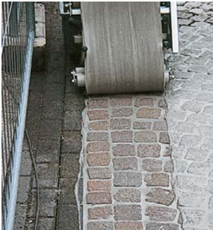
Großflächenreinigung mit Abwaschmaschine.
