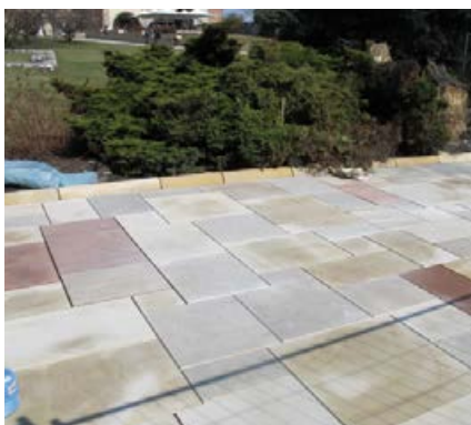
Großformatige Naturwerksteinplatten in gebundener Bauweise verlegt.
