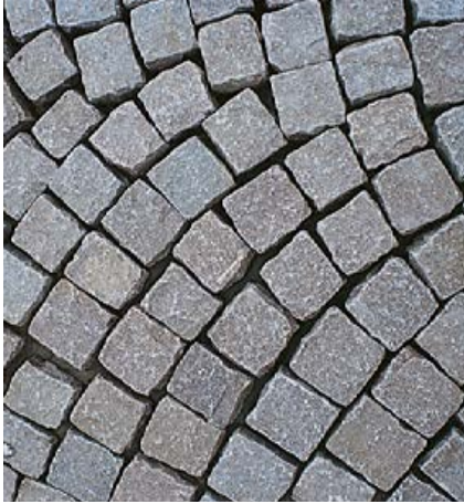
Naturwerksteinpflaster mit unterschiedlichen Fugenbreiten, bedenkenlos verfüllbar mit Sopro PflasterFugMörtel hochfest.
