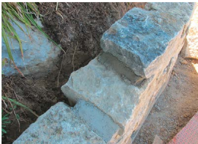
Mittels Kelle oder Fugeisen läßt sich der Trassmörtel gut modellieren und verdichten.
