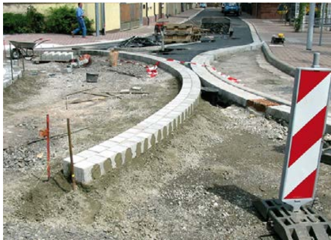
Betonpflastersteine als Rinnenbauwerk versetzt auf einem Betonfundament.
