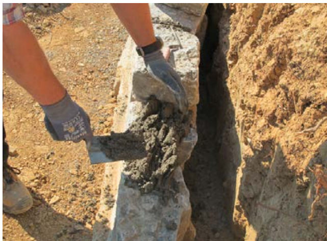
Dieser ist klebrig und sehr standfest um die zum Teil sehr schweren Steine beim Vermauern zu halten.
