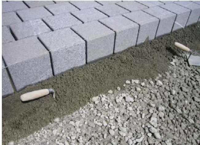
Granitpflastersteine versetzt in drainefähigem Bettungsmörtel auf einer grobkörnigen, wasserdurchlässigen gebundenen Tragschicht.
