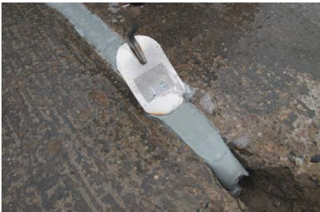
Glätten des Dichtstoffs mittels Glättmittel und entsprechendem Werkzeug.
