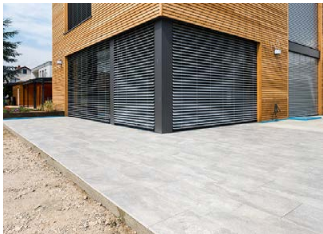
Verlegter Belag, bereit für die Verfugung mit Sopro FlexFuge plus.
