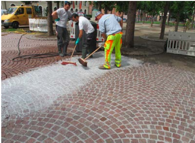
Nach einer kurzen Abbindezeit des Fugenmörtels wird der Überschuss mittels Besen von der Pflasteroberfläche entfernt.
