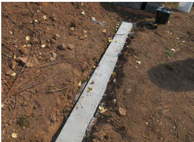
Vorbereitete Fundamente für die Gartenmauer.
