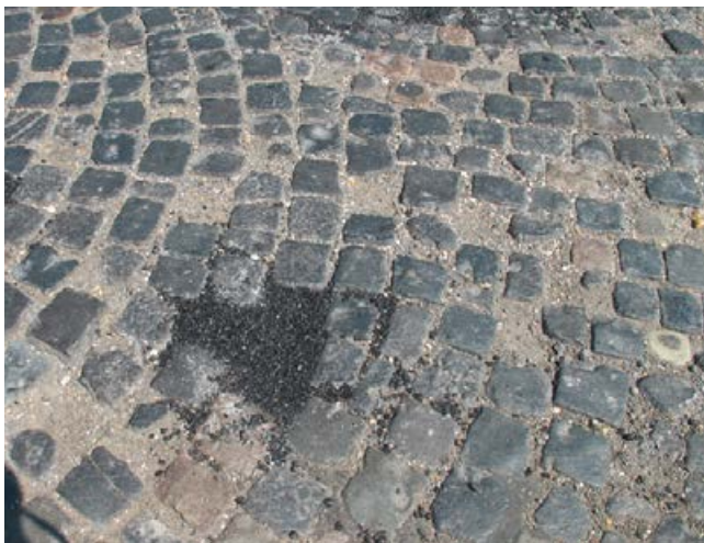
Sopro KaltAsphalt zum Auffüllen von schadhafte Pflasterflächen.
