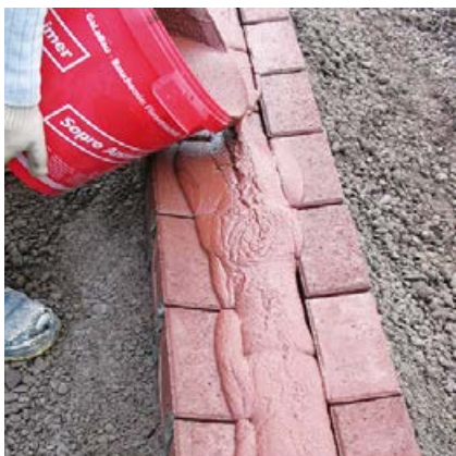
Sopro BetonSteinFuge lässt sich auf der Baustelle durch Pigmentzugabe farblich auf den Betonpflasterstein abstimmen.
