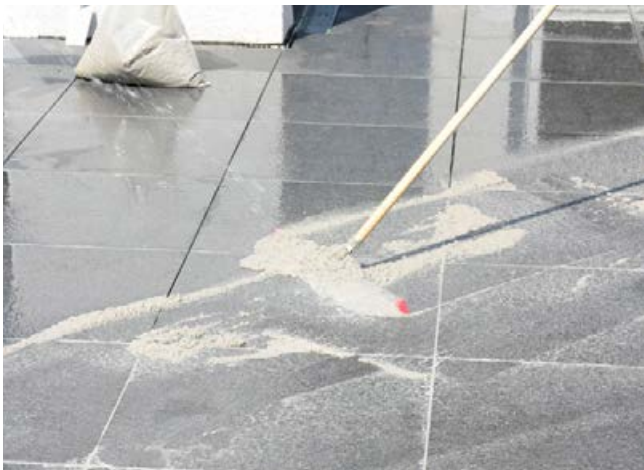
Leichtes Verfugen der Sopro Solitär® F20 mittels Wasserschlauch und Gummischieber.
