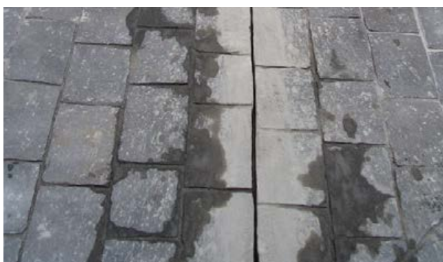
Bewegungsfuge im Pflasterbelag.
