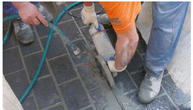
Einschneiden einer Bewegungsfuge in den Straßenbelag einige Tage nach dem Verlege- und Verfugungsprozess.
