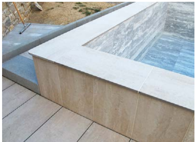
Elastische Fugen an den Plattenenden sind zu beachten.
