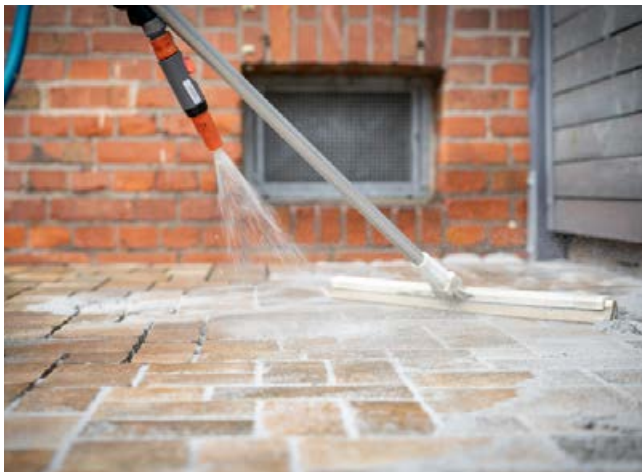
Leichtes einspülen des Fugenmörtels mittels Wasserschlauch und Gummischieber in die Fuge.
