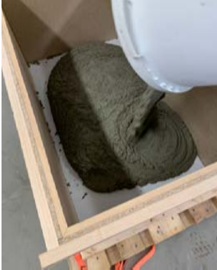
Einfüllen des Mörtels in die Schalung.
