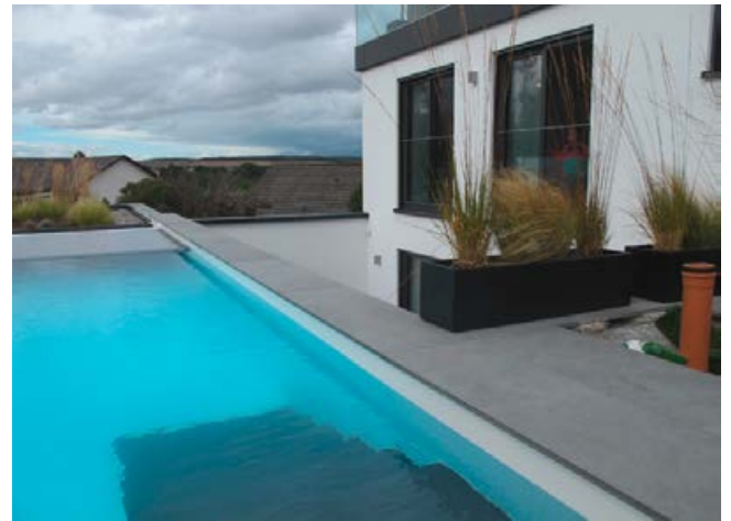
Einfassung eines Folien- oder GFK-Pools mit Naturstein- oder Keramik-Platten.
