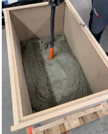
Verdichten des Mörtels mit einer Rüttelflasche.
