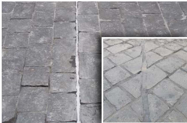
Bewegungsfugen mit Sopro PU-Dichtstoff oder Sopro TurboDichtSchlämme 2-K.
