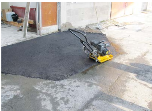
Die fertige Fläche kann unmittelbar nach dem Verdichten begangen werden.
