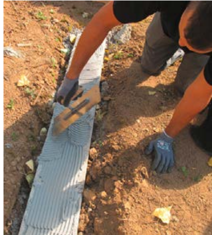
Auftrag des Klebers (Sopro DünnBettEpoxi) mit einer Zahnkelle.
