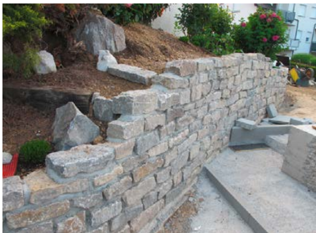
Je nach Höhe der Mauer und dem Druck aus dem Gelände kann es notwendig sein, die Mauer rückwärtig mit Stützbeton zu verstärken. Eine Abdichtung mit Sopro ZR Turbo MAXX ist vor dem Verfüllen ebenfalls aufzutragen.
