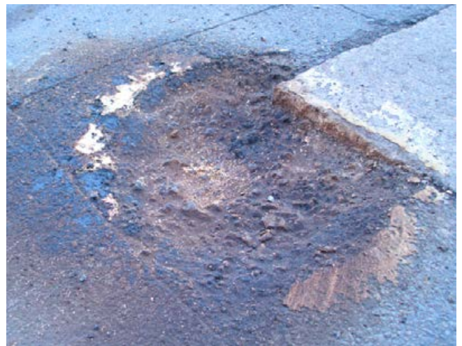
Übliche Schäden an unseren Straßen nach einem langen Winter oder hohen Verkehrsbelastungen.
