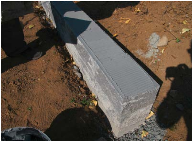
Auftrag des Klebers (Sopro DünnBettEpoxi). Die vordere Zone (1–1,5 cm) bleibt frei, um die Steinfront nicht zu verschmutzen.
