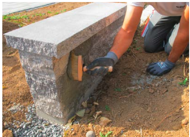
Nach der Aushärtung der Vermörtelung ist die Mauer rückwärtig abzudichten (Sopro ZR Turbo MAXX). Vor dem Beifüllen ist das Sopro Keller DrainSystem als Schutzschicht aufzustellen.
