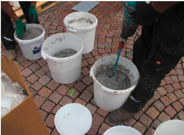
Anmischen des zweikomponentigen, hochfesten, harzgebundenen Fugenmörtels Sopro HF® EpoxiPflasterFuge.
