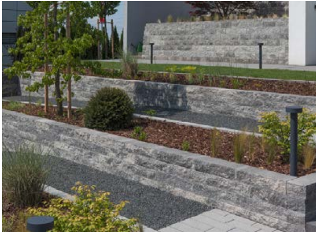
Aufgrund ihrer Maßhaltigkeit können Betonsteine (z. B. RINN Toskana Mauer) im Dünnbettverfahren geklebt werden.
