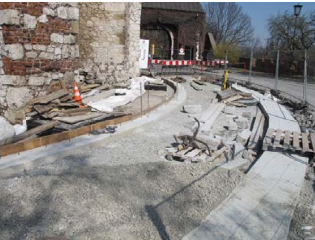
Betoniertes und armiertes Rinnenfundament an einer Straße.
