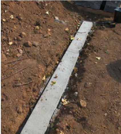
Fundament für den Maueraufbau.
