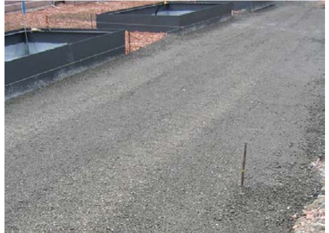
Gebundene Tragschicht (Beton), verdichtet für mittelschwere bis schwere Beanspruchung.
