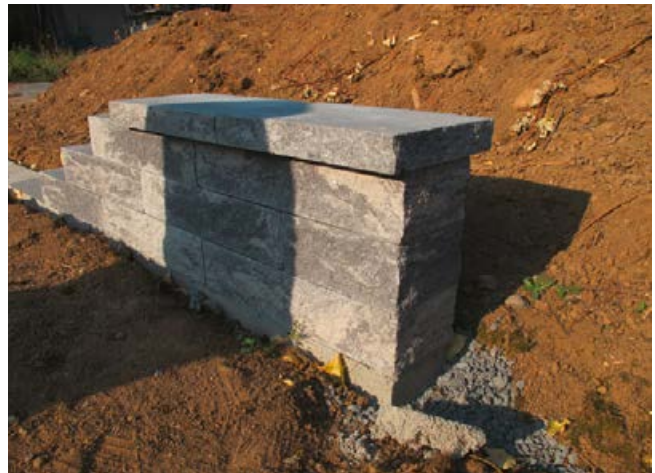
Mauer mit Abdeckung.
