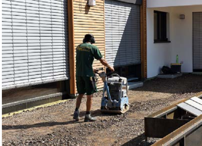
Verdichten der ungebundenen Trag- und Frostschutzschicht.
