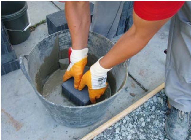
Auftragen der Haftbrücke mittels Eintauchen des Steins in die Sopro HaftSchlämme Flex.
