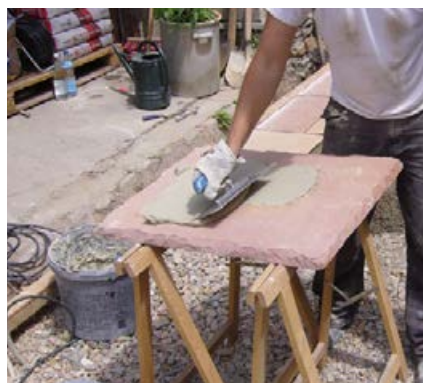
Speziell bei großen Platten ist das Auftragen einer Haftbrücke und das Arbeiten „frisch-in-frisch“ entscheidend für die Langlebigkeit der Konstruktion (Haftbrücke z. B. Fliesenkleber Sopro's No.1).
