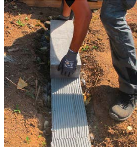
Versetzen der Steine.
