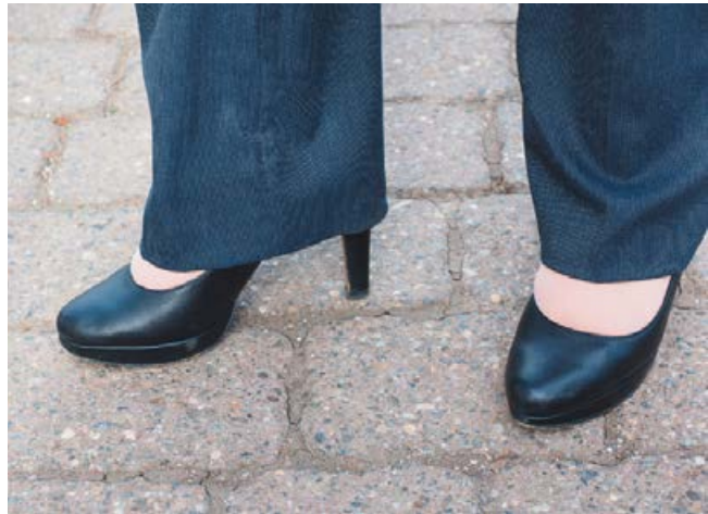
Je nach Schuh bleibt man in den leeren Fugen hängen oder stolpert.
