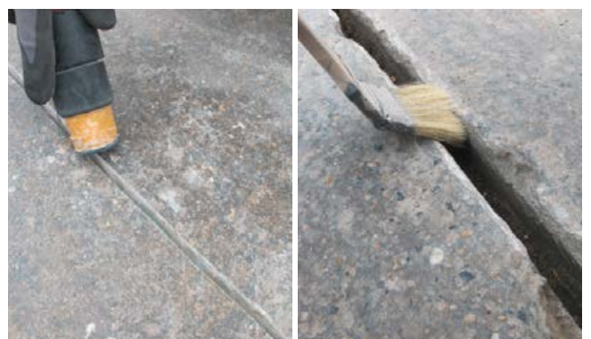
Reinigung der Fuge mittels Staubsauger und Pinsel.
