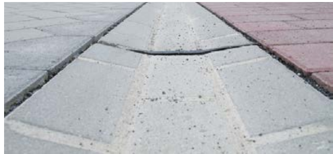
In vielen Fällen werden Straßenrinnen heute aus Betonpflasterformsteinen hergestellt.
