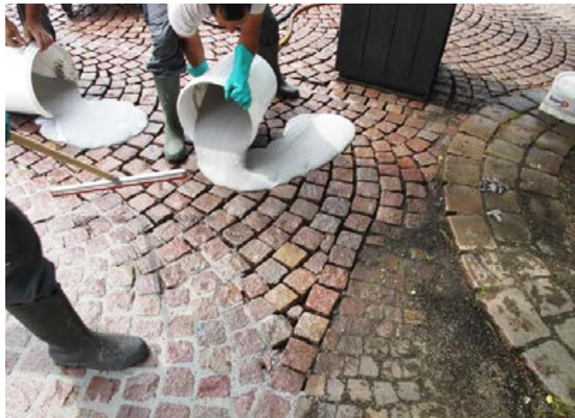
Ausgießen und Einbringen des leichtgängigen Fugenmörtels Sopro HF® EpoxiPflasterFuge ...
