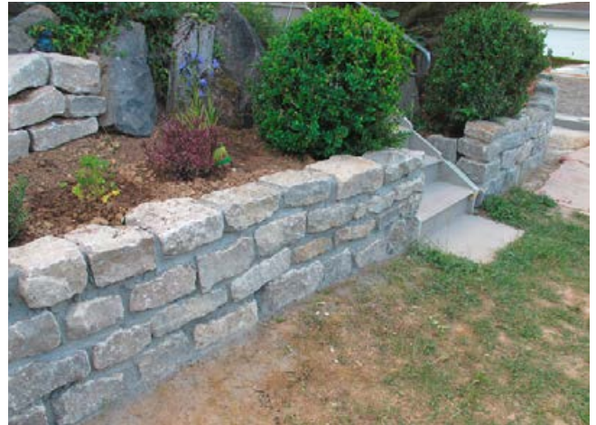
Die Natursteine sind mit Sopro TrassVerlegeMörtel, welcher entsprechende Fugenbreiten erlaubt und unterschiedliche Steindicken ausgleicht, zu verarbeiten.
