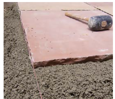
Verlegte Naturwerksteinplatte im entsprechend dick dimensionierten Bettungsmörtel.
