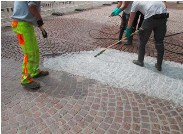
... mittels Gummischieber in die offene Fuge.
