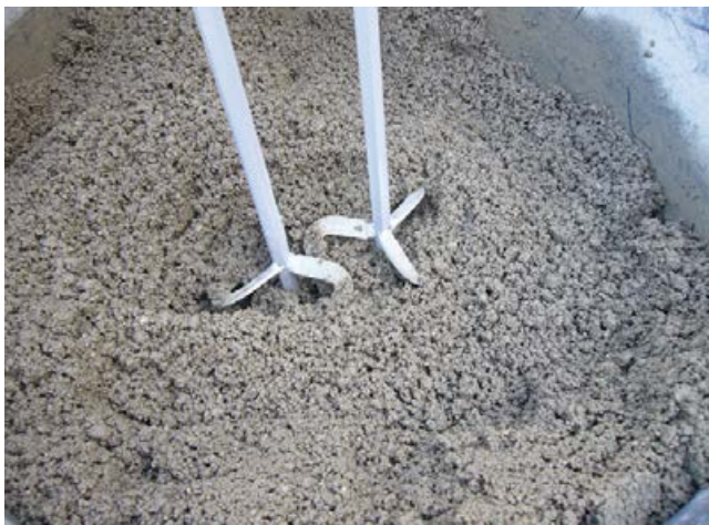
Anmischen des drainagefähigen Bettungsmörtels mit Quirl oder Zwangsmischer.
