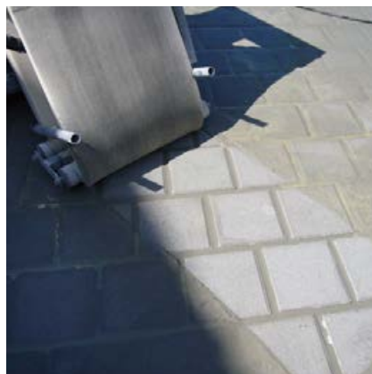
Einfaches Reinigen der Fläche mittels Schwamm- bandmaschine.
