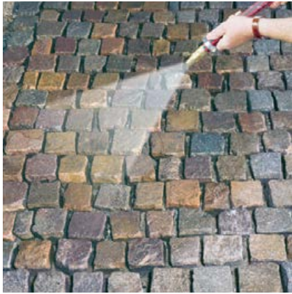
Vornässen des gereinigten, zu verfugenden Belages.
