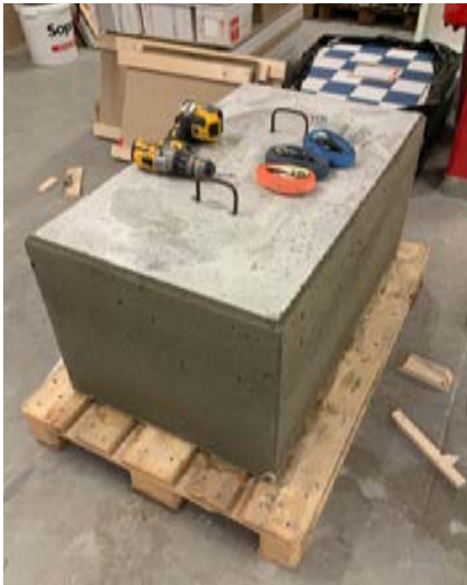
Ausgeschalt, bereit für den Transport zum Aufstellort, z. B. einer Wärmepumpe. Natürlich kann das Fundament auch direkt beim Aufstellort hergestellt und an die notwendige Gerätegröße angepasst werden.
