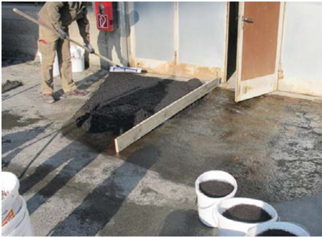
Herstellen einer Zufahrtsrampe.
