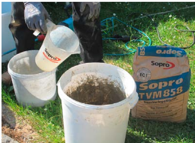
Der Verlegemörtel ist in einer steifplastischen Konsistenz anzumischen.
