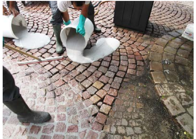
Gut ist das Fließverhalten des Fugenmörtels zu erkennen.
