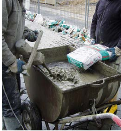
Anmischen des Fugenmörtels mittels Rührgerät.
