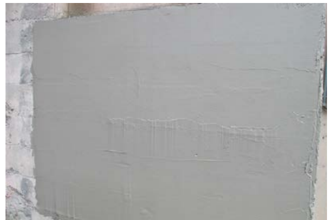
Der Betonspachtel lässt sich leicht verarbeiten. Kiesnester und blasige Strukturen im Beton lassen sich mit dem Betonspachtel schließen. Zum Schluss entsteht eine gleichmäßige Betonoberfläche.
