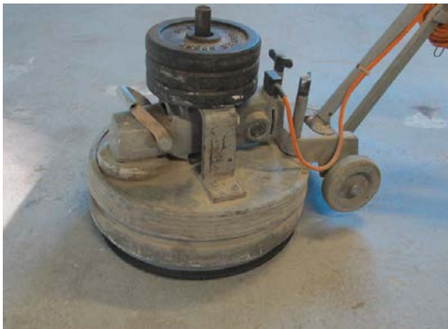
Untergrundvorbereitung ggf. durch Schleifen/Fräsen.
