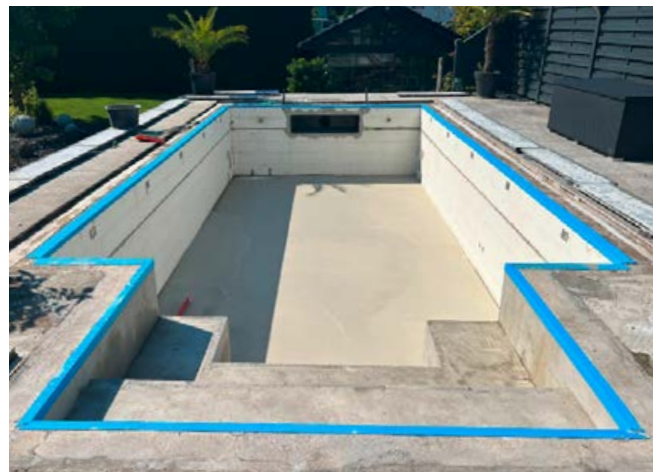
Fertiger Pool – planeben ausgeglichen für die Folienmontage.
