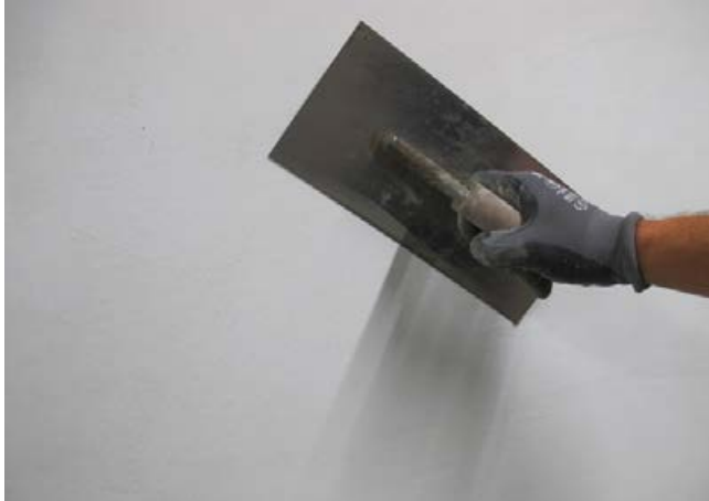
Verspachteln von Sopro MultiGlättSpachtel als Endfinish.
