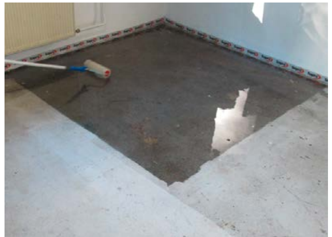
Grundieren der Fläche mit Sopro EpoxiGrundierung.
