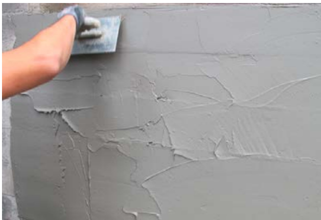
Der Betonspachtel lässt sich leicht verarbeiten. Kiesnester und blasige Strukturen im Beton lassen sich mit dem Betonspachtel schließen. Zum Schluss entsteht eine gleichmäßige Betonoberfläche.
