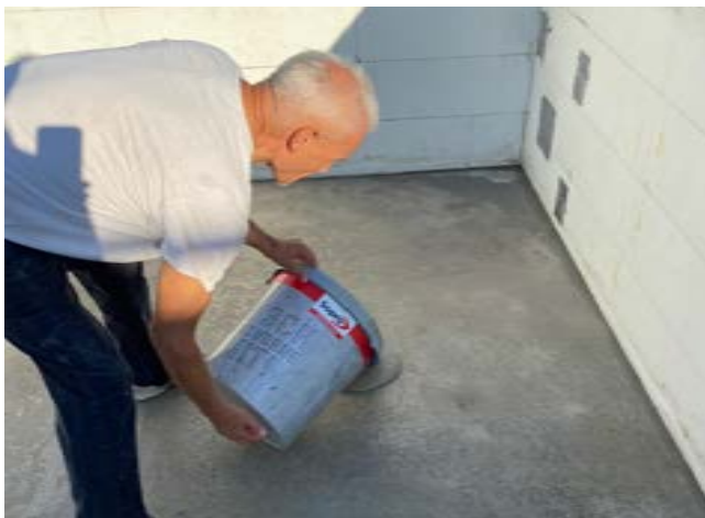
Einbau von Sopro Hydrodur® FS Fließspachtel in einem Pool zur Aufnahme einer Folie.
