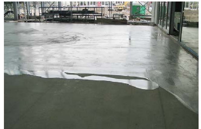
Die Harzgrundierung verfestigt die Oberfläche entscheidend und sperrt diesen je nach Produktwahl und Auftragsmenge ab.
