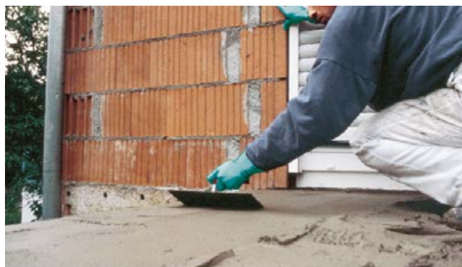
Herstellen einer Gefällespachtelung mit Sopro RAM 3® Renovier- & Ausgleichsmörtel auf einer Balkonkragplatte.
