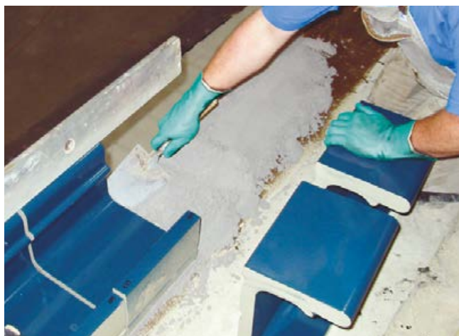
Versetzen von Beckenkopfsteinen mit Sopro EpoxiMörtel.
