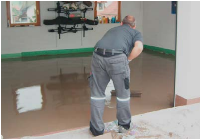
Einbau des Sopro Hydrodur® FS in einer Garage.
