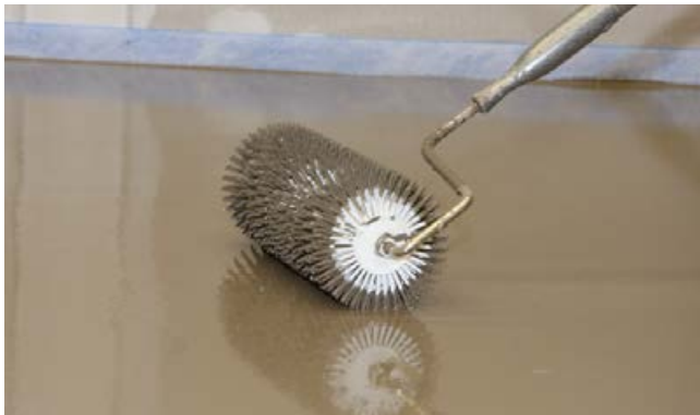
Verteilung und Entlüftung von Sopro VarioFließspachtel mit einer Stachelwalze auf Holzdielenuntergrund.
