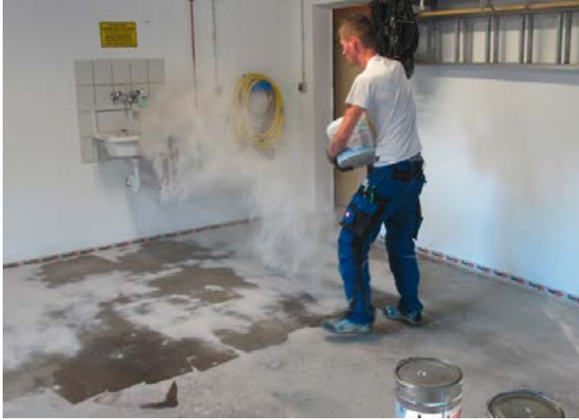
Absanden der Sopro EpoxiGrundierung im Überschuss.
