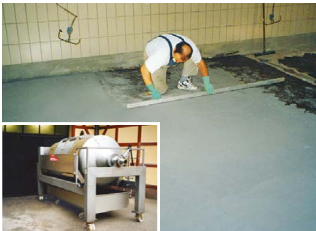
Hochfeste Epoximörtel-Spachtelung zur Aufnahme hoher beweglicher Punktlasten.
