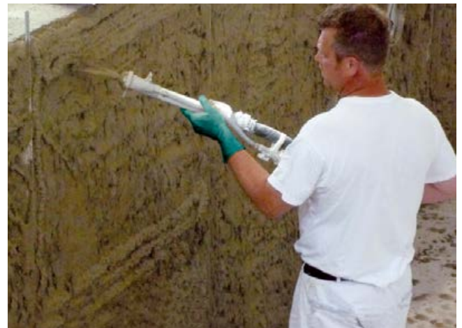
Für die großflächige Anwendung ist Sopro SchwimmBadPutz auch mit der Maschine verarbeitbar.
