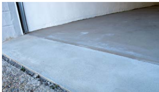
Spachteln von Anrampungen, Garagenböden und Werkstatt mit Sopro RAM 3® Renovier- & Ausgleichsmörtel.
