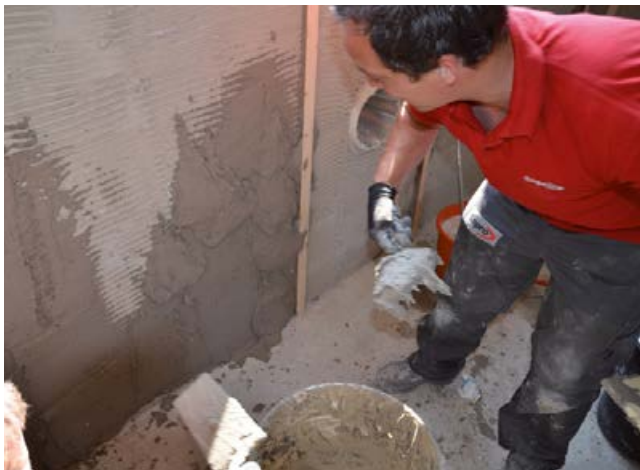
Sopro SchwimmBadPutz lässt sich leicht mit der Hand verarbeiten. Auf Beton wird zuvor eine Fliesenkleberkratzspachtelung (z. B. mit Sopro's No.1) aufgebracht.
