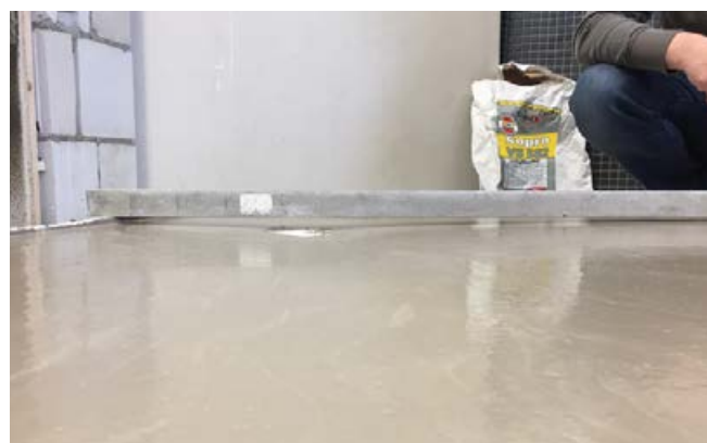
Gefällefläche, hergestellt mit VarioFließspachtel.
