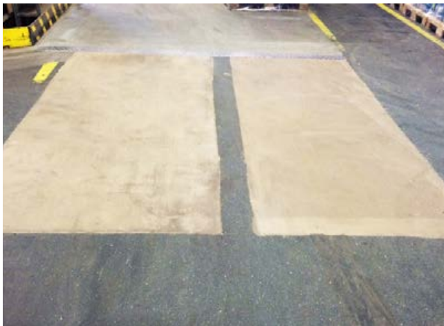
Sopro Fließspachtel hochfest HF-S widersteht höchsten Belastungen und kann aufgrund seiner Schnellerhärtung auch für partielle Sanierungen eingesetzt werden.
