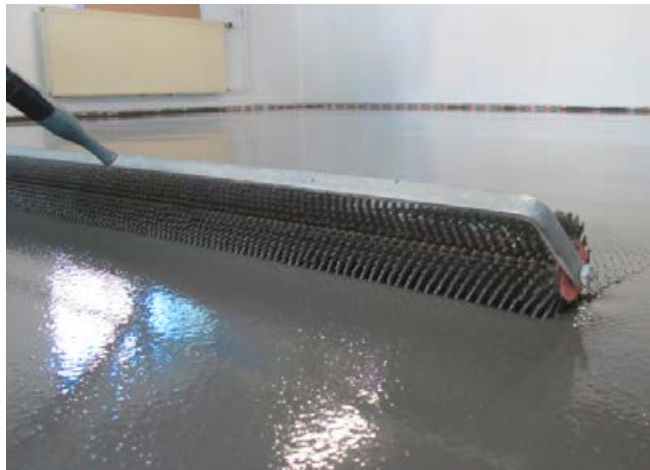
Zum Verteilen und Verdichten kann ambiente® floor mit einer Stachelwalze bearbeitet werden.
