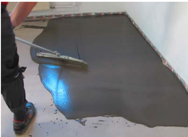
Verteilen von ambiente® floor in der Fläche mittels Raket.
