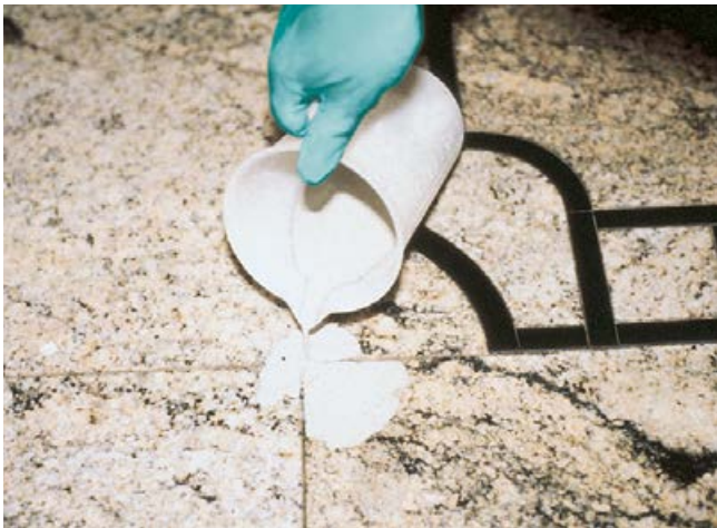
Verfüllen über eine offene Fuge.
