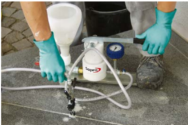
Verpressung mit Injektionspresse (ca. 10 bar).
