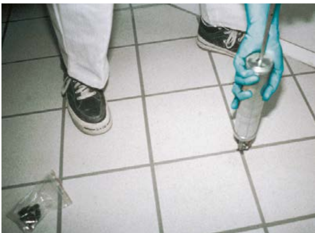
Verpressen mit Handpresse für kleine Flächen.
