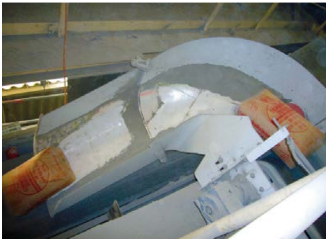
Edelstahlrinnen, welche zur Förderung von Zementsäcken Verwendung finden, werden mit hochfesten keramischen Belägen ausgekleidet. Die Keramik steht in direktem Kontakt zum Stahl, die Verklebung erfolgt mit Sopro PU-Kleber.
