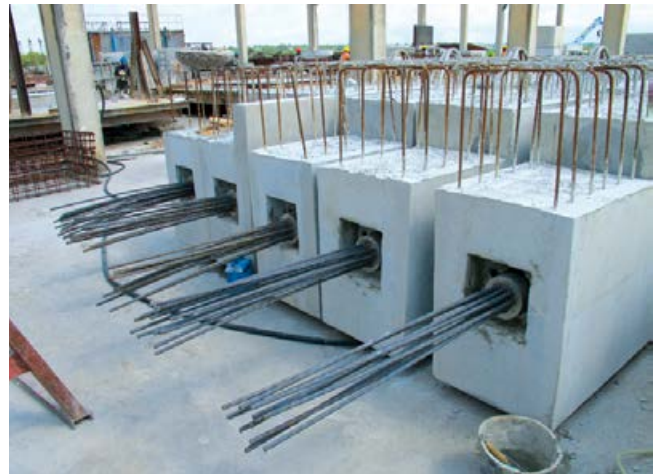
Stahl, ein wichtiger Baustoff, ohne den das Bauen heute nicht mehr denkbar wäre.
