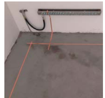
Angeschlossenes Kupferband an die Potenzialausgleichsschiene.
