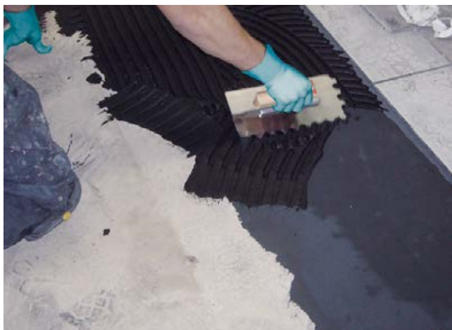
5 Verlegen der Keramik mit leitfähig eingestelltem Dünnbettmörtel.
