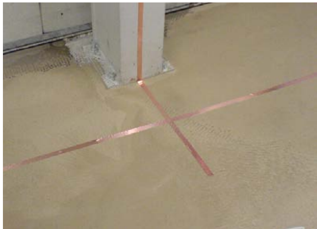
4 Kupferbandverlegung an aufgehendem Bauteil für späteren Anschluss am Potenzialausgleich.
