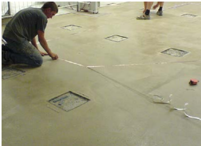
3 Aufkleben der Kupferbänder mit entsprechendem Rastermaß.
