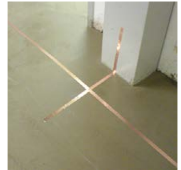
Verlegte Kupferbänder auf der Bodenfläche.
