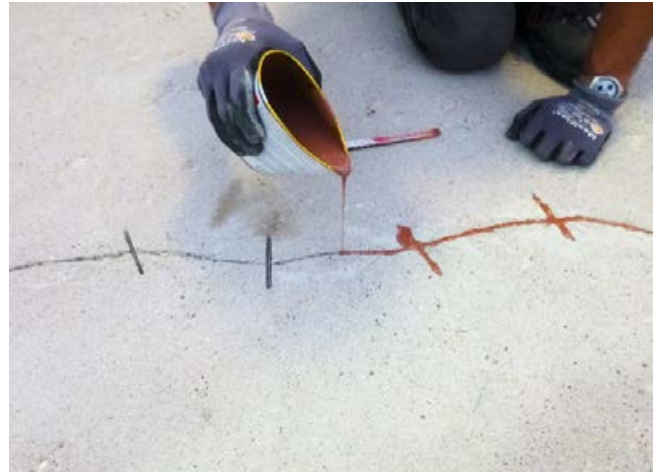
Eingießen des Reaktionsharzes (Sopro Gießharz) zur Herstellung einer kraftschlüssigen Verbindung zwischen den beiden Estrichteilstücken.
