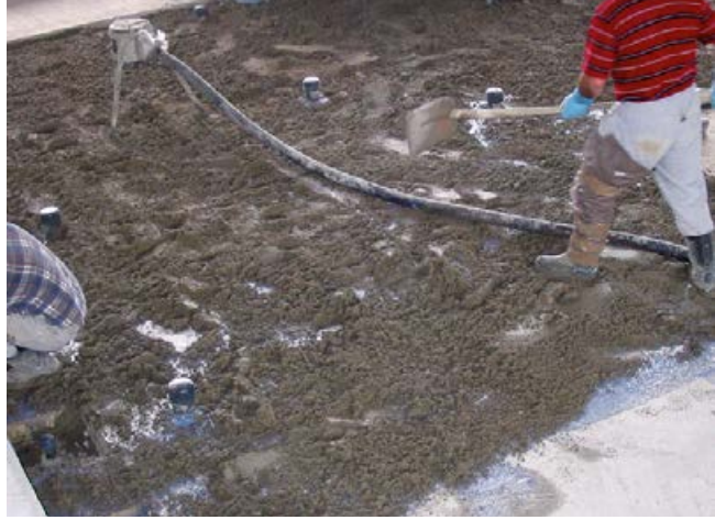
Zementestriche werden in erdfeuchter Konsistenz verarbeitet.
