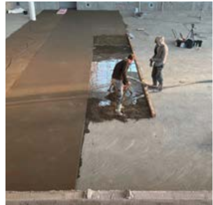
Epoxihaftbrücke für einen Verbundestrich.
