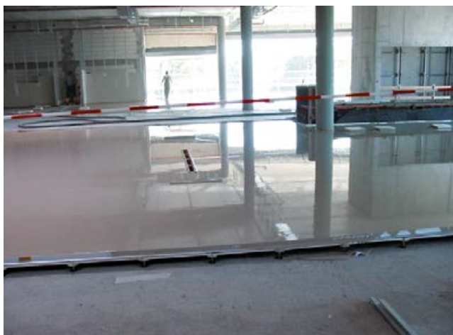
Calciumsulfatgebundener Fließestrich auf einer aufgeständerten Bodenkonstruktion eingebaut.
