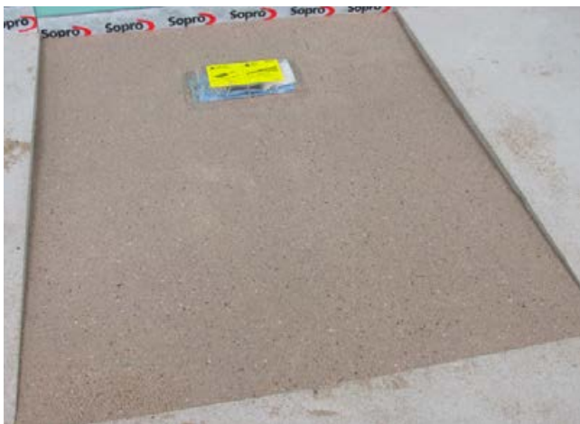
Duschfläche mit Reaktionsharzestrich.
