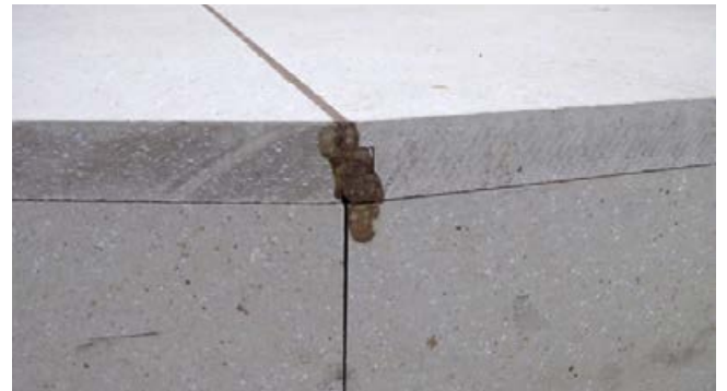
Trocken-Hohlbodenaufbau im Bereich einer Treppe.
