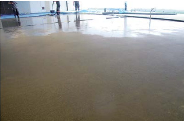
Mit Sopro Rapidur® FE lassen sich schnell abbindende und planebene Estriche herstellen, welche die Großformatverlegung von keramischen Platten vielfach erleichtern.
