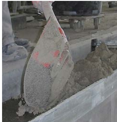
Einbringen des Estrichmörtels (Sopro Rapidur® M5) „frisch-in-frisch“ in die zuvor aufgetra- gene Sopro EpoxiGrundierung.
