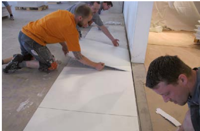
Wenige Stunden nach Einbau des zementären, schnell erhärtenden Fließestrichs Sopro Rapidur® FE ist die Großformatverlegung im Dünnbett ohne ein weiteres Ausgleichen möglich.
