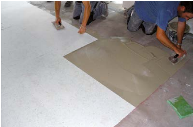
Verlegung einer Entkopplung mit einem Flexkleber auf einer Hohlbodenkonstruktion.
