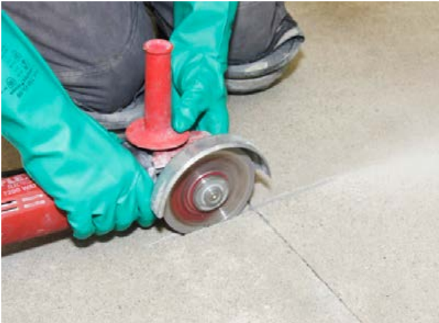
Öffnen der Risse mittels Winkelschleifer.
