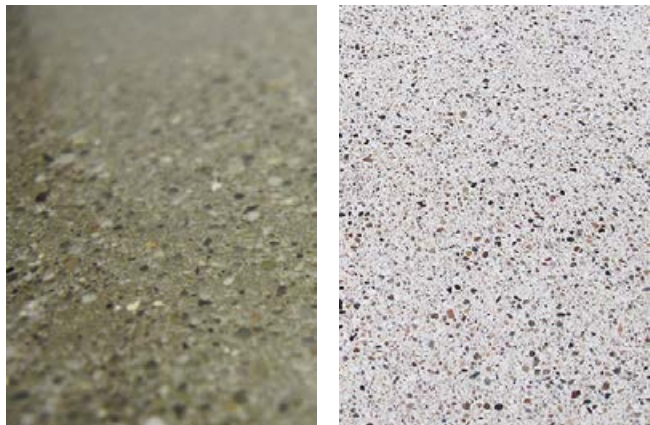
Durch das Schleifen und Polieren entsteht eine geschlossene, optisch ansprechende Terrazzo-Oberfläche. Diese ist in zwei Farben herstellbar – in grau und in weiß mit Rapidur® FE Fließestrich weiss.
