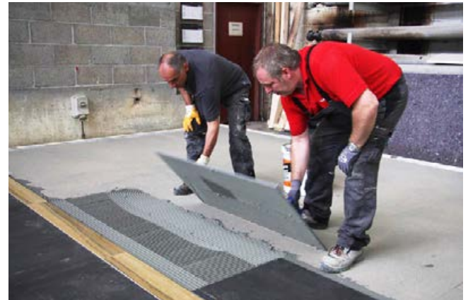
Die Platten werden im kombinierten Verfahren verlegt, d.h. auf der Plattenrückseite ist ebenfalls Kleber aufzutragen.
