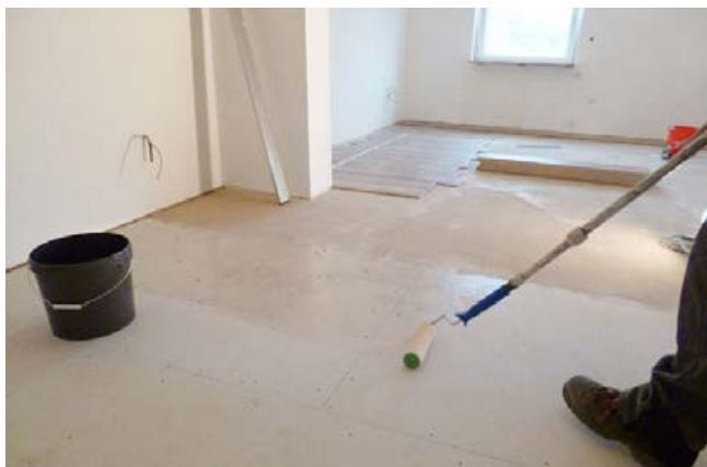
Auftrag der Reaktionsharzgrundierung mittels Rolle.
