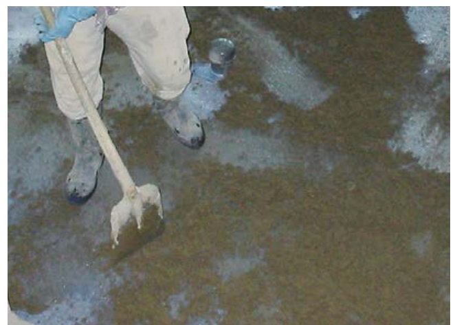
Einbau eines Verbundestrichs: Einarbeiten eines Estrichmörtels in die frisch strahlte Haftbrücke.
