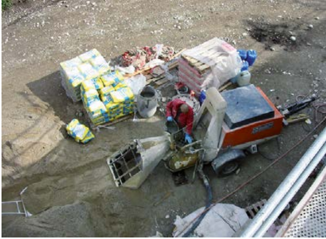
Herstellung eines Zementestrichs auf der Baustelle mit einer Estrichpumpe.
