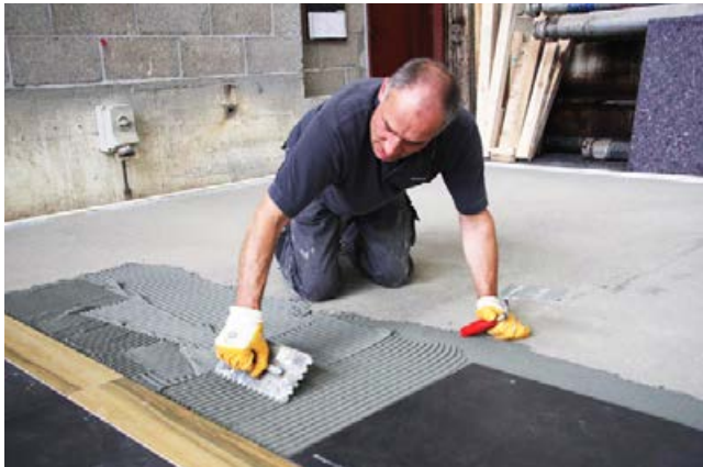
Aufkämgen des Dünnbettmörtels (Sopro MEG 665).
