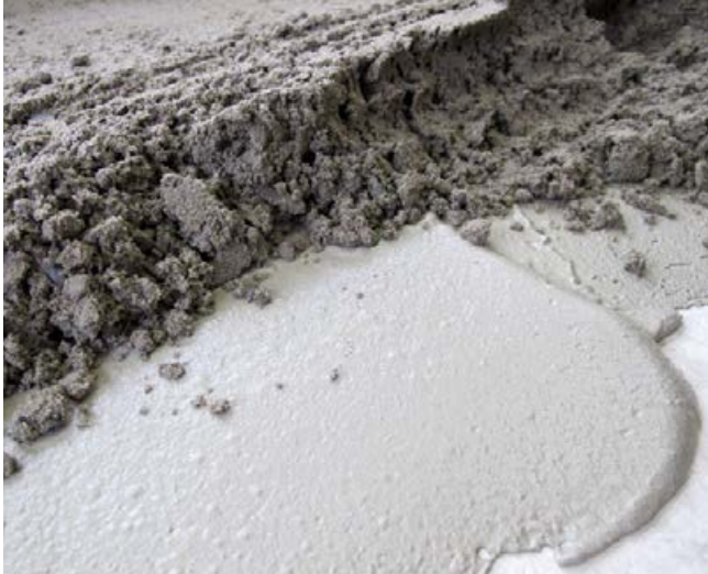
Einarbeiten des Estrichmörtels „frisch-in-frisch“ in die Haftschlämme.
