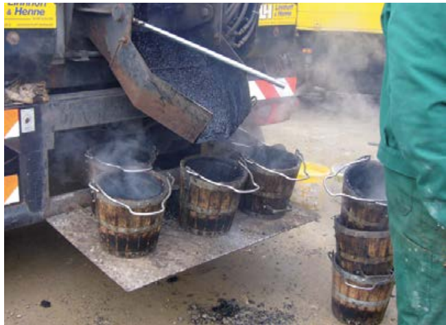
Gussasphalt wird im heißen Zustand auf der Baustelle eingebracht und verbaut.
