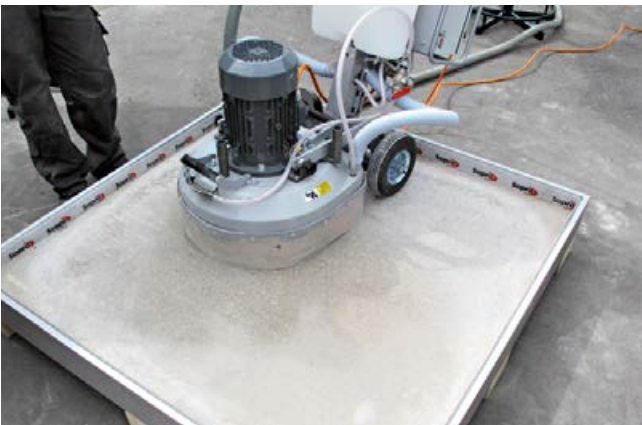
Sopro Rapidur® FE Fließestrich lässt sich nach der Aushärtung mit den üblichen Schleifmaschinen bearbeiten.
