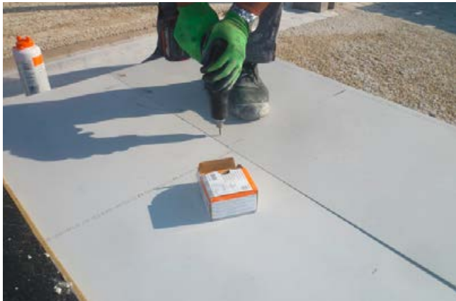
Die aneinandergesetzten Platten werden zusätzlich verschraubt.
