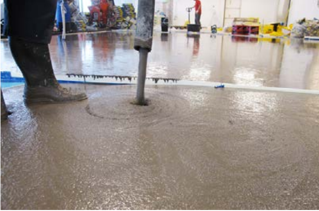
Einbau von Sopro Rapidur® FE – zementärer Fließestrich.
