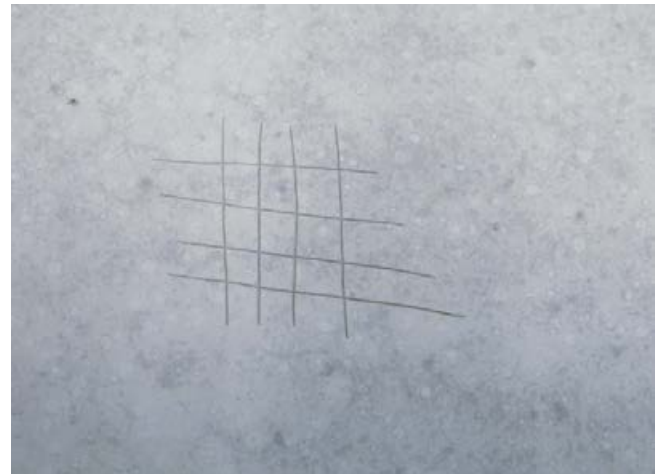
Nach dem Anschleifen sind nur noch scharfe Ritze erkennbar. Die Fläche ist optimal für eine Verlegung vorbereitet.
