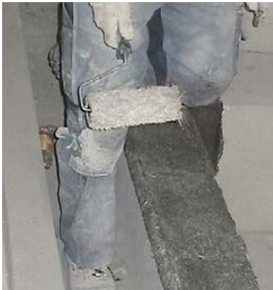
Auftragen der Sopro EpoxiGrundierung als Haftbrücke zum kraftschlüssigen Auffüttern einer Mauerkrone.
