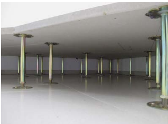
Hohlbodenkonstruktionen können mit den unterschiedlichsten Stützhöhen (je nach Haustechnikinstallation) aufgebaut werden.
