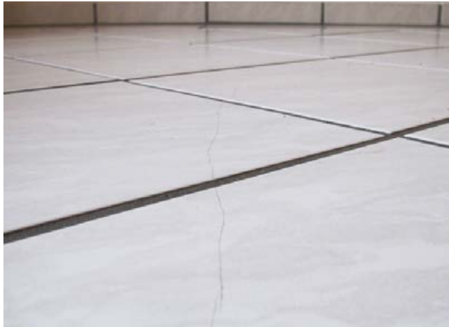
Durch den Lichteinfall ist der Riss in der Glasur der Fliese zu beobachten.
