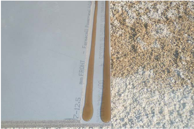
Mittels einer Kleberaube werden die Platten miteinander kraftschlüssig verleimt.
