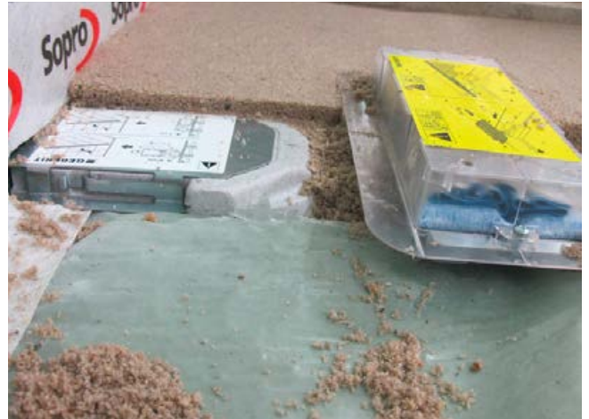
Epoxiestrichaufbau in einer Duschfläche mit geringen Aufbauhöhen.
