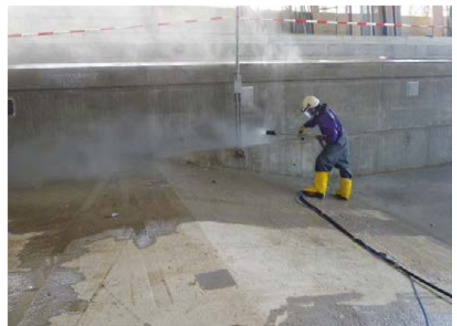
Strahlen des Betons zur Herstellung einer optimalen, griffigen, tragfähigen Betonoberfläche.
