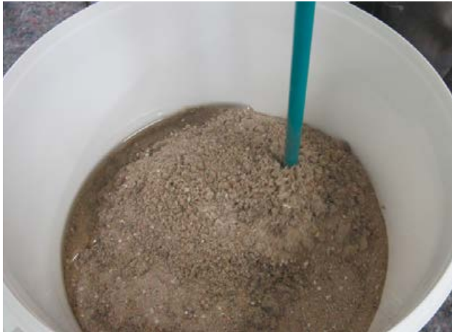
Anmischen von Reaktionsharzestrichmörtel.
