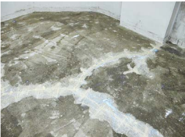
Sanierte Risse mit Einlage von Estrichklammern im Abstand von ca. 25–30 mm.
