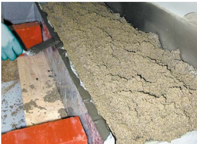
5 Vorbereitetes Drainagemörtelbett zur Aufnahme der Trittstufe.
