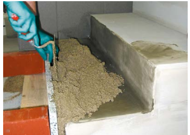
4 Verlegen der Setzstufe im Sopro DrainageMörtel eXtra.
