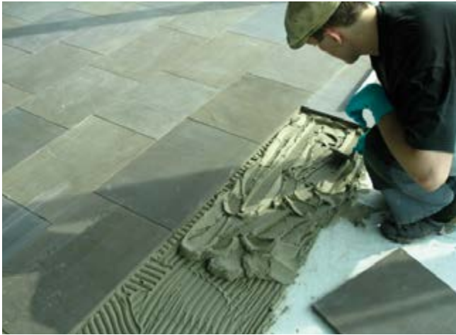
Verlegung des Naturwerksteins im Mittelbettverfahren mit dem Sopro VarioStone Mittelbettmörtelsortiment.
