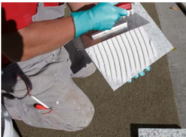
5 Rückseitiges Aufkämmen (Buttering-Verfahren) des Dünnbettmörtels (Sopro Marmor- & Mosaik-Flexkleber) auf die Naturwerksteinplatte.
