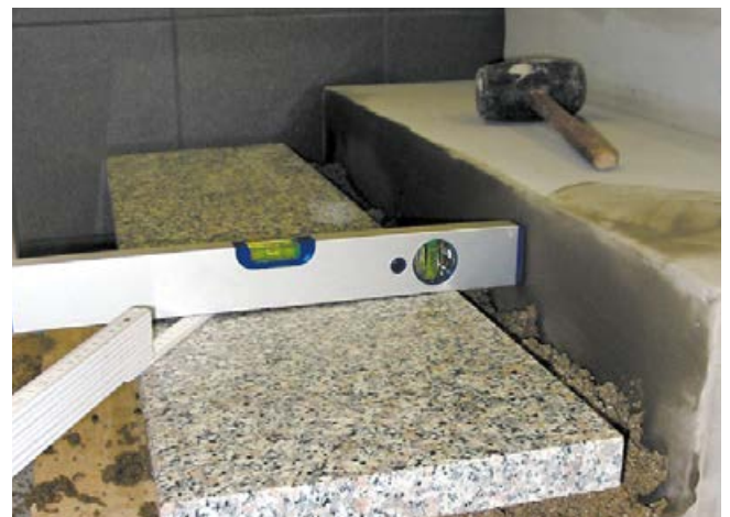
6 Fertige Stufe, versetzt mit Sopro DrainageMörtel eXtra.
