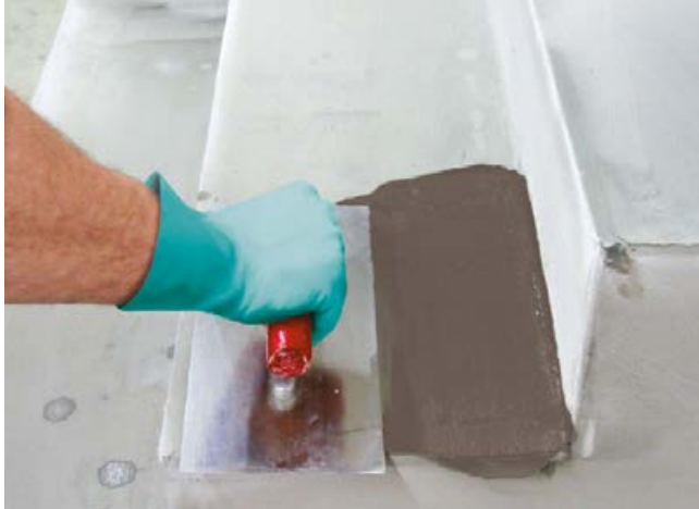
1 Gefällespachtelung mit Sopro RAM 3®.
