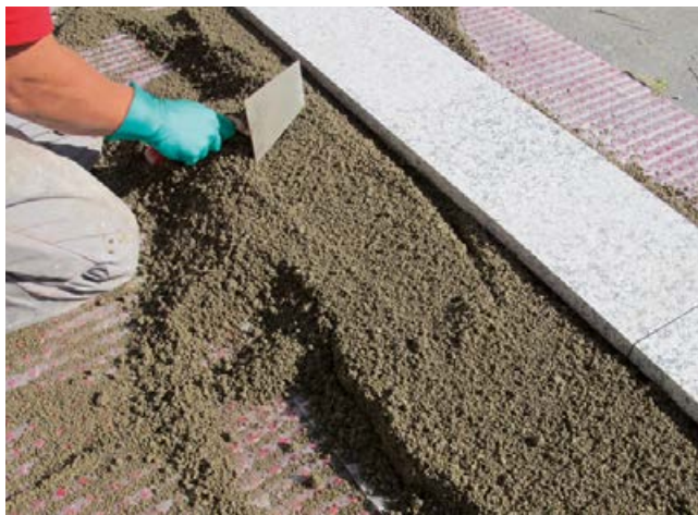
2 Vorbereiten des Drainage-Dickbettmörtels für die „frisch-in-frisch“-Verlegung.
