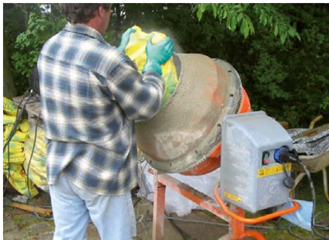
1 Anmischen von Sopro DrainageMörtel eXtra mit Freifallmischer.
