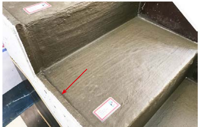
Treppenlauf seitlich mit Kante vorbereitet.
