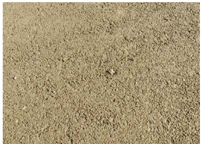
4 Abgebundene Drainage-Estrich-Konstruktion mit offener, wasser-durchlässiger Struktur.
