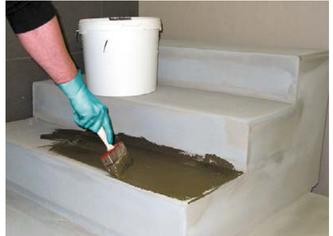
2 Auftragen der Sopro HaftSchlämme Flex auf der Verbundabdichtung als Kontaktschicht für den Sopro DrainageMörtel eXtra.
