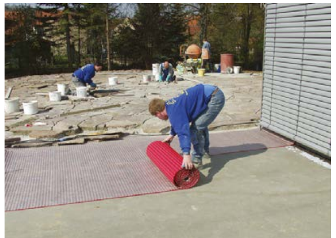
Ausrollen der Sopro DrainageMatte auf der abgedichteten Fläche mit anschließender Verlegung des Naturwerksteins mit Sopro DrainageMörtel eXtra.
