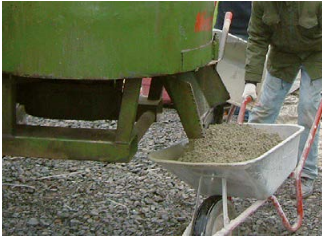
1 Anmischen des Mörtels mit Zwangsmischer oder Estrichpumpe.
