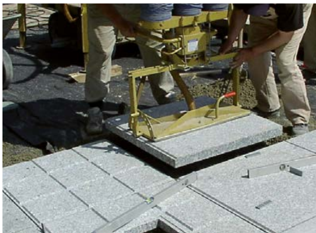
6 Maschinelles Versetzen der mit einem Haftvermittler (Sopro HaftSchlämme Flex oder Sopro Marmor- & Mosaik-Flexkleber) vorbereiteten Platte im Dickbett.
