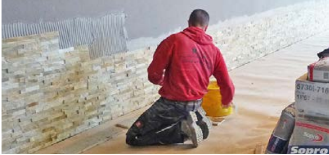
Verlegung der Naturwerksteinriemchen im kombinierten Verfahren an der Wand.
