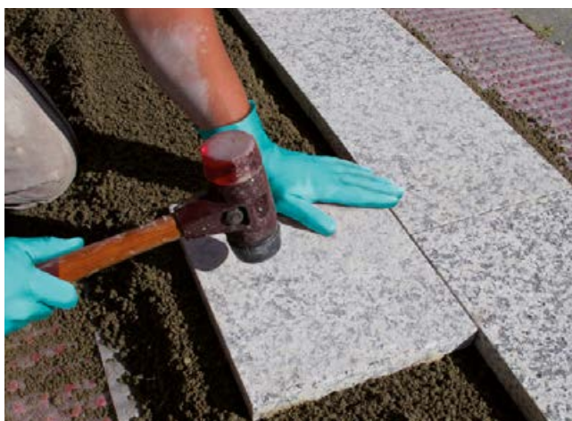
4 Einklopfen der Naturwerksteinplatte in den vorbereiteten drainagefähigen Dickbettmörtel.
