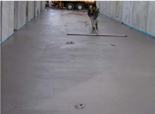
Frische Betonbodenplatte in einem Flughafenterminal.
