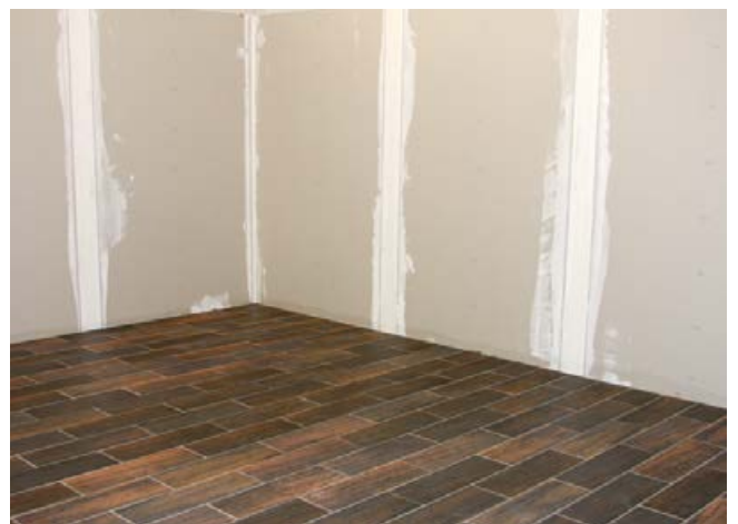
18 Entkoppelter keramischer Belag auf einem Holzuntergrund.
