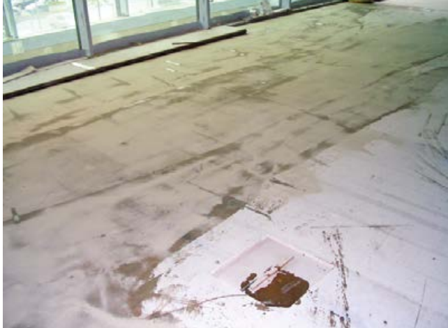
1 Grundieren des saugenden Untergrundes (Calciumsulfat) mit Sopro SperrGrund.
