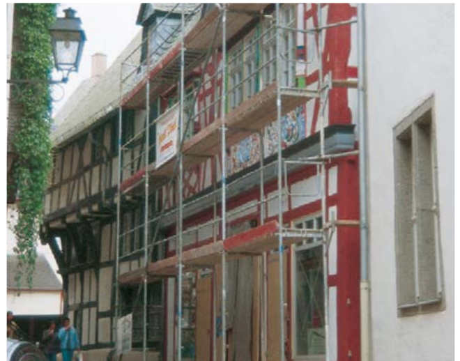
Sanierung im Altbaubereich.
