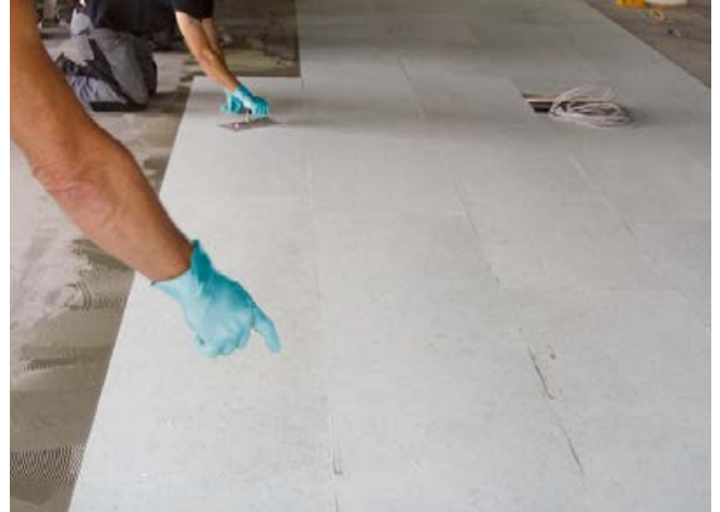
2 Verlegung der Sopro FliesenDämmPlatte zur Entkopplung des Oberbelages (Naturwerkstein).
