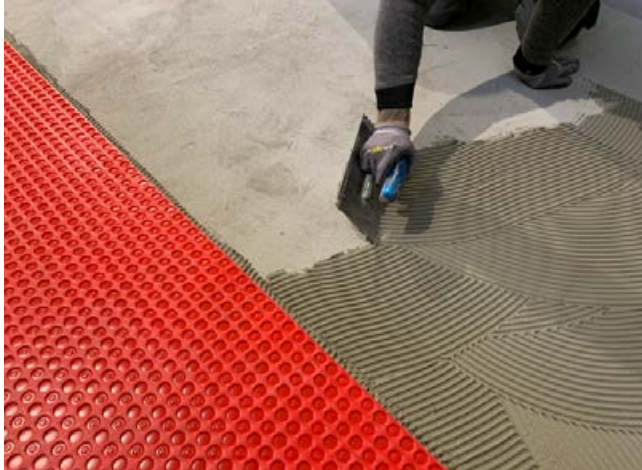
1 Auftragen von Fliesenkleber auf den Untergrund.
