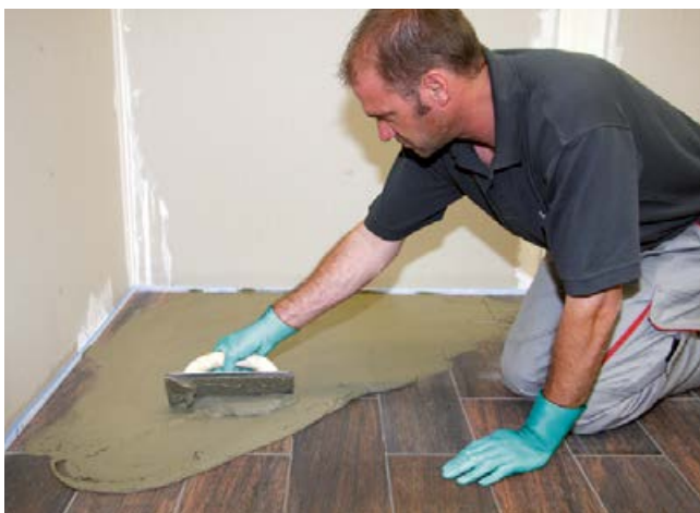
17 Verfugen der Fläche mit Sopro FlexFuge plus oder Sopro DF 10® DesignFuge Flex oder Sopro DFH DesignFugeHybrid.
