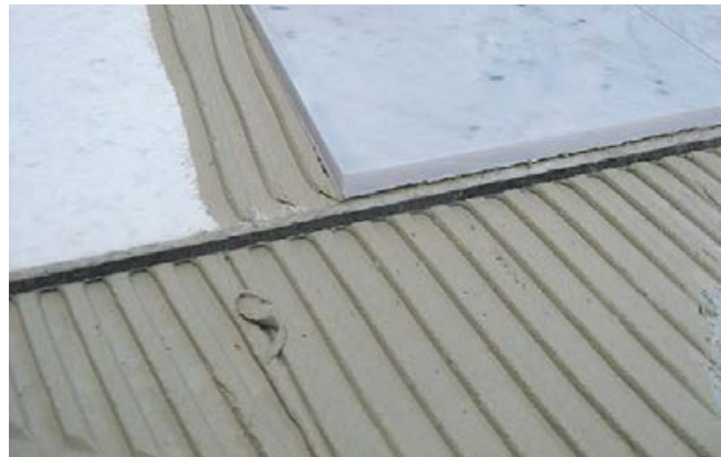
Verlegung von Sopro TrittschallDämm-Platte auf einem Treppenpodest mit anschließender Naturwerksteinverlegung.
