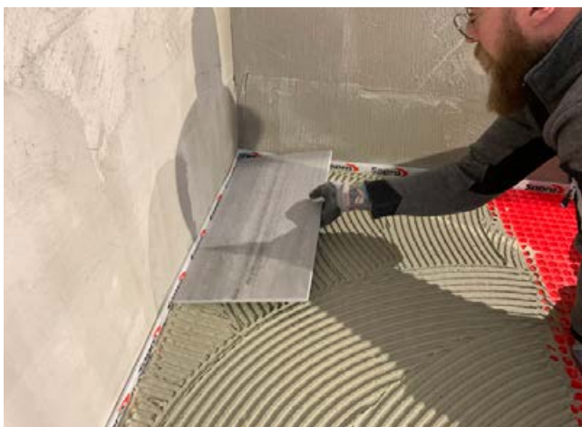
5 Fliesen oder Platten in das Kleberbett einlegen und andrücken. Großformatige Platten im Buttering-Floating-Verfahren verlegen
