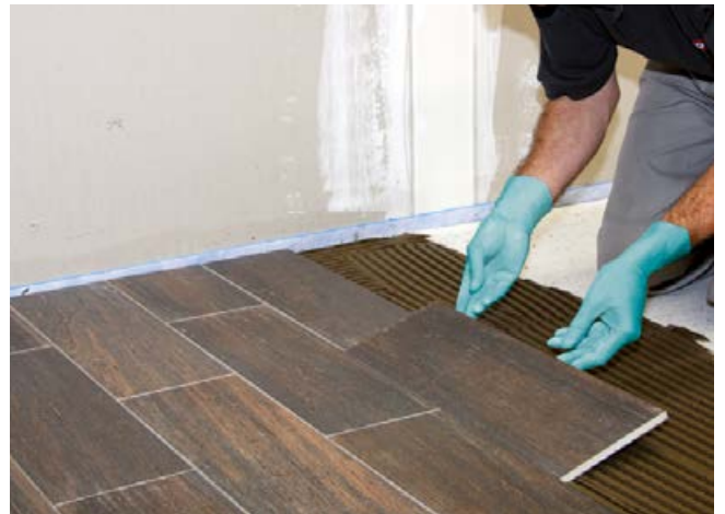
16 Verlegen der Keramik in das vorbereitete Mörtelbett.
