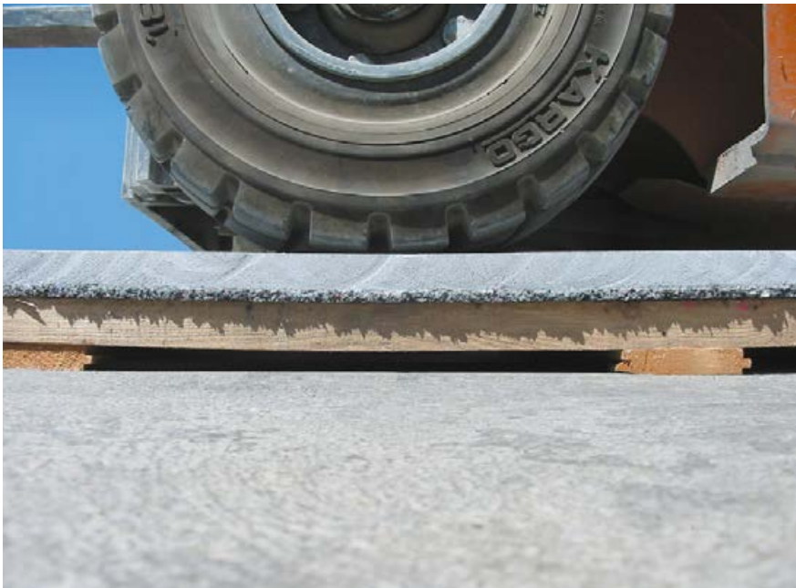
2,5 cm starke, hochbelastete, epoxidharzgebundene Schicht auf weicher Dämmstofflage.
