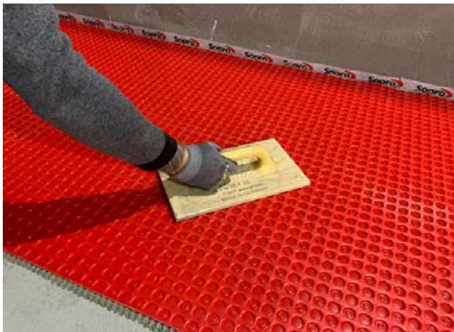
3 Andrücken der Bahn ins Klebebett. Die Fläche ist nun komplett entkoppelt.
