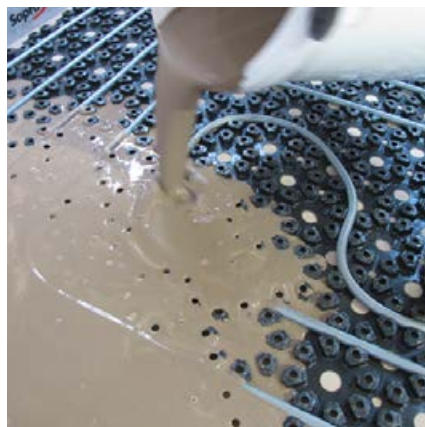
Verguss der Heizung mit Sopro VarioFließspachtel.
