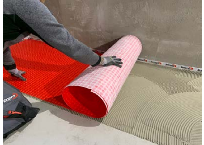
2 Ausrollen der Sopro EntkopplungsMatte eXtra EM-X.
