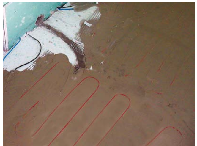
Elektro-Fußbodenheizung eingebettet in Sopro's No. 1 S1 Flexkleber.
