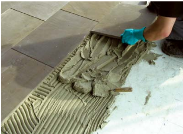
3 Verlegung des Naturwerksteinbelages mit Sopro VarioStone.
