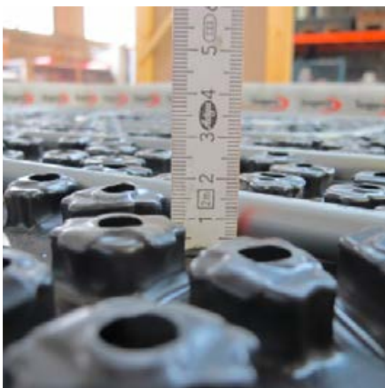
Kermit Heizsystem auf dem Sopro SMART® Aufbau verlegt.
