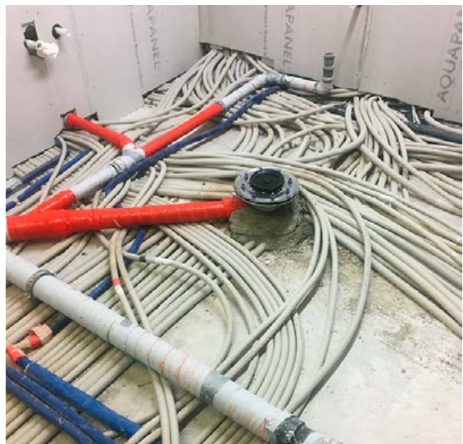
Die Versorgungsleitungen werden über die Rohdecke verlegt.
