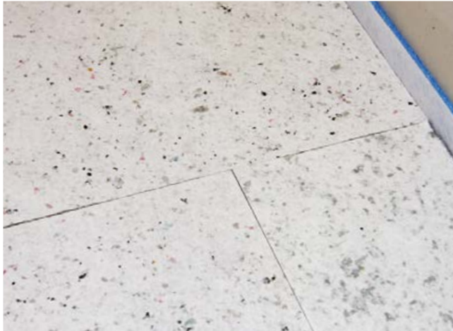
13 Die Verlegung erfolgt stoßversetzt.
