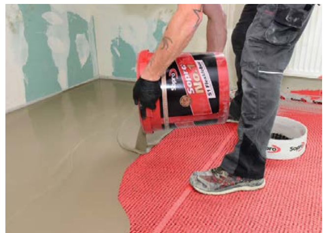
Ausgießen des VarioFließspachtels.
