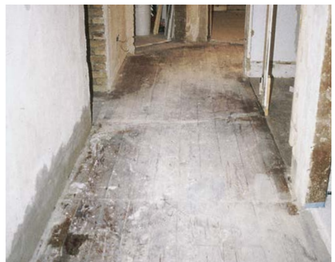
Holzdielen als Untergrund für eine Fliesenverlegung.
