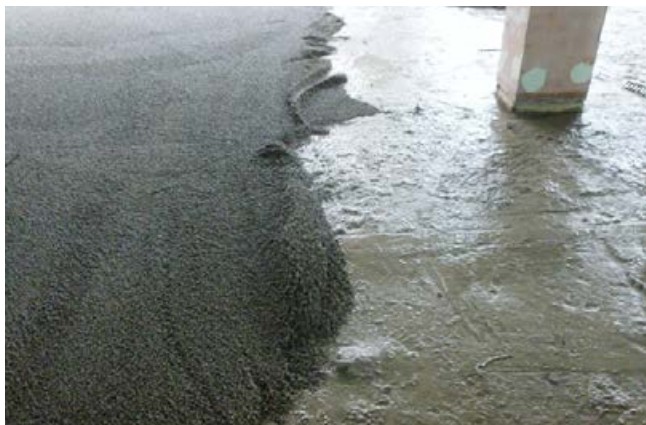
Einbringen der gebundenen Leichtschüttung im Verbund auf der unebenen Betondecke.
