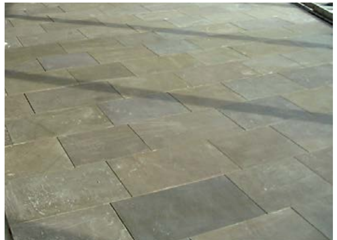
4 Fertig verlegte Fläche.
