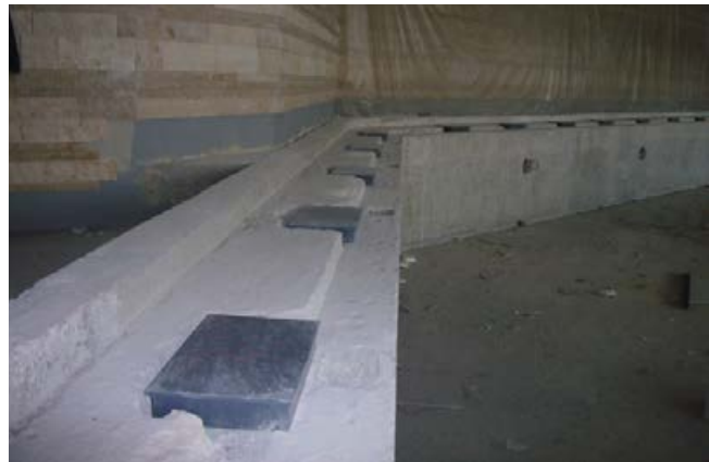
Entwässerungskästen, ausgerichtet und mit Mörtel fixiert.
