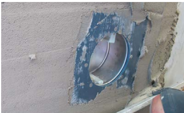
6 Verputzen der Fläche und Einputzen des Scheinwerferflansches mit Sopro SchwimmBadPutz.
