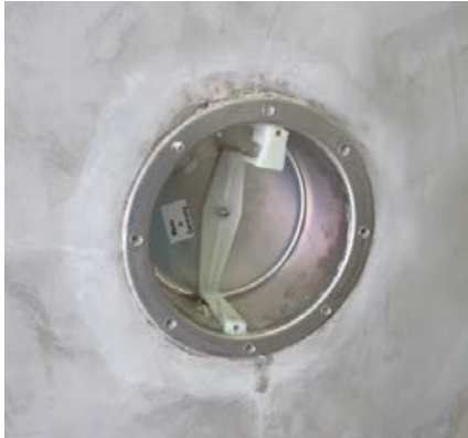
1 Einbetonierter Scheinwerfer.
