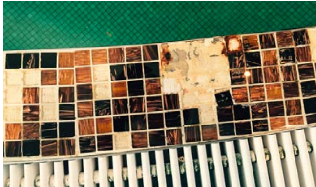
Abgelöste Glasmosaiksteine am Beckenkopf.
