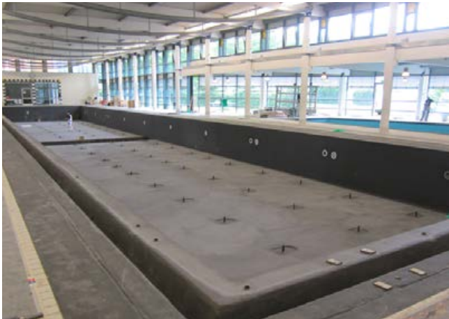
Zwischen 100 bis 200 Durchdringungen besitzt ein Schwimmbecken.
