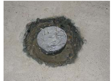
Aussparung im Boden für den späteren kapillarbrechenden Verguss mit Epoxidharzmörtel.
