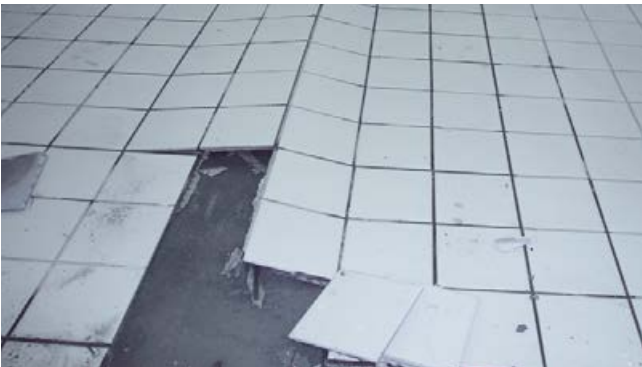
Dachförmiges Aufstellen eines Fliesenbelages auf einem Beckenboden.
