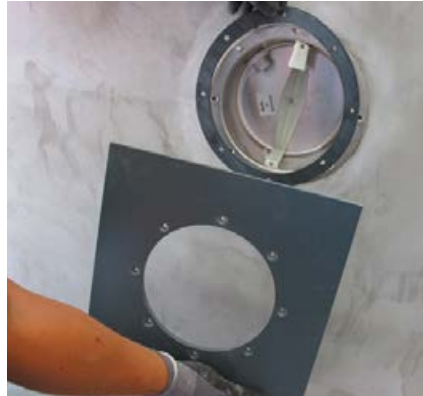
2 Flanschplattenset für die Nachrüstung auf der Baustelle.
