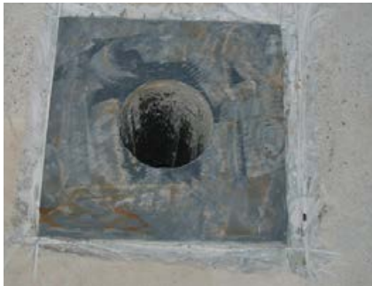
Kunststoffflansch (PVC) öl- und fettfrei, mechanisch aufgeraut, vorbereitet für den Grundieranstrich mit Sopro EpoxiGrundierung und Sopro Kristallquarzsand.
