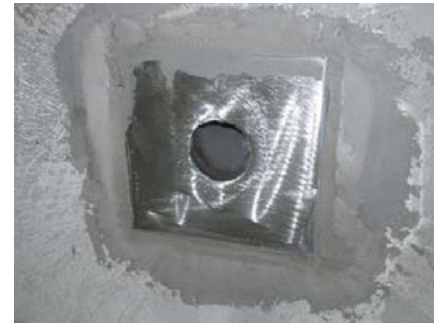
Edelstahlflansch mit Hülse für die spätere Aufnahme eines Geländers metallisch blank sowie öl- und fettfrei vorbereitet für den Grundieranstrich mit Sopro EpoxiGrundierung und Sopro Kristallquarzsand.
