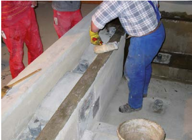
1 Grundieren der Flächen mit Sopro EpoxiGrundierung. Verbrauch abhängig vom Saugverhalten des Untergrundes.
