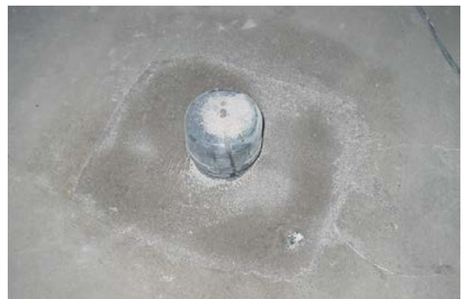
Bodendurchdringung, kapillardicht vergossen mit Sopro EpoxiGrundierung Quarzsandgemisch.
