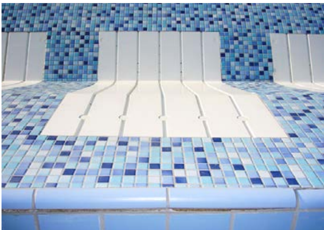
Abgedrückte Kunststoffliege, welche sich aufgrund ihrer Ausdehnung verselbständigt hat.
