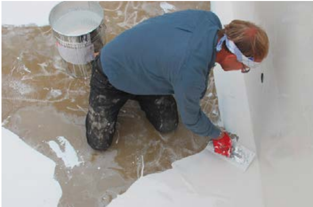
7 Abdichten einer Bodenfläche mit Sopro PU-FlächenDicht Boden.
