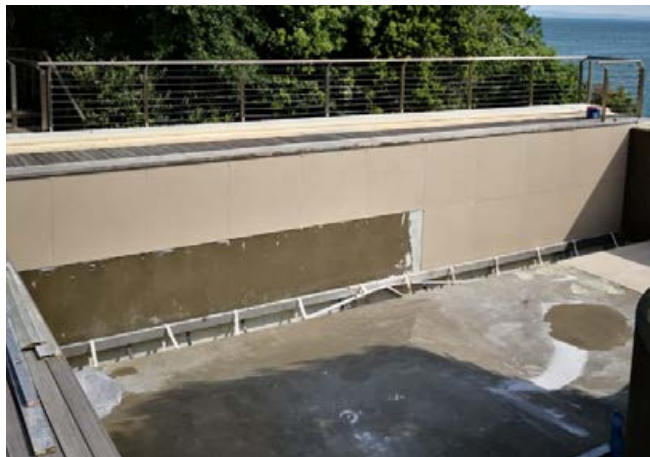
Aus gestalterischen Gründen werden zunehmend auch großformatige Fliesen im Schwimmbecken verlegt.
