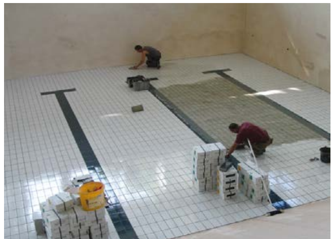
4 Verfugen der Flächen mit hochfester Sopro TitecFuge® plus oder breit.
