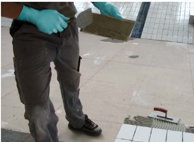
3 Nach bestandener Dichtigkeitsprüfung: Verlegung der Fliesen mit einem hydraulisch abbindenden Fliesenkleber im Buttering-Floating-Verfahren.
