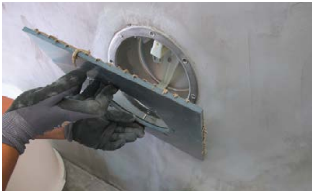
4 Ansetzen und Verschrauben der Flanschplatte.
