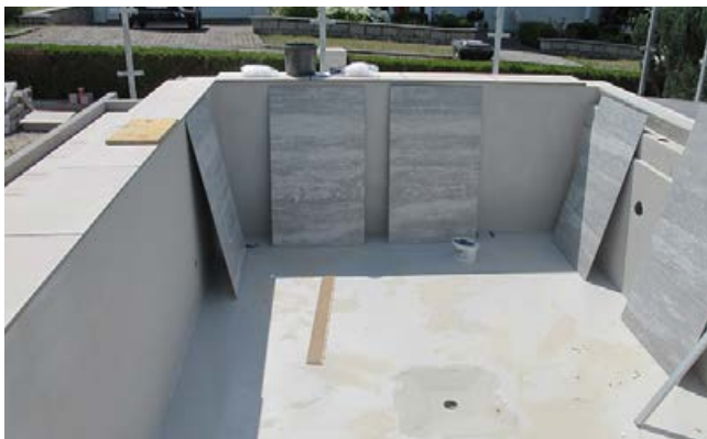
Die Platten sind jeweils anzupassen und dann im kombinierten Verfahren zu verlegen.
