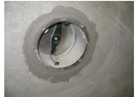
Verspachtelung des frei gestemmten Bereiches mit einem kapillardichten Reaktionsharzmörtel.
