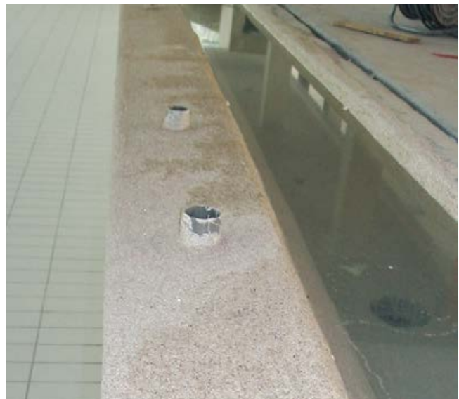
Hülsen im Beckenkopf für spätere Geländeranbindung.
