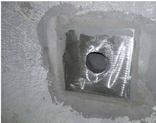
Flanschplatte mit geschlossener Hülse, eingelassen in das Becken für die Aufnahme eines Geländers.
