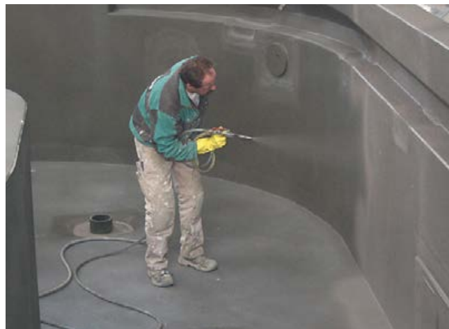
Applikation der Abdichtung im Verbund (z. B. Sopro TurboDichtSchlämme 2-K) mittels Spritzverfahren.
