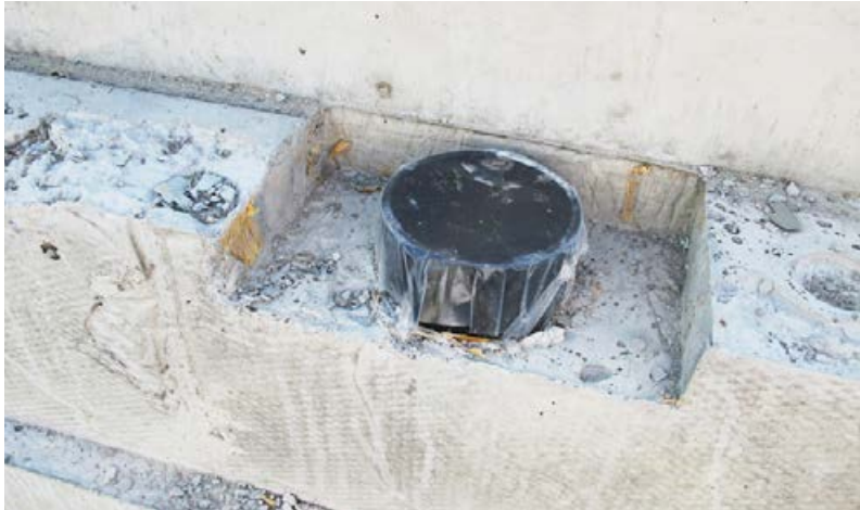
Rohr, welches in der Rinne mit einbetoniert wurde. Ein Flansch ist nun noch anzubringen.
