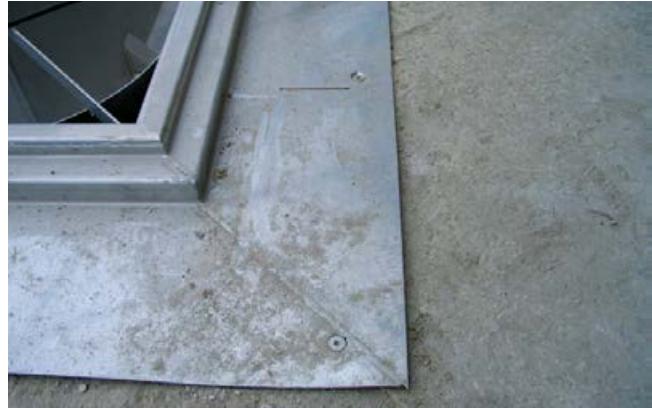
Edelstahlbecken mit breitem Flansch, auf welchem die Abdichtung im Verbund aufgetragen werden kann.
