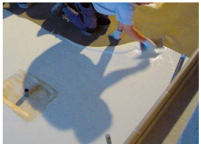
6 Abdichten eines Beckens mit Sopro PU-FlächenDicht.
