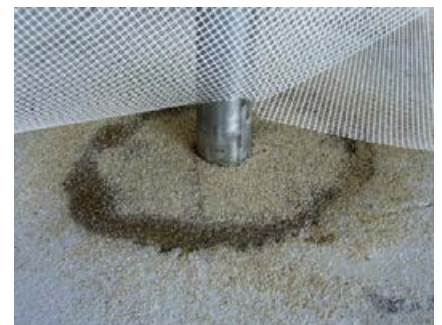
In die Abdichtung wird Sopro Armierungsgewebe zur Verstärkung eingebettet.
