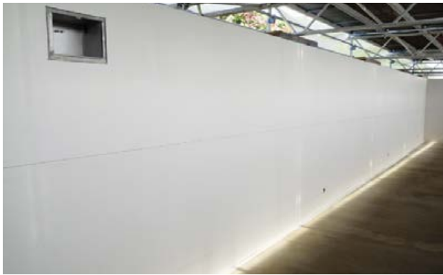
Becken mit Großformatplatten.
