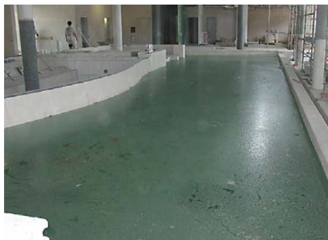
Dichtigkeitsprüfung (14 Tage) mit gechlortem Wasser.
