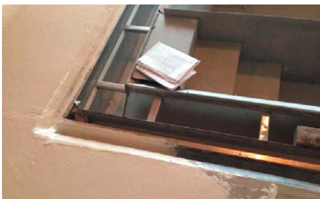
5 Andichten mit Sopro PU-FlächenDicht Wand an den Flansch des Edelstahlbeckens.
