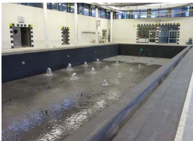
Nach Einbau und Trocknung der Abdichtung im Verbund wird das Becken auf Dichtigkeit geprüft.
