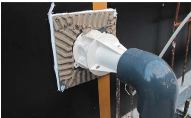
Die rückseitig aufgebrachte Fliesenkleberzahnung sorgt dafür, dass die Flansche fest in die Betonstruktur eingebunden sind.
