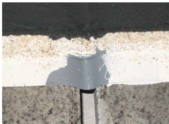
Abdichten einer Bauwerksfuge mit zweilagigem Dichtband, eingebettet und überarbeitet mit Sopro PU-FlächenDicht.
