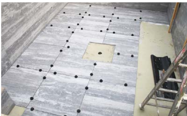
... um Höhenunterschiede von Platte zu Platte zu vermeiden.
