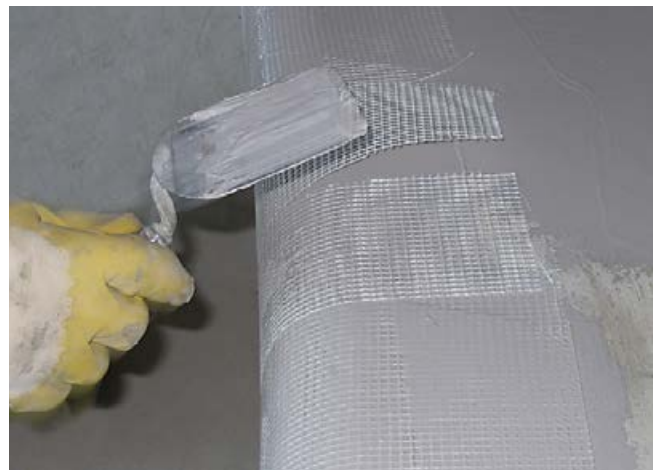
4 Einarbeiten von Sopro Armierung in die Abdichtung im Verbund im Unterwasserbereich.
