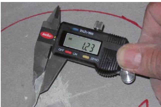
11 Prüfen der Gesamtschichtdicke der Abdichtung im Verbund.
