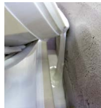
Verguss eines Beckenkopfsteins mit einem elastischen kapillardichten PU-Material (Sopro PU-FlächenDicht).
