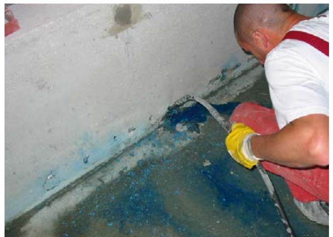
Rissverpressung an einem WU-Betonbecken.
