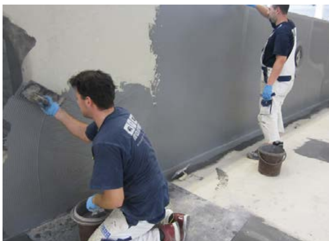
Die Abdichtung im Verbund (z. B. Sopro TurboDichtSchlämme 2-K) lässt sich durch Spachteln oder Spritzen sicher applizieren.
