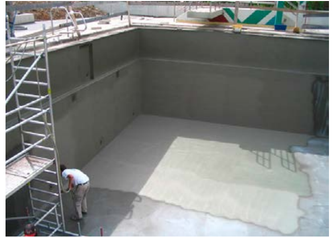
Abdichten eines Springerbeckens im Spritzverfahren.
