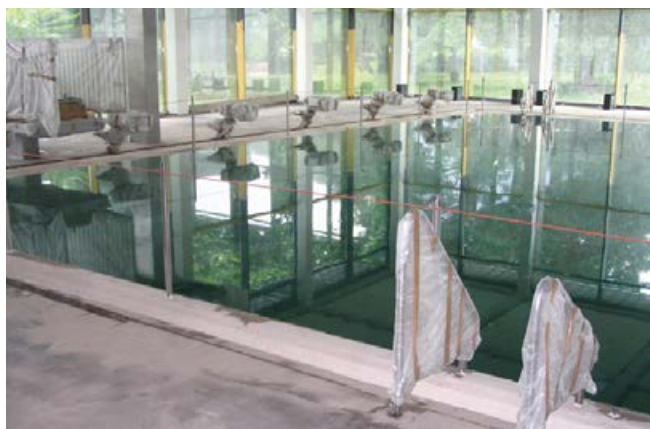
12 Dichtigkeitsprüfung (mind. 14 Tage).
