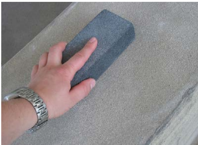
3 Überarbeiten der abgesandeten, trockenen Flächen mit Korundstein.
