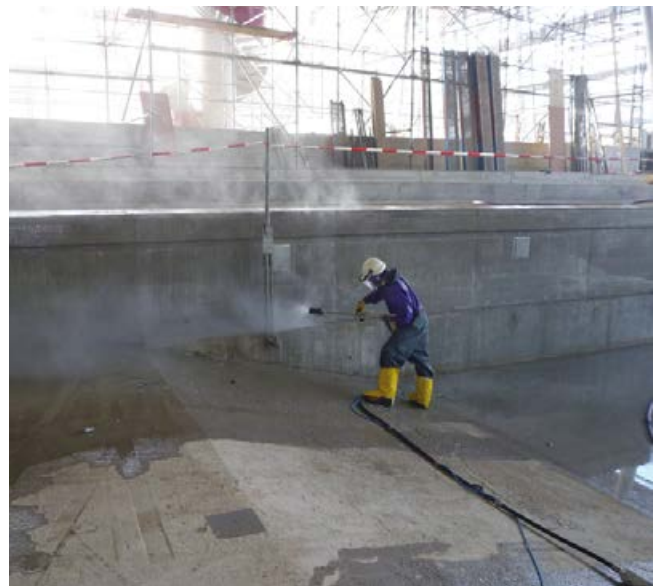
Strahlen der Betonoberfläche mit einem Sandstrahl- oder Wasserstrahlhochdruckgerät.
