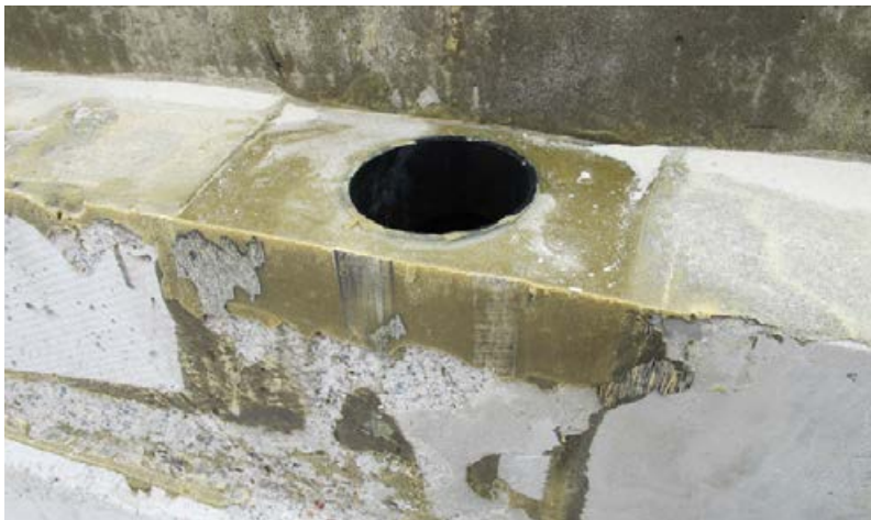
Das Rohr wurde mit einem flüssigen Epoxi-Qzarsand-Gemisch kapillardicht vergossen.
