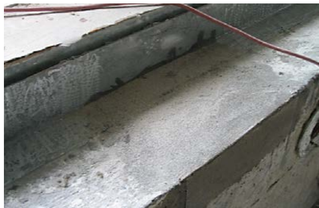
Vorbehandelter Entwässerungskasten in ausreichender Größe mit Reaktionsharz und Gewebeeinlage, vorbereitet für die Abdichtarbeiten.
