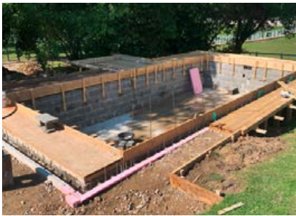
Schalungssteine aus Polystyrol oder zementgebundenen Mörteln.
