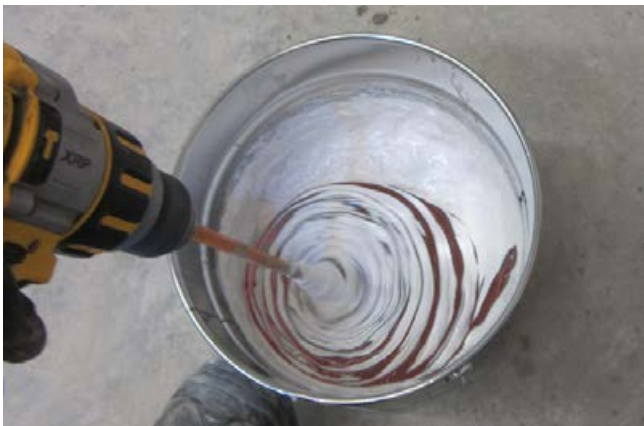
9 Das Sopro FlächenDicht flexibel Kontrastmittel wird in das Sopro PU-FlächenDicht eingemischt – eine graue Farbgebung entsteht.
