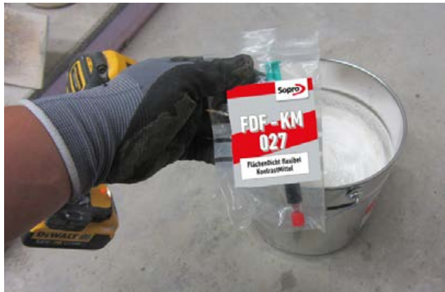
8 Sopro FlächenDicht flexibel Kontrastmittel kann dem Abdichtungsmaterial zugegeben werden, um eine bessere farbliche Unterscheidung zwischen Schicht 1 und Schicht 2 zu erhalten.
