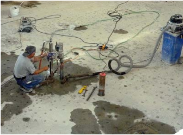
Bei Altbecken werden mittels Kernbohrungen notwendige Durchdringungsbauteile im Beckenkörper installiert.
