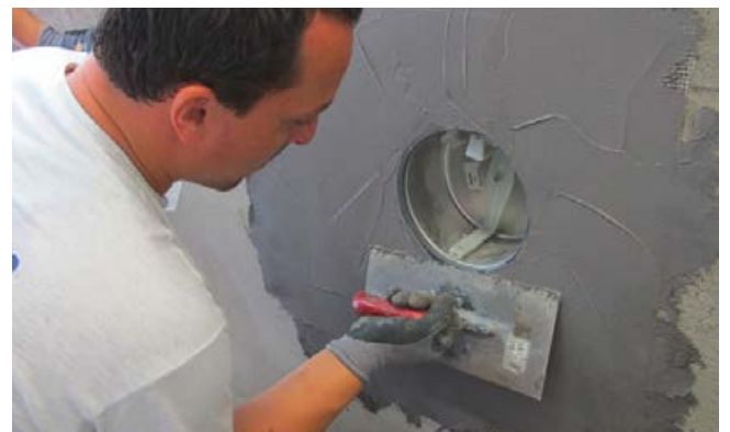
7 Abdichten der Fläche und des Scheinwerfers mit z. B. Sopro TurboDichtSchlämme 2-K. Zur Verstärkung wird im Bereich des Scheinwerfers ein Armierungsgewebe in die Abdichtung mit eingearbeitet.
