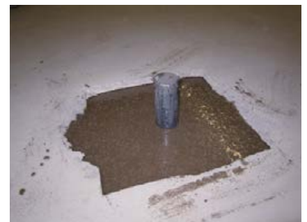
Die Durchdringung wird mit einem Epoxidharz-Quarzsandgemisch 1 : 1 : 1 kapillardicht vergossen.
