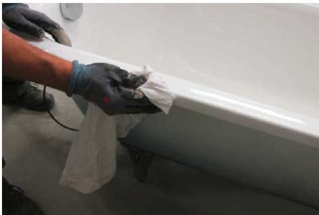
1 Reinigung des Wannenrandes, entfernen aller haftungsmindernder Stoffe. Hinweis: Montage der Wannendichtbänder erst kurz vor Einbau der Wanne vornehmen.
