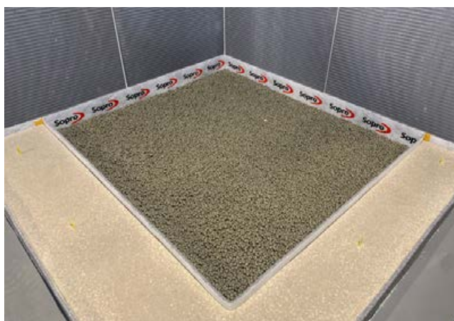
2 Ausgleichen der Fläche unterhalb des Duschelements mit Sopro SMART® gebundene Leichtschüttung.
