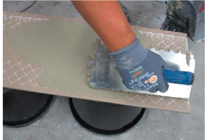
8 Die großformatigen Fliesen sind im Kombinierten Verfahren zu verlegen.
