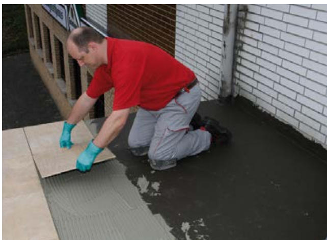
5 Einschleiben der Platten in das vorbereitete Sopro megaFlex S2 Mörtelbett.
