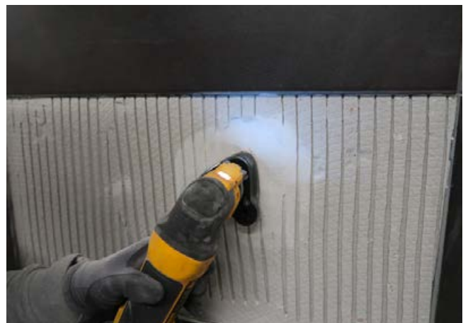
4 Der Fliesenkleber kann nun abgeschliffen werden, damit anschließend die neue Fliese wieder passt
