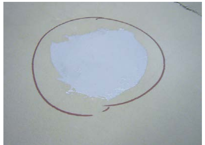
Messstelle überlappend geschlossen.
