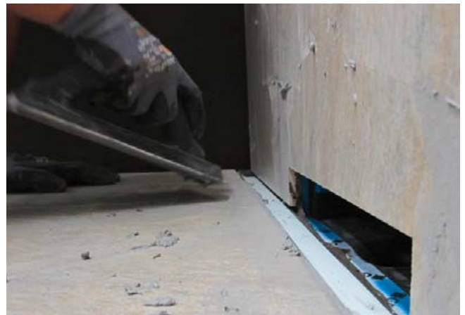
10 Die Verfugung erfolgt mit Sopro DF 10® DesignFuge Flex.
