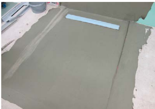
4 Abgedichtete Duschfläche in zwei Arbeitsgängen, bereit für die folgende Fliesenverlegung.
