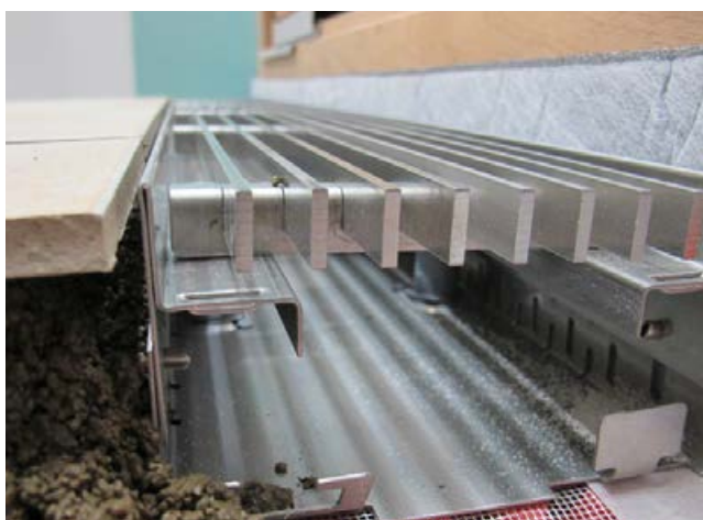
6 Die Fliesen schließen oberkantenbündig mit der ACO-Rinne ab.
