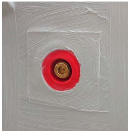
Eine abgedichtete Rohrdurchdringung, die dem Installateur genug Platz für seine Arbeit läßt.
