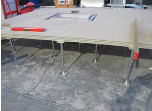
Hohlbodenkonstruktion im Großküchenbereich (System Lindner).
