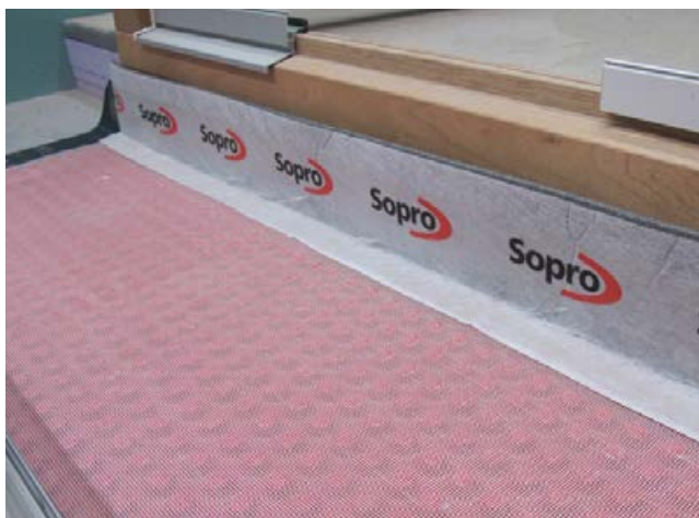
2 Bahnabdichtung mit Sopro DrainageMatte belegt. Am Türelement ist Sopro RandDämmstreifen aufgeklebt.
