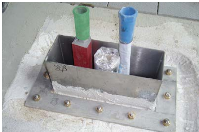
Durchdringungsbauteil mit Pressdichtflansch eingedichtet mit einer Verbundabdichtung.
