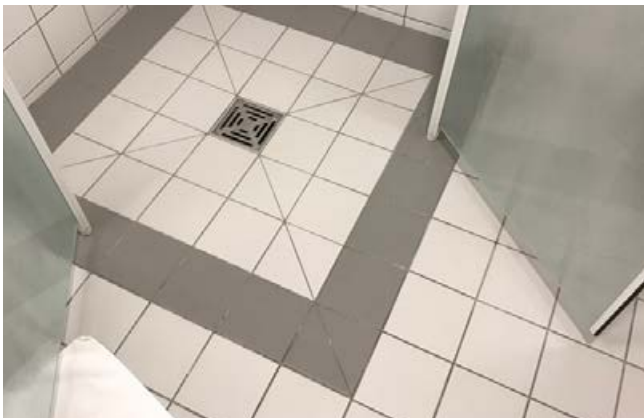
Duschfläche mit Formfliesenumrandung mit 1 cm Höhenunterschied.
