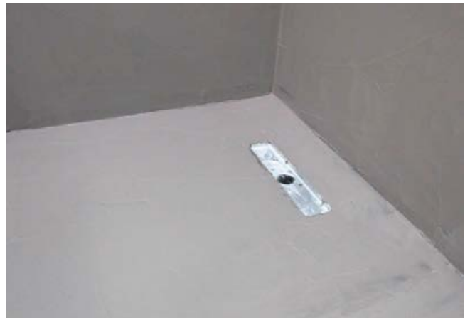
4 Mit Sopro DichtSchlämme Flex 1-K abgedichtete Duschecke, bereit für die folgende Fliesenverlegung.
