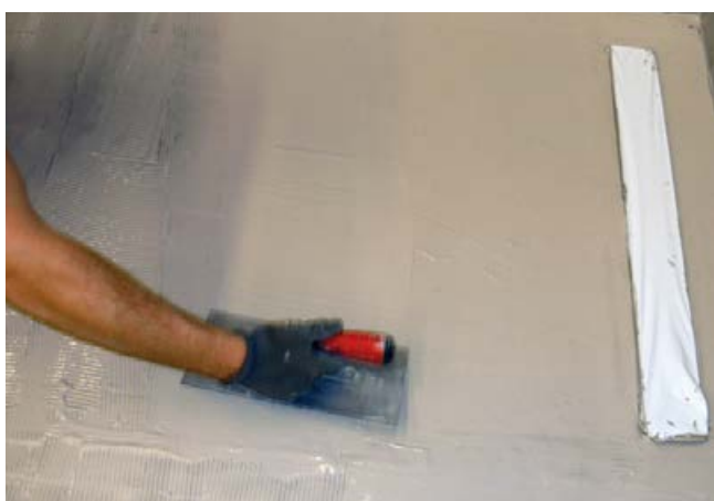
5 Abdichten der Wand- und Bodenflächen mit Sopro DichtSchlämme Flex RS.
