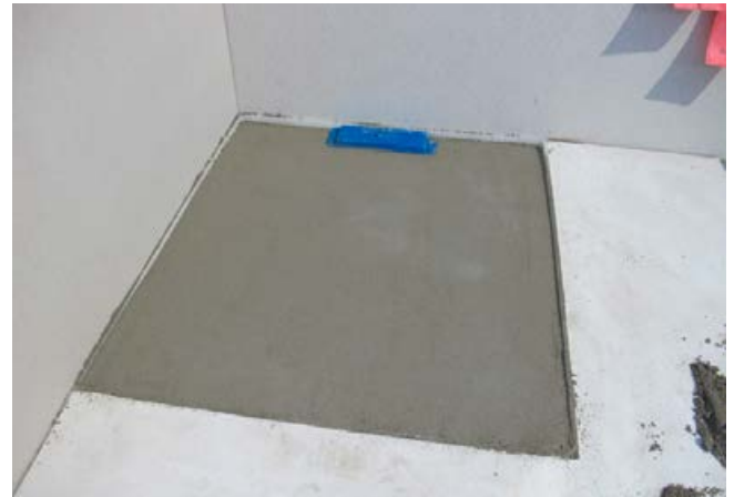
2 Ausgehärtete Fläche, bereit für die Abdichtarbeiten.
