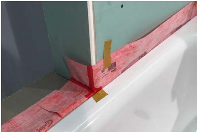
1 Anschluss der Badewanne an eine Ablage mittels Sopro WannendichtMultiecke.
