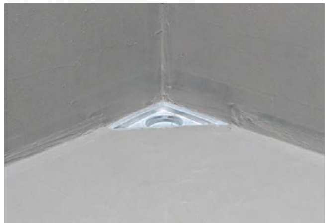
6 Abgedichtete Duschecke mit Sopro DichtSchlämme Flex 1-K oder wahlweise mit Sopro Turbo DichtSchlämme 2-K.
