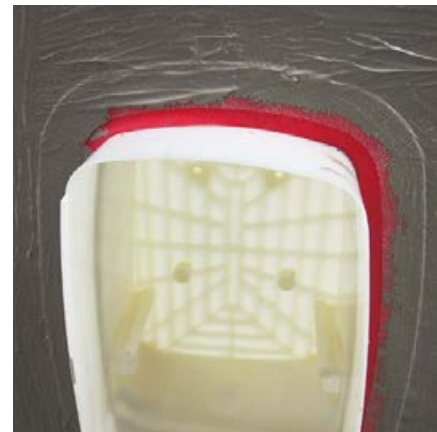
Eine abgedichtete Wandarmatur z. B. mit Sopro FlächenDicht flexibel.
