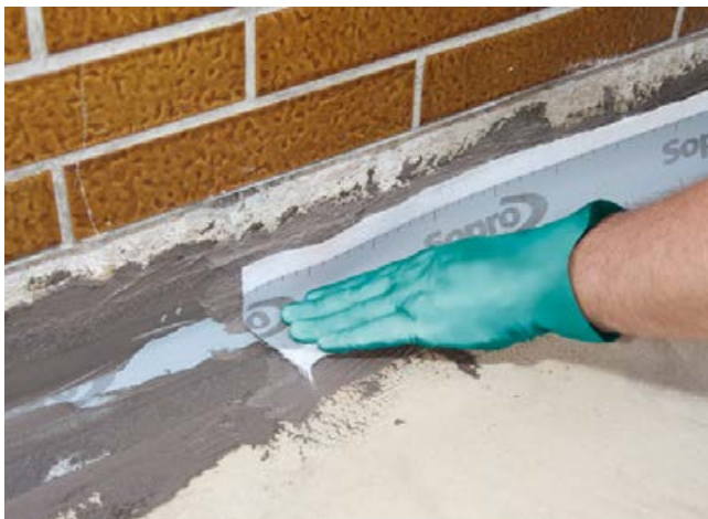
3 Einarbeitung und Fixierung der Dichtbänder und Formteile mit Sopro TurboDichtSchlämme 2-K zu Beginn der Abdichtarbeiten.
