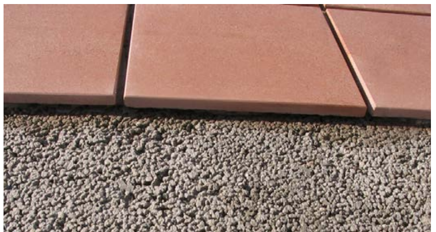
Fliesenverlegung auf Drainageestrich im Dünnbettverfahren.
