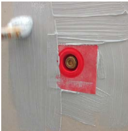
Eindichten der Manschette mit Sopro FlächenDicht flexibel oder Sopro TurboDichtSchlämme 2-K.
