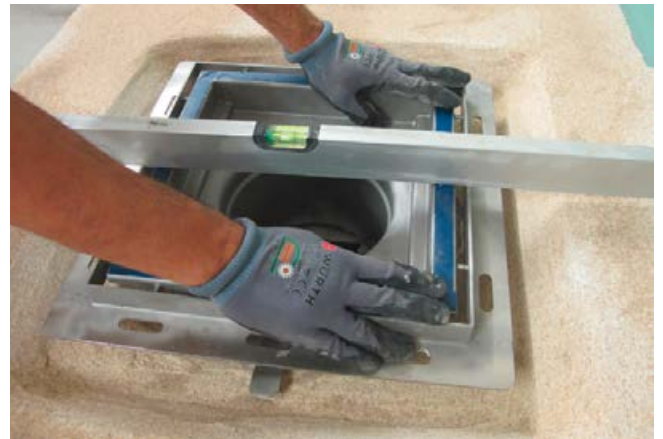
Das Aufstockelement (Firma Kessel) des Bodenablaufs ist genau auf die notwendige Höhe zu setzen und auszurichten.
