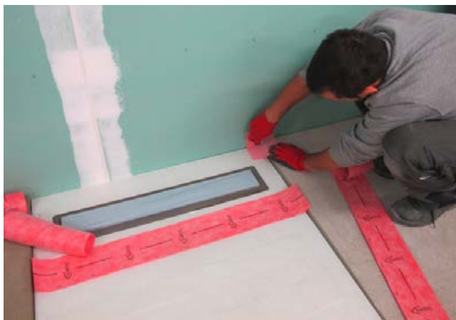
2 Vorbereiten der Komponenten für die Verbundabdichtarbeiten, unter anderem die Sopro AEB® Höhen-Pass-Stücke.
