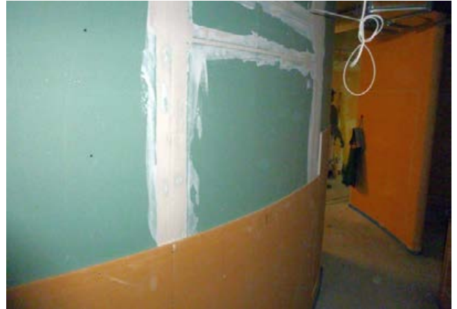
Trockenbau mit gipshaltigen Platten.
