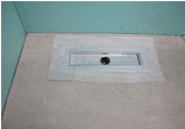
3 Gewebeeinlagen für die Abdichtung im Übergangsbereich von Rinne zu Estrich.
