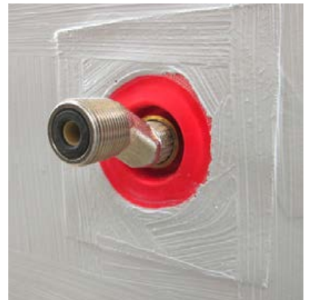
Das Rohr kann ggf. noch zurückgeschnitten werden.
