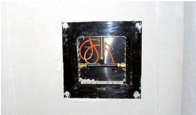
Sonderkonstruktion einer Unterputzarmatur mit Anflanschrahmen ...
