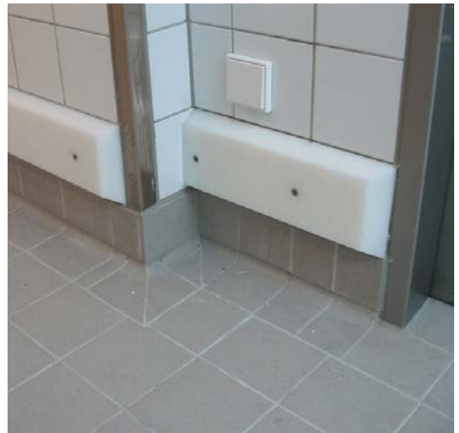
Ausgeführtes Sockeldetail mit Rammschutz.
