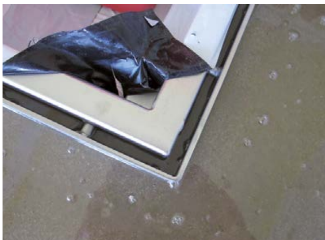
Der umlaufende Edelstahlrahmen ist gut zu erkennen. Die Bolzen werden später durchtrennt, der Rinnenkörper kann sich so frei bewegen.
