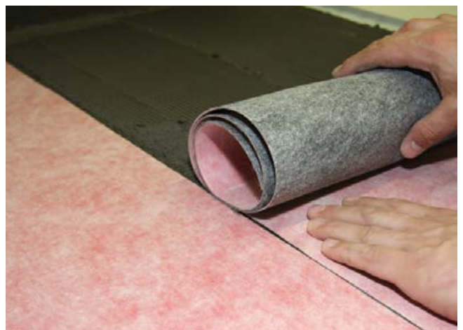
6 Die Sopro AEB® plus Abdichtungs- und Entkopplungsbahn plus wird Stoß an Stoß verlegt.
