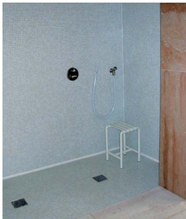
Barrierefreie Duschfläche im Seniorenheim.
