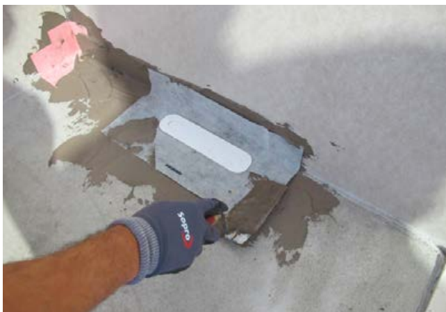
3 Der Flansch am Bodenablauf ist aufzuklappen und in die Abdichtung Sopro DichtSchlämme RS einzuarbeiten.
