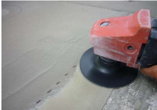
2 Die Abdichtung ist mit Sandpapier auf null auslaufend anzuschleifen.
