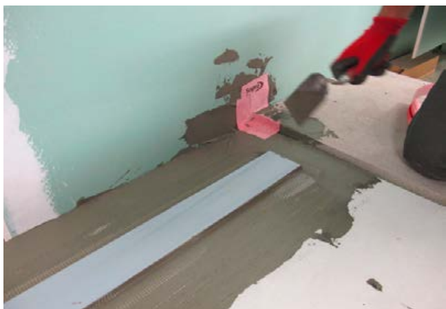
3 Im Bereich der Rinne wird ein Gewebe in die Sopro TurboDicht-Schlämme eingearbeitet. Das Sopro AEB® Höhen-Pass-Stück wird ebenfalls eingesetzt.
