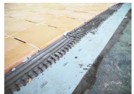
Die Fliesenverlegung ist mit Sopro megaFlex turbo, Sopro megaFlex Silver oder Sopro DünnBettEpoxi auszuführen.
