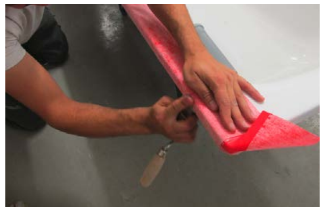
4 Die Bänder sind mittels Spachtel oder Roller fest an den Wannenrand anzudrücken.
