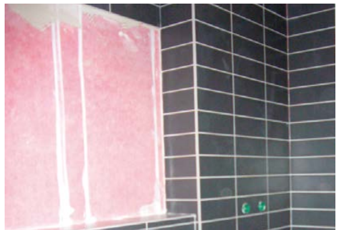
5 Eine Fliesenverlegung kann kurze Zeit später, nach Beendigung der Abdichtungsarbeiten, auf der Sopro AEB® Abdichtungs- und Entkopplungsbahn mit einem Dünnbettmörtel (Sopro's No. 1) erfolgen.
