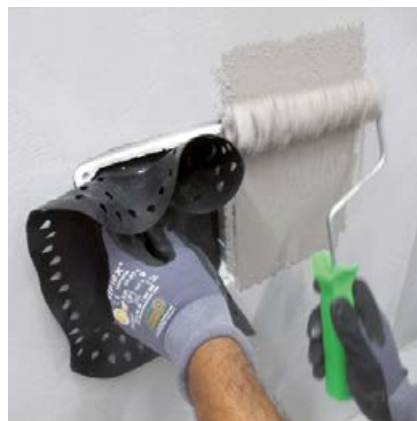
Sicheres Eindichten einer Wandarmatur (deren Manschette sich im Gehäuse befindet) mit Sopro Fixier- & DichtKleber oder Sopro DichtSchlämme Flex RS.
