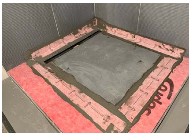
4 Anarbeiten des Sopro ShowerBase Line Duschelements mit Hilfe der Sopro AEB® Dichtbänder an die Wand- und Bodenflächen.
