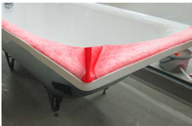
6 Fertig vorbereitete Wanne, bereit für den Einbau.
