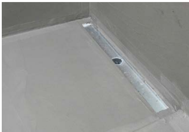
6 Abgedichtete Duschfläche (Zwei Arbeitsgänge), bereit für die Fliesenverlegung.
