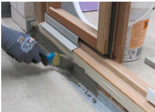
3 Abdichten der Fuge mit Sopro TurboDichtSchlämme 2-K.
