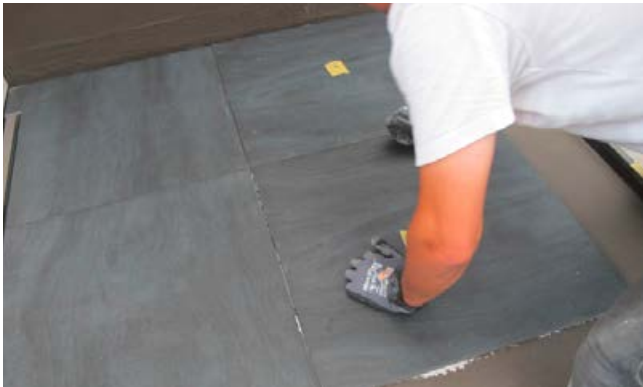
Die Fliesen sind in der Duschfläche verlegt.
