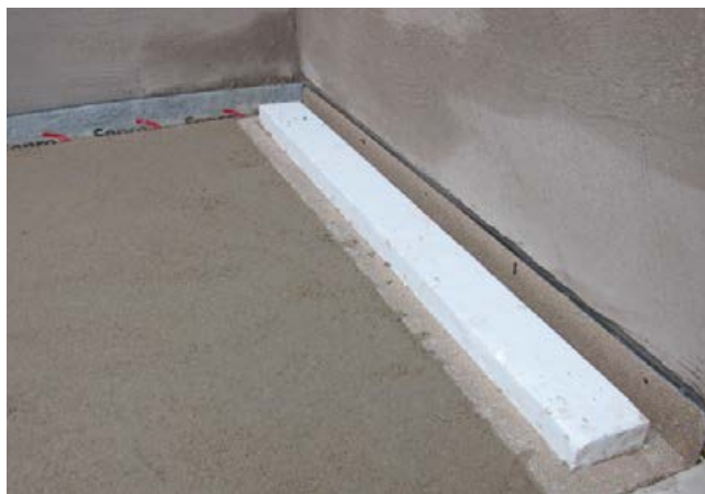
4 Einbau der Rinne im Estrich (Sopro Rapidur® M1/Sopro Rapidur® M5).
