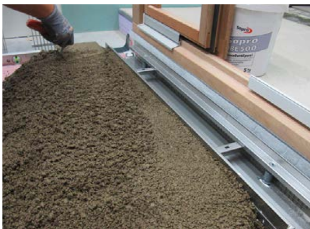
4 Der Sopro DrainageMörtel eXtra wird in einer Mindestschichtdicke von 50 mm auf der Sopro DrainageMatte aufgebracht. Anschließend vorverdichtet und abgezogen.
