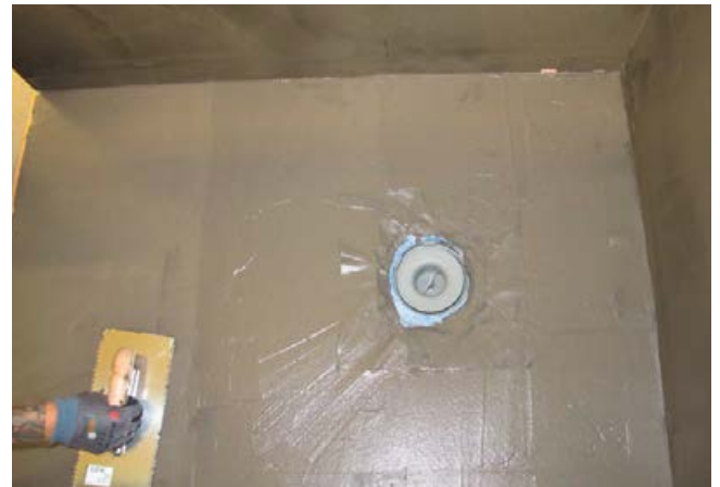
7 Eindichten des Bodenablaufs und abdichten der Duschfläche mit Sopro TurboDichtschlämme 2-K in zwei Arbeitsgängen.
