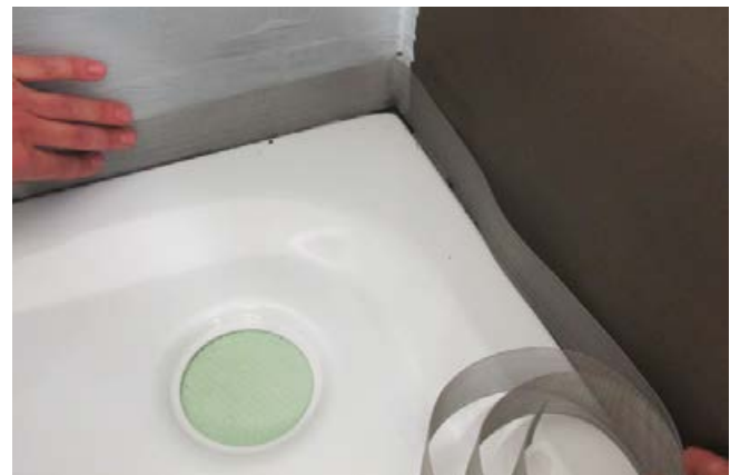
Das Einlegen der Schutzeinlage findet beim Fliesenlegen statt.
