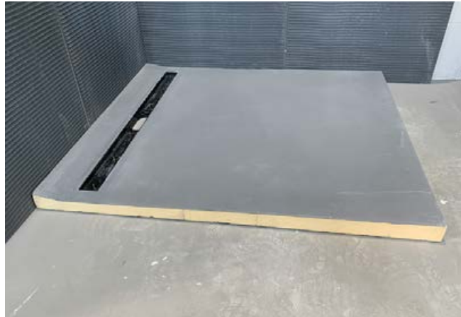
Die plattenförmige Abdichtung hat ihren Ursprung im Bereich des Duschboards.
