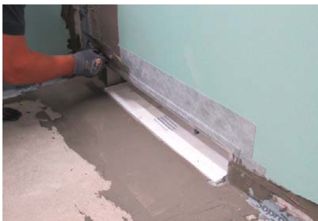
5 Die Rinne wird unter Zuhilfenahme von Dichtbändern/Armierungsgewebe und Sopro TurboDichtSchlämme 2-K eingedichtet.
