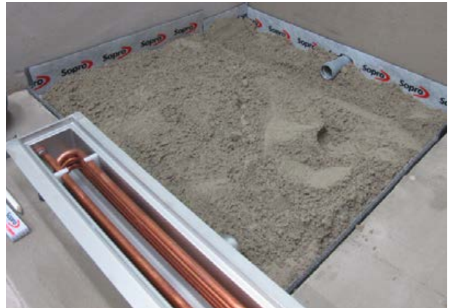
2 Versetzen der Rinne in den Zementestrich, hergestellt mit Sopro Rapidur® M1/Sopro Rapidur® M5.
