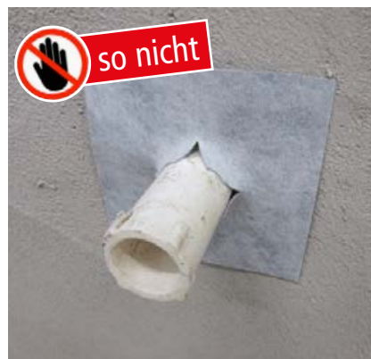
Die Dichtmanschette wurde eingeschnitten, um sie über den Baustopfen stülpen zu können.
