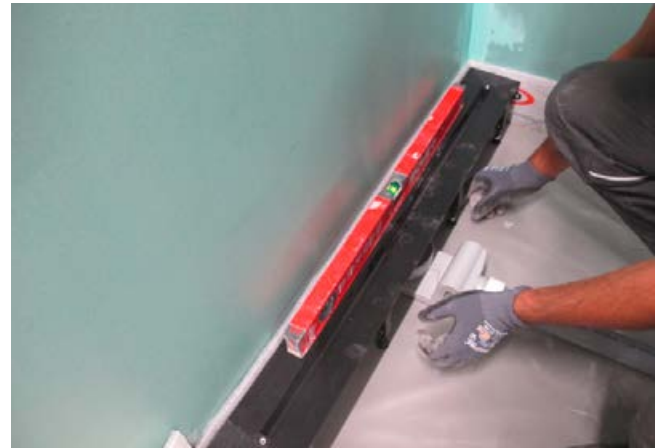
2 Vor dem Estricheinbau ist die Rinne auf Höhe auszurichten.
