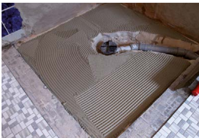
3 Das Duschelement wird mittels Fliesenkleber (Sopro's No. 1) auf der planebenen Fläche verklebt.
