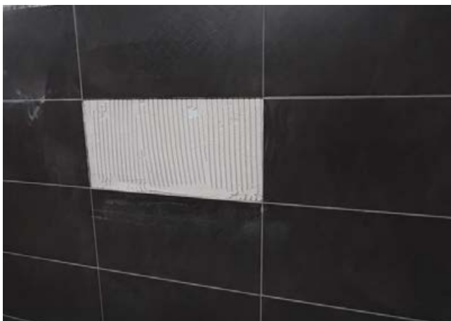
6 Alle Fliesenstücke sind entfernt.
