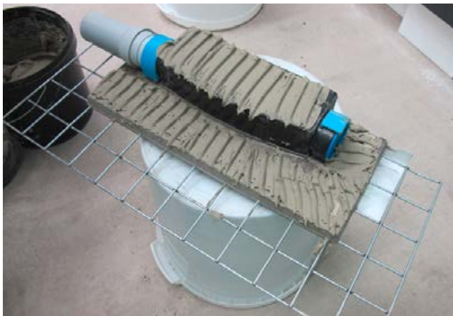
1 Abspachteln des Dallmer Bodenablaufelementes mit Sopro's No.1 für einen guten Haftverbund zum Estrichmörtel.
