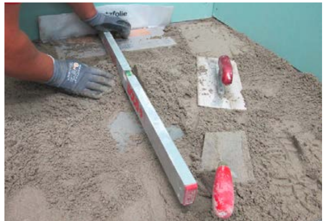
2 Einbau des Bodenablaufelementes in den Estrich mit Sopro Rapidur® M1/Sopro Rapidur® M5 mit entsprechendem Gefälle.
