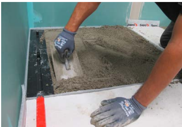
3 Der Rinnenkörper ist mit Sopro Rapidur® M5 zu unterfüllen. Anschließend ist die Estrichfläche herzustellen.
