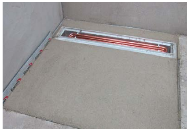
4 ACO Energiesparrinne mit Sopro Rapidur® M1/Sopro Rapidur® M5 schnell und einfach eingebaut.
