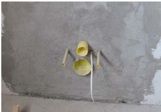
Wandfläche mit Zementmörtel (Sopro RAM3®) verputzt/gespachtelt.
