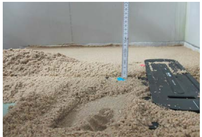
4 Die Dünnschichtigkeit über dem Ablauf ist mit dem harzgebundenen Mörtel lösbar.
