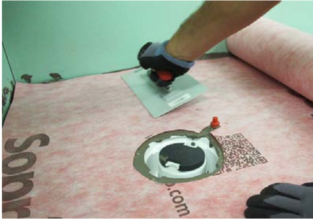
3 Die Sopro AEB® Abdichtungs- und Entkopplungsbahn ist mit Druck in den Sopro Fixier- & DichtKleber einzuarbeiten.
