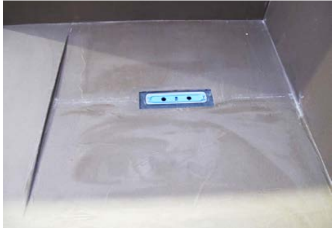
2 Abgedichtete Fläche, bereit für die Fliesenverlegung.
