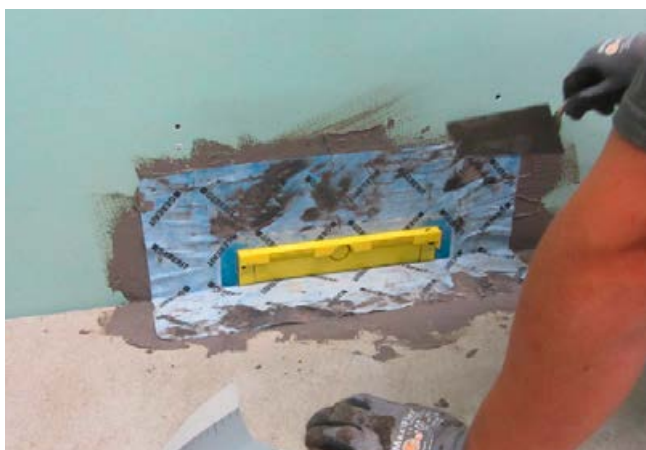
5 Eindichten und Fixieren der Geberit-Manschette mit Sopro TurboDichtSchlämme 2-K.
