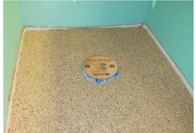
5 Bodenablauf eingebunden in den harzgebundenen Estrich (Sopro BauHarz + EpoxiEstrichKorn), bereit für den Abdichtprozess.
