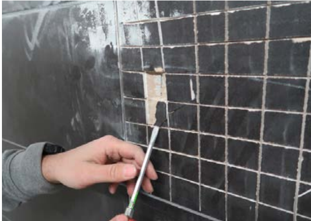
5 Heraushebeln der einzelnen Fliesenstücke mit einem Schraubenzieher.
