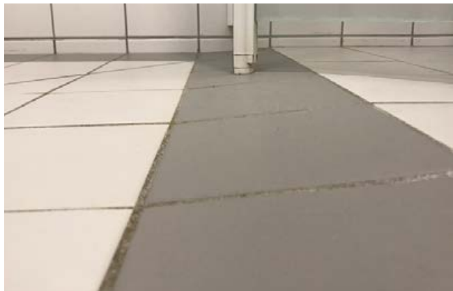
Gut erkennbar ist die Schrägstellung der Formfliese.
