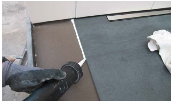
Mit Racofix® Montagekleber wird der Bereich zwischen Fliesenunterkante ...
