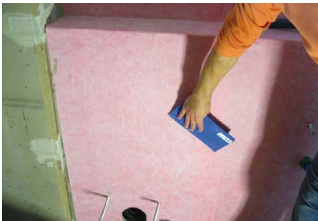
3 Die passgenau zugeschnittene Sopro AEB® Abdichtungs- und Entkopplungsbahn in die frische Klebeschicht einlegen und von der Mitte her fest andrücken.
