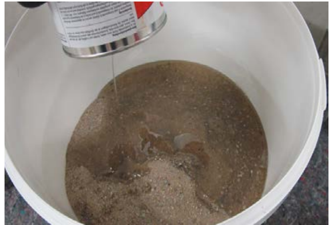
2 Anmischen von Sopro BauHarz und Sopro EpoxiEstrichKorn zu einem harzgebundenen Estrichmörtel.
