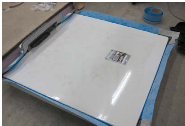
2 Die Duschfläche hat umlaufend nun eine Flanschfläche, an welche die Verbundabdichtung angeschlossen wird.
