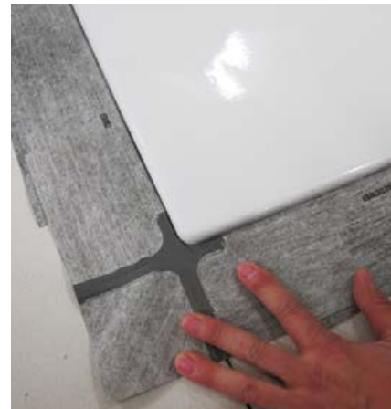
3 Formteile und Bänder müssen mindestens 50 mm breit überlappen und anschließend wasserdicht verklebt werden.
