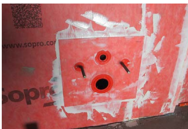
Die Sopro AEB® WC Wandmanschette ist fest verklebt, die Montage der Toilette kann nach der Fliesenverlegung erfolgen.
