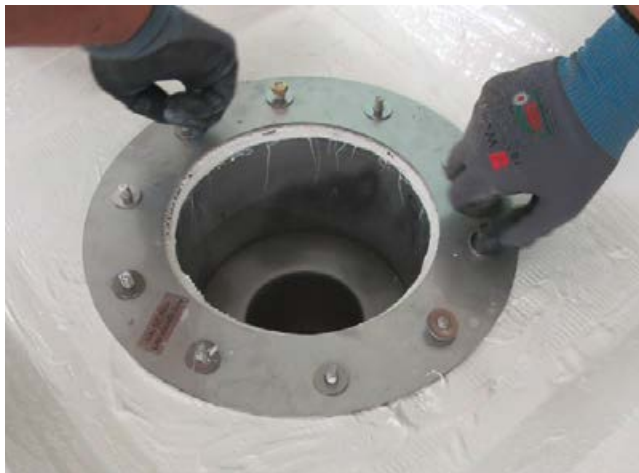
Abgedichtete Mulde. Der Pressflanschring wird aufgeschraubt. Die angefasten Estrichflächen sind gut zu erkennen.
