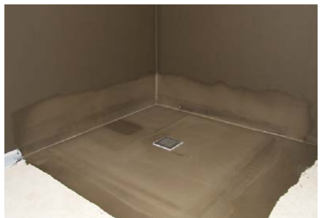
6 Abgedichtete Fläche, bereit für die folgende Fliesenverlegung.
