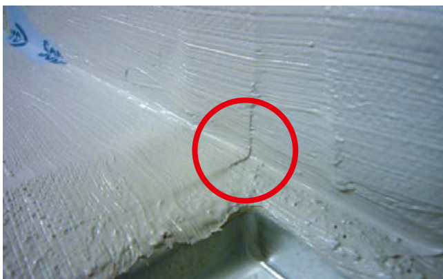
Sopro Dichtband mit Falz liegt nach den Abdichtarbeiten press an – eine Kanalbildung und Hinterläufigkeit ist nicht gegeben.
