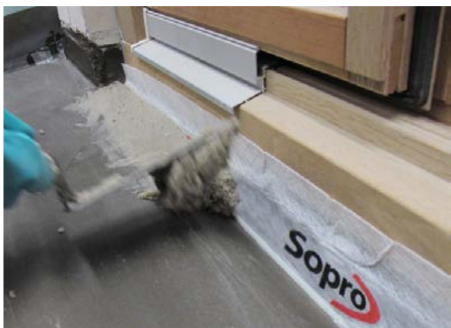
5 Nach dem Einstellen eines Randdämmstreifens wird die Vertiefung mit einem schwindarmen und kapillardichten Reaktionsharzmörtel verfüllt.
