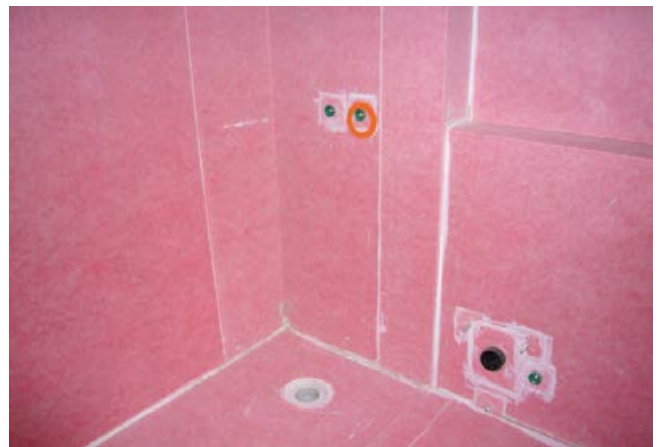
4 Alle Stöße sowie die Manschetten im Bereich von Durchdringungen (Rohre, Bodenabläufe etc.) sind mit Sopro Racofix® Montagekleber (S) oder Sopro Fixier- & Dichtkleber wasserdicht zu verkleben.
