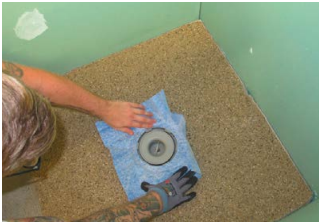
6 Entfalten der werkseitig aufgeschweißten Manschette.
