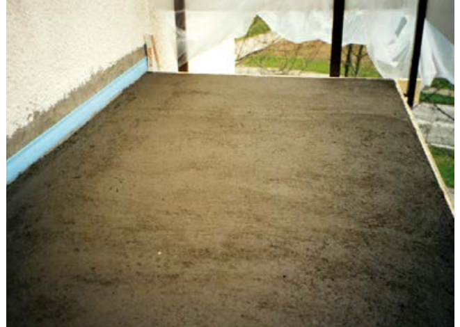
2 Mit Gefälle vorbereitete Fläche zur Aufnahme der Verbundabdichtung (Sopro TurboDichtSchlämme 2-K).
