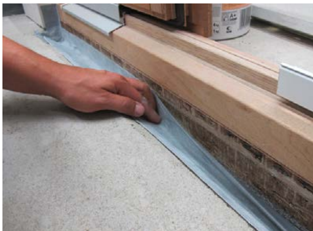
2 Einkleben des Sopro FlexDichtBandes in die abzudichtende Fuge.
