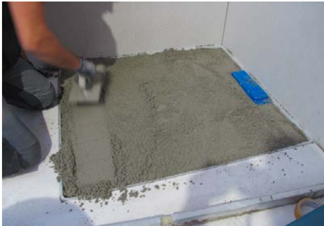
1 Einbau des Bodenablaufs mit schnell erhärtenden Estrich (Sopro Rapidur® M5).
