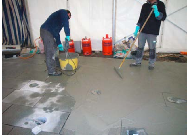
Sollen Außenflächen in der kalten Jahreszeit ausgeführt werden, sind diese durch Einhausung und ggf. Heizen beim Einbau zu schützen.
