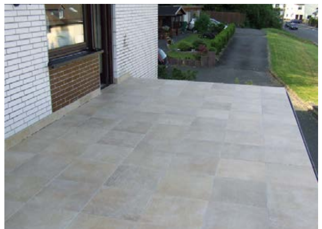
6 Fliesen verlegt mit hochflexiblem Dünnbettmörtel Sopro megaFlex S2 und verfugt mit Sopro FlexFuge plus.
