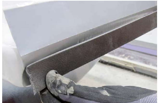
2 Ankleben eines Schaumstoffstreifens zur Vermeidung von Schallbrücken bei der Montage der Badewanne.
