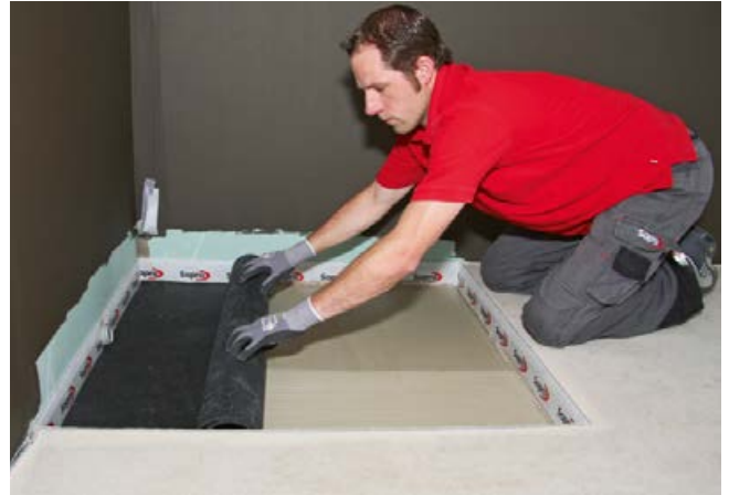
2 Verkleben einer Schallschutzbahn auf der planebenen Fläche mit Sopro's No.1.
