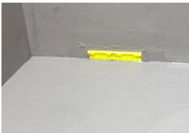
6 Abgedichtete Boden- und Wandflächen, nach der Trocknung bereit für die Fliesenverlegung. Keramische Beläge sowie Naturwerksteinbeläge lassen sich hier wie folgt (keine Aufkantung vorhanden) sehr gut verlegen.
