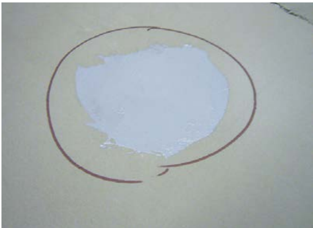
Sauber aufgefüllte Messstelle und somit ergänzte Abdichtfläche.
