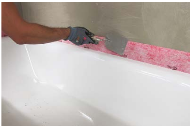
7 Ankleben der Bänder mittels flüssigen Abdichtstoff (Sopro Flächen-Dicht, Sopro DichtSchlämme Flex) an der Wand.
