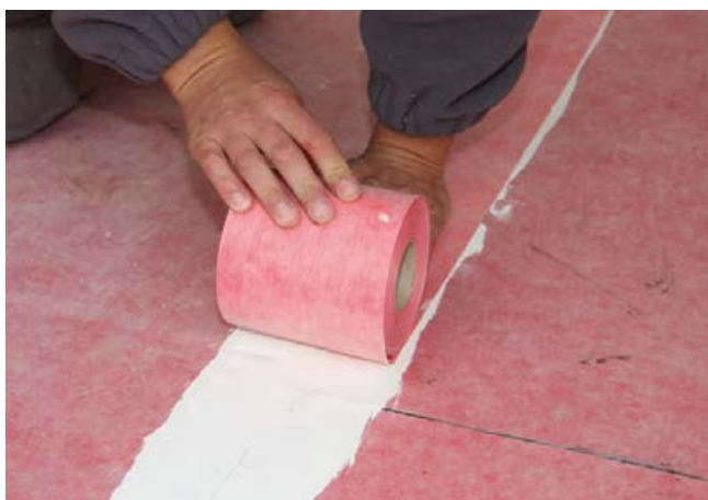
9 Überkleben des Stoßbereiches mit dem Sopro AEB® Dichtband. Optional kann die wasserdichte Verklebung des Dichtbandes auch mit Sopro Racofix® Montagekleber S, Sopro TurboDichtSchlämme 2-K oder ebenfalls Fixier- & DichtKleber erfolgen.
