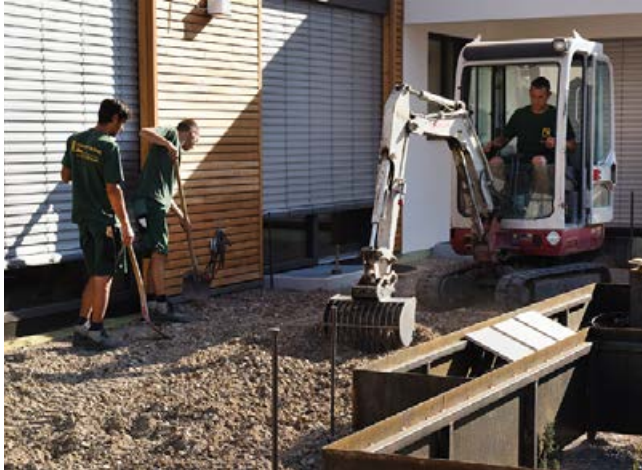
Einbau der ungebundenen Frostschutzschicht.
