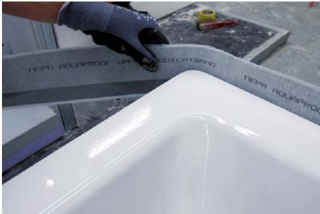
1 Ankleben des Wannenabdichtbandes (System MEPA – Pauli und Menden GmbH) an den Wannenrand.
