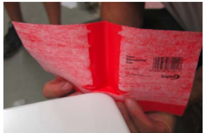
2 Ankleben der Sopro WannendichtEcke, welche sich im unteren Bereich an den Radius der Wanne anpasst und im Bereich der Wandanbindung einen 90°-Winkel besitzt.
