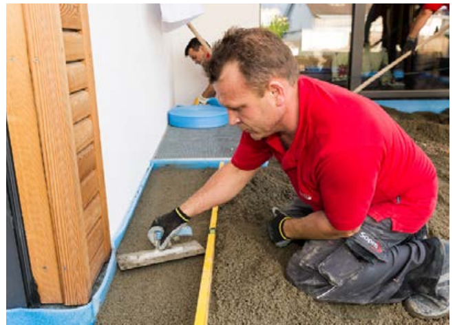
Verdichten und Abziehen der drainagefähigen Mörtelschicht auf gewünschter Höhe.
