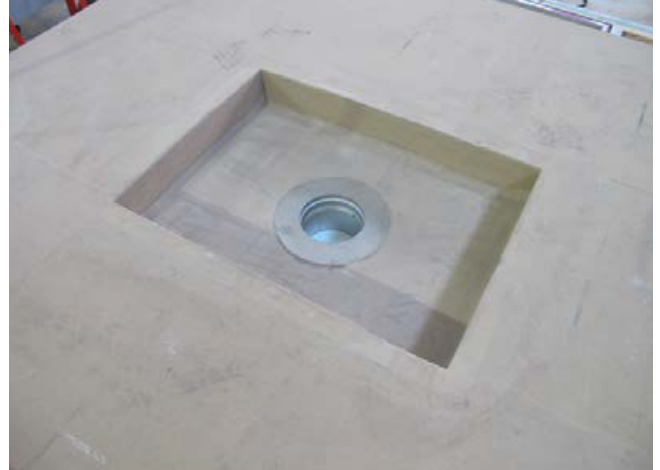
Vertiefung im Boden für den Einbau einer Rinne/Bodenablauf.
