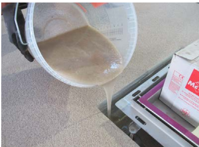
Verguss der Rinne mit einem kapillardichten Reaktionsharz-Quarzsand-Gemisch.
