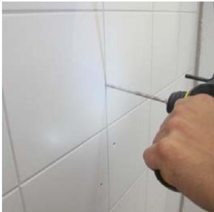
Bohren von Löchern in der abgedichteten Fliesenwand.
