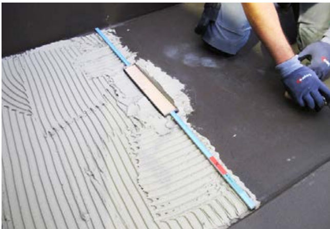
3 Fliesenverlegung mit Einbau der Sammelschienen und Entwässerungsbauteil Dallmer.
