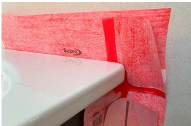
10 Am Wanneneende ist mittels der Multiecke ein senkrecht verlaufen- der Abschluss zum Boden des Badezimmers herzustellen.
