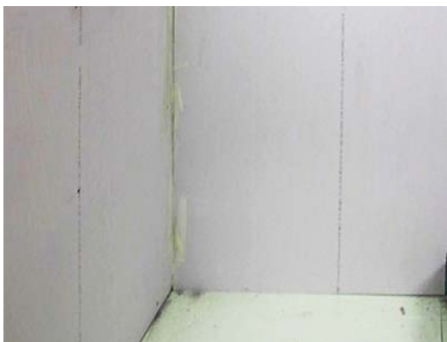
Zementgebundene Trockenbauplatten für den Bau von Wänden in einer Duschanlage.
