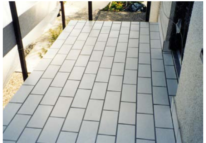
Balkon mit Fliesenbelag.
