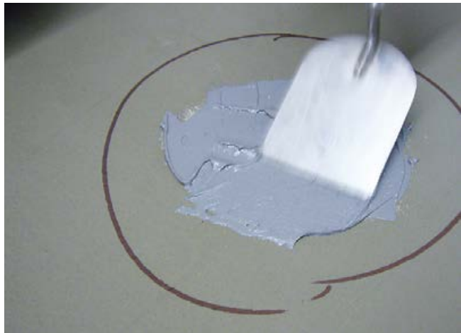
Verfüllen der Messstelle mit dem Verbundabdichtungsmaterial.
