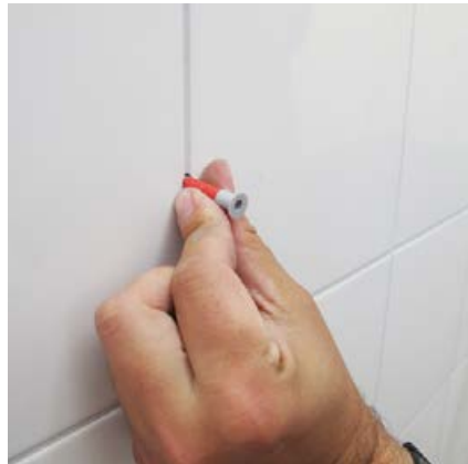
Setzen des Sopro FliesenVerbund-Abdichtungsdübels.
