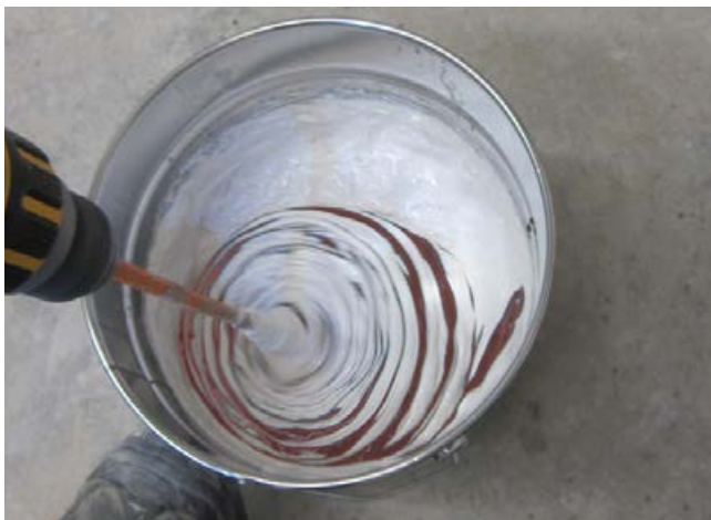
7 Das FlächenDicht flexibel Kontrastmittel wird in das Sopro PU-FlächenDicht eingemischt – eine graue Farbgebung entsteht.
