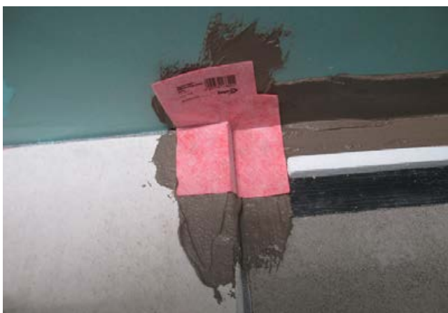
5 Da die Duschfläche im Gefälle liegt, ist der Höhenausgleich mit dem Sopro AEB® Höhen-Pass-Stück problemlos eindichtbar.
