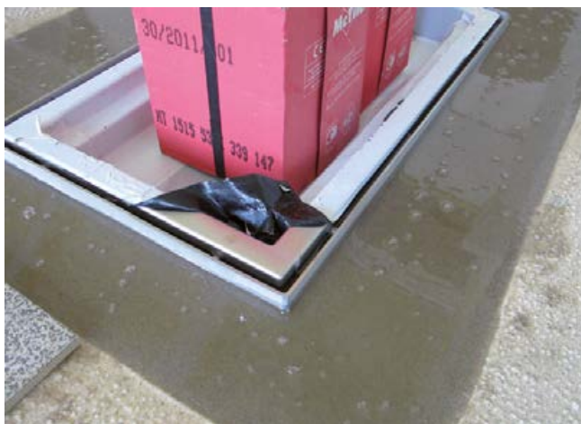
Kapillardichter Verguss der Rinne mit einem Epoxidharz-Quarzsandgemisch (Sopro EpoxiGrundierung 1 : 1 : 1 gemischt mit Sopro Kristallquarzsand und Sopro Quarzsand grob). Die Rinne ist durch Ballast gegen Aufschwimmen zu sichern.
