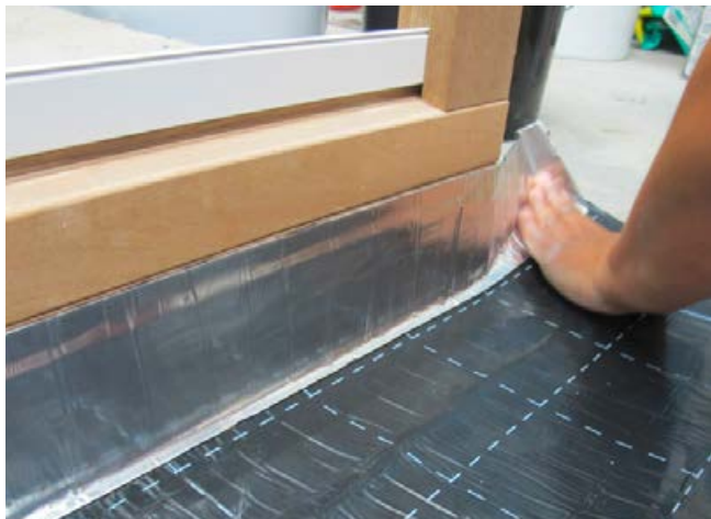
1 Bahnabdichtung mit SoproThere® Abschlussband Aluminium am Türelement.
