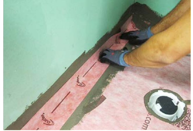
4 Einkleben der Formteile (Ecken und Bänder).
