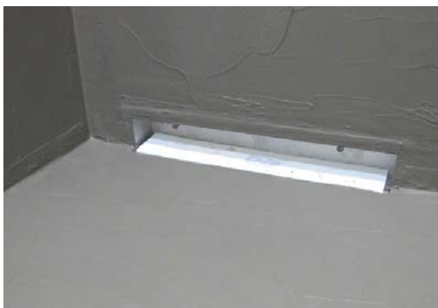
6 Abgedichtete Duschfläche, bereit für die folgende Fliesenverlegung.
