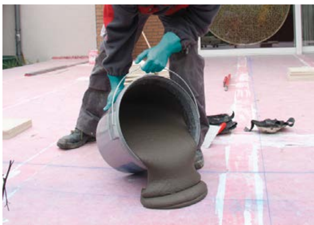
10 Sopro megaFlex S2 – flexibler Dünnbettmörtel mit Fließbetteigenschaften.
