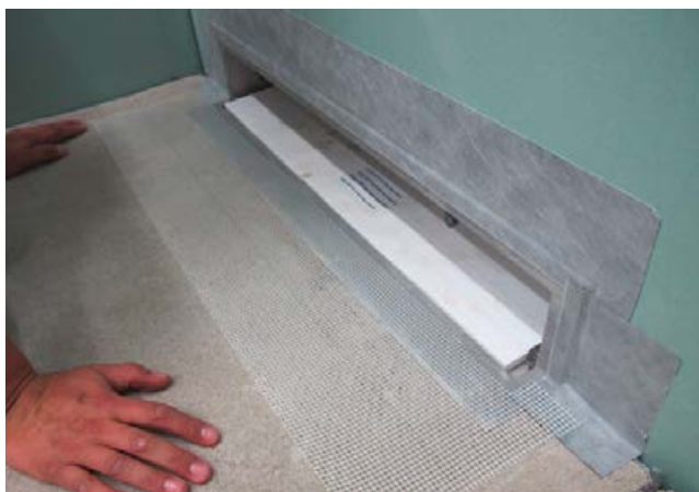
4 Duschfläche (Sopro Rapidur® M1/Sopro Rapidur® M5) mit angeschlossener Wandentwässerungsrinne.
