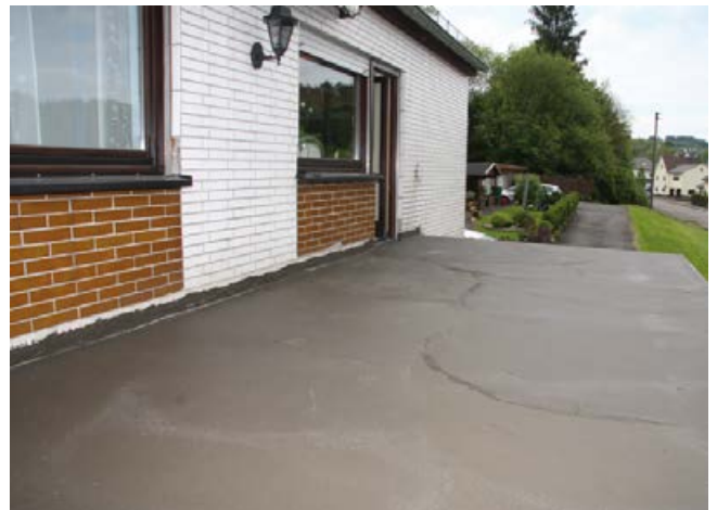
4 Abgedichtete Balkonfläche mit Sopro TurboDichtSchlämme 2-K in zwei Arbeitsgängen mit einer Gesamttrockenschichtstärke von 2 mm.
