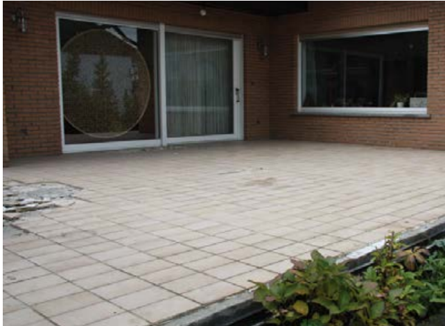
1 Alter, tragfähiger Fliesenbelag auf einer Terrasse.
