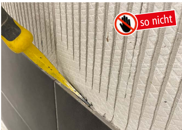
Kein heraushebeln mit Meisel. Dies führt zu Löchern und Brüchen in der Trockenbaukonstruktion.
