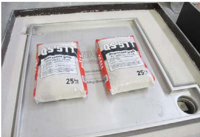
Sichern der Wanne gegen Aufschwimmen beim Vergießen durch Beschweren mit z. B. Quarzsandsäcken.
