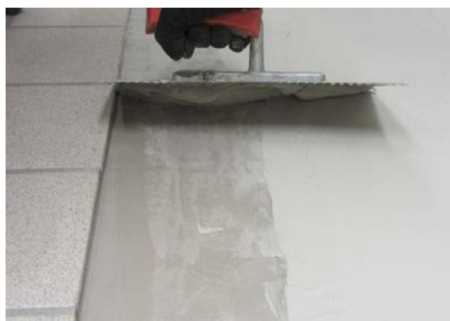
4 Überlappendes Andichten der Duschfläche an die Bestandsfläche.
