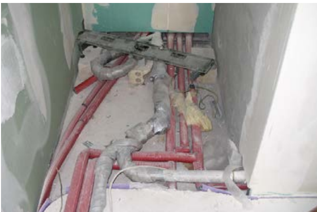
Die Führung von Versorgungsleitungen in den ausgesparten Bereichen erschweren den Abdichtungsprozess. Nach DIN 18534 ist dies zukünftig zu vermeiden.
