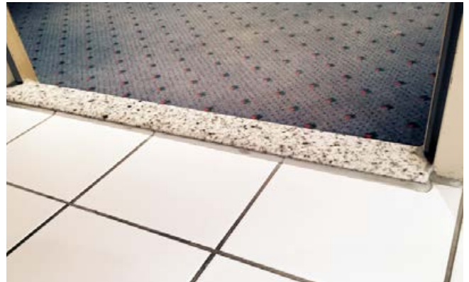
Belag mit Naturwerksteinschwelle.
