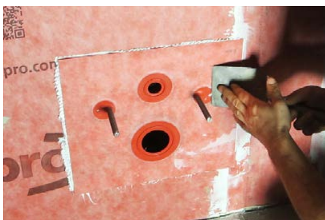
Die Sopro AEB® WC Wandmanschette wird fest in das Kleberbett eingedrückt/eingearbeitet.
