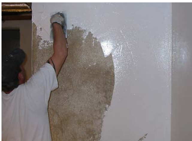
4 Applikation von Sopro PU-FlächenDicht an der Wand in zwei Arbeitsgängen – Gesamtmindestschichtdicke 1 mm.
