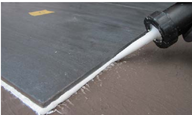
... und Verbundabdichtung kapillardicht verschlossen
