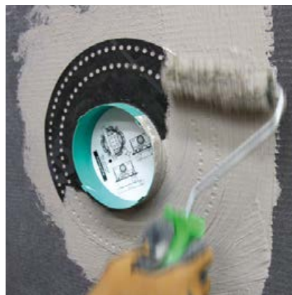
Wandunterputzarmaturen, die noch keine Manschetten mit elastischen Zonen besitzen.
