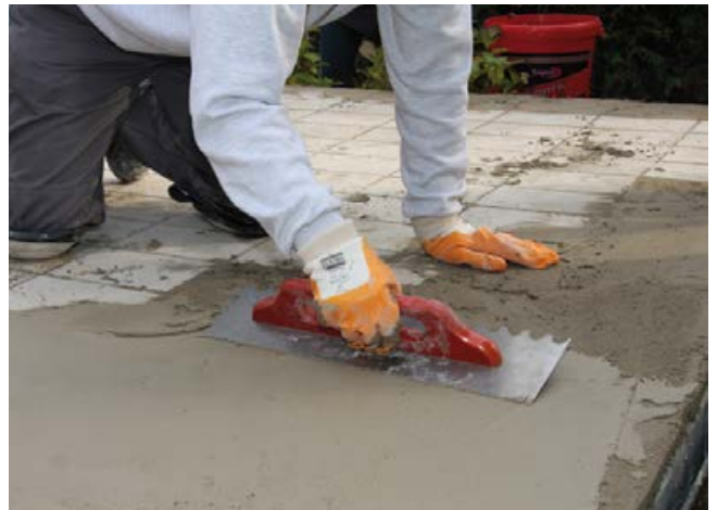
2 Ausgleichen von Fehlstellen mit Sopro RAM 3® als vorbereitende Arbeit für die Abdichtarbeiten.
