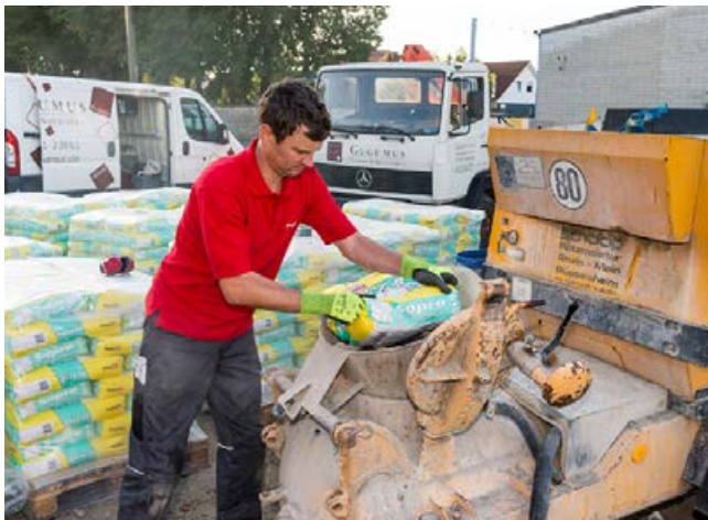
Anmischen des drainagefähigen Mörtels für die Bettungsschicht mittels Estrichpumpe.
