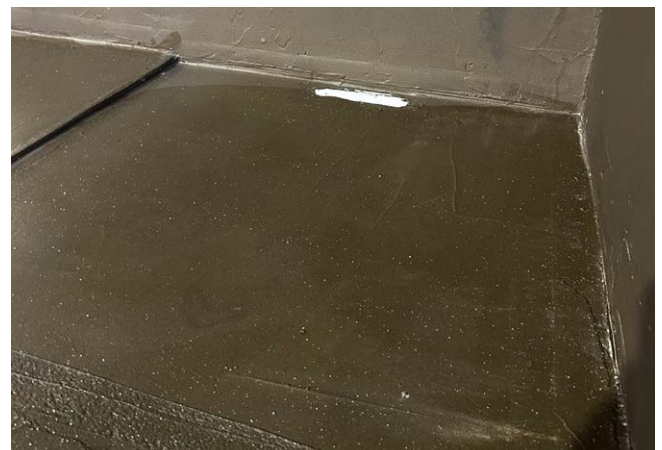
4 Abgedichtete Fläche bereit für den Einbau der Sammelschiene und die Fliesenverlegung.
