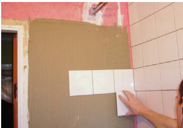
5 Eine Fliesenverlegung kann kurze Zeit später, nach Beendigung der Abdichtungsarbeiten, auf der Sopro AEB® Abdichtungs- und Entkopplungsbahn mit einem Dünnbettmörtel (Sopro's No. 1) erfolgen.
