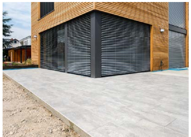
Verlegter Belag, bereit für die Verfugung mit Sopro FlexFuge plus.
