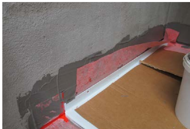
Andichten der Wannenzarge mittels Dichtband und Verbundabdichtung an die Wandfläche.
