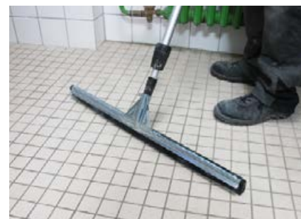
Entfernung des Wassers mittels Gummischieber.
