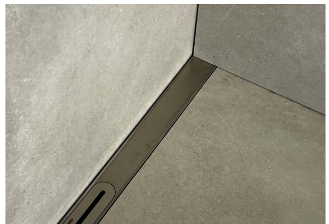
6 Fertig erstellte Dusche.
