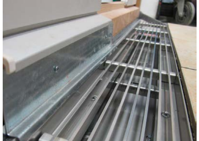
8 Zum Schutz der Abdichtung und einer sauberen Ableitung des Wassers von der Tropfkante des Türelementes in die Rinne (ACO) ist ein Blech vom Spengler einzusetzen und zu fixieren.
