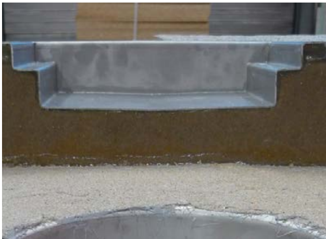
Sehr gut ist in dem Schnittmodell der kapillardichte Verguss unterhalb des Rinnenkörpers erkennbar.
