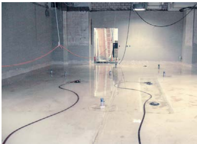
Prüfung der Bodenabdichtung auf Dichtigkeit durch Flutung.
