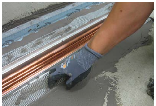
6 Eindichten der Rinne und Abdichten der gesamten Fläche mittels Dichtbändern, Gewebeeinlagen etc. in der Kombination mit z.B. Sopro DichtSchlämme Flex 2-K.
