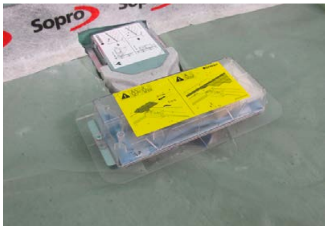
1 Bodenablauf in der Duschfläche positioniert.
