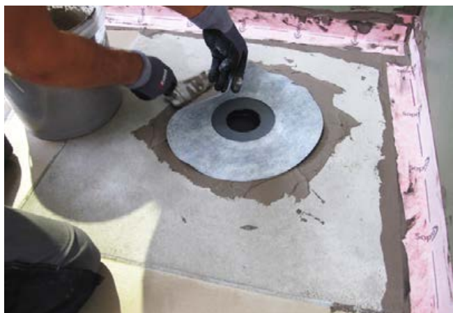
2 Eindichten der Manschette mit Sopro DichtSchlämme RS.
