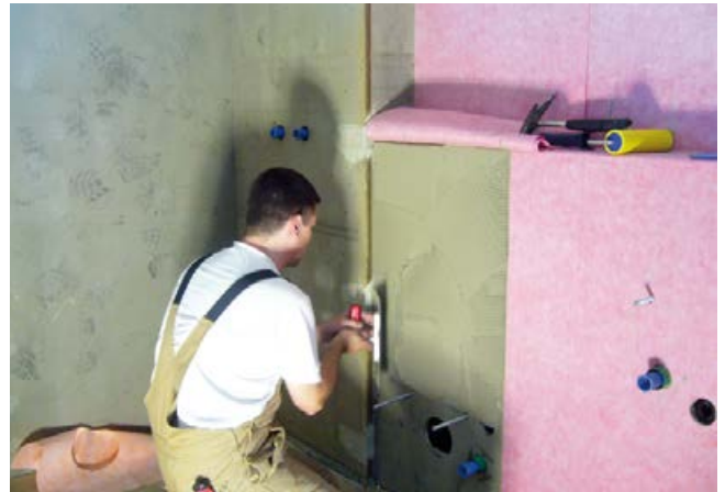
2 Aufspachteln des Fliesenklebers (Sopro's No.1) mit einer feinen Zahnpachtel oder aufwalzen von Sopro Fixier- & Dichtkleber. Die Flächen sind im Vorfeld mit Sopro Grundierung zu grundieren.
