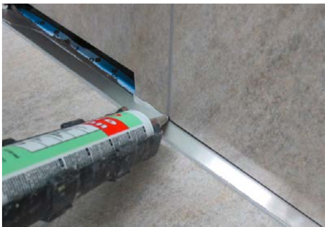
11 Die Wassersammelschiene hat einen Abstand zur Wand von ca. 5 mm (wegen des schwimmenden Estrichs). Die Fuge zur Wandfliese ist mit Silikon (Sopro SanitärSilikon) elastisch zu schließen.
