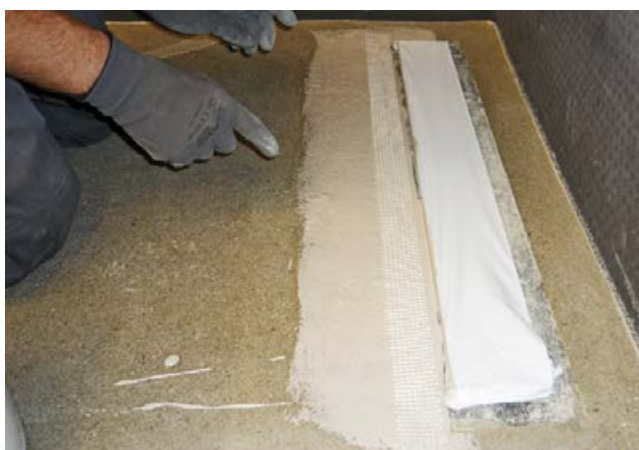
4 Eindichten des Rinnenkörpers mit Sopro DichtSchlämme Flex RS. Der Übergang wird durch Einlegen eines Armierungsgewebestreifens in die Verbundabdichtung verstärkt.
