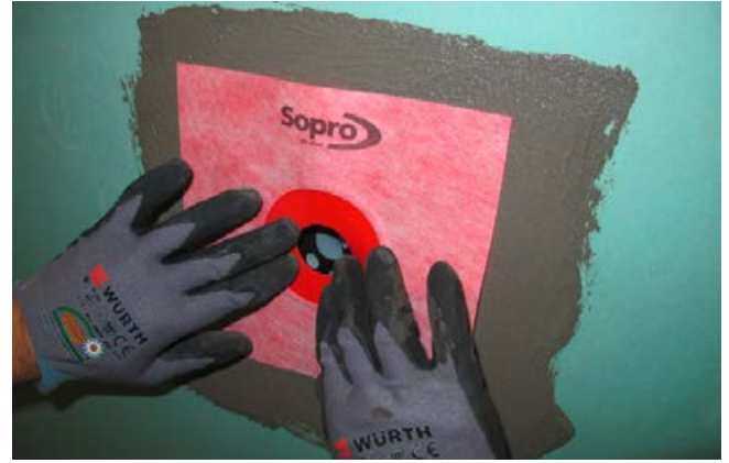
2 Einlegen der Sopro AEB® Wandmanschette.
