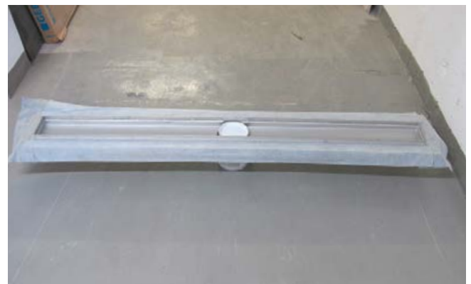
Eingebaute Schlitzrinne vor einem Türdurchgang im Bereich einer Großküche.
