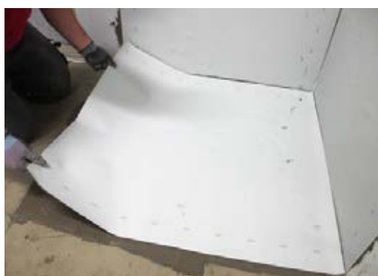
Verkleben der Sopro AEB® HD Bahn, z. B. mit Sopro VarioFlex® HF®.
