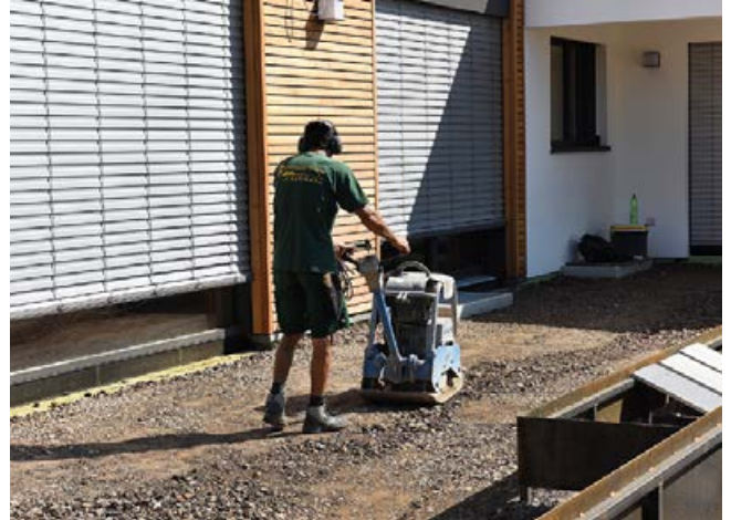
Verdichten der ungebundenen Trag- und Frostschutzschicht.
