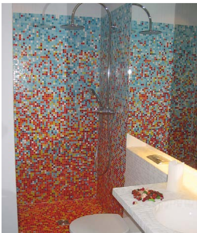
Privates Badezimmer mit Bodenablauf.
