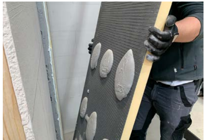
Verkleben der Sopro XPS Boards auf Batzen, weil die Wand uneben/schief ist. Anmerkung: Je nach Untergrundbeschaffenheit kann es sinnvoll sein, die Platten zusätzlich zu dübeln (gemäß DIN 18534, ist dies eine Sonderkonstruktion).
