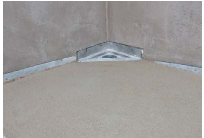
4 Duschfläche hergestellt mit Sopro Rapidur® M1/Sopro Rapidur® M5.
