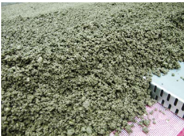
11 Der drainagefähige Verlegemörtel umschließt den Stichkanal.
