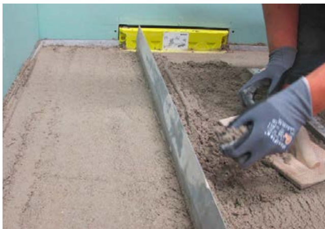
2 Einbau eines zementären Estrichs, hergestellt mit Sopro Rapidur® M1/ Sopro Rapidur® M5. Die Schutzabdeckung dient hierbei als Abziehhilfe.
