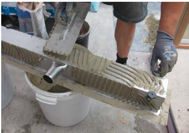
3 Für den besseren Haftverbund zum Estrich wird die Rinne vorher außenseitig mit Dünnbettmörtel abspachtelt.
