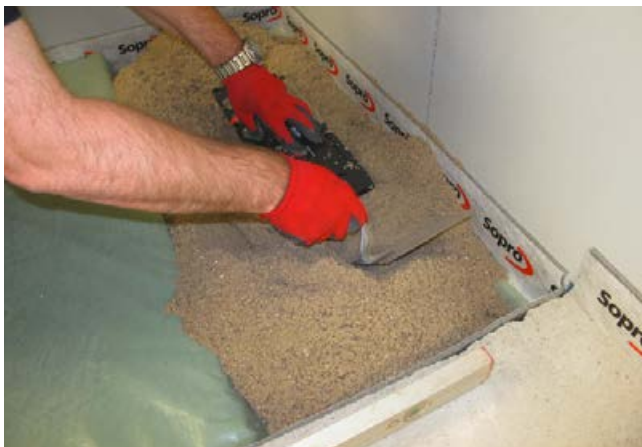
3 Verteilen des harzgebundenen Mörtels und Positionieren des Bodenablaufes.
