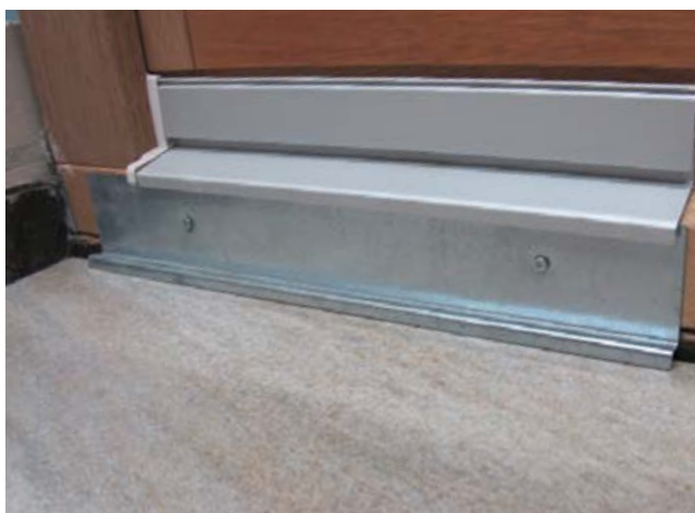
6 Die Fliesenverlegung erfolgt im Dünnbettverfahren mit Sopro megaFlex S2. Zum Türelement hin erfolgt der Abschluss mit einer Schiene.
