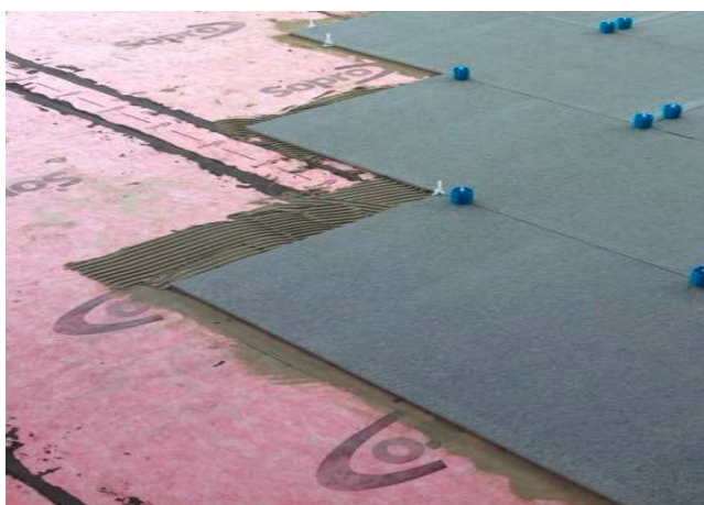
12 Einlegen der Platten (rückseitig abgespachtelt) in das vorbereitete Mörtelbett.
