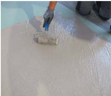
Auftragen des Sopro Fixier- & Dichtkleber FDK 415/1180 mittels Walze.
