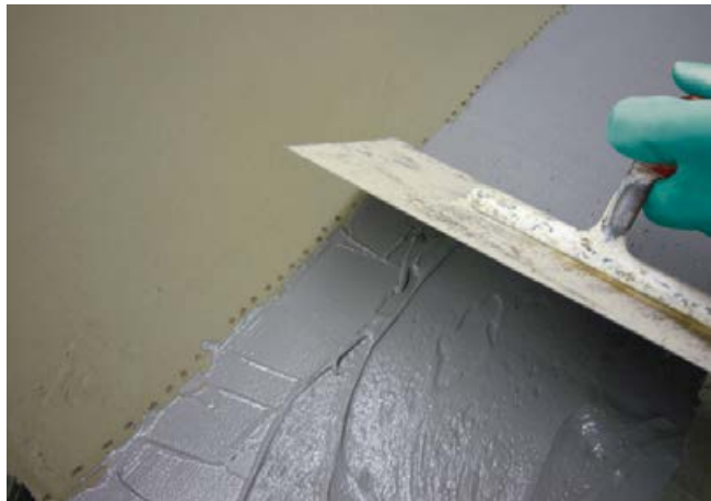
4 Flächiges, überlappendes Anarbeiten der neuen Verbundabdichtung an die Bestandsabdichtung, z. B. mit einem Glätter.
