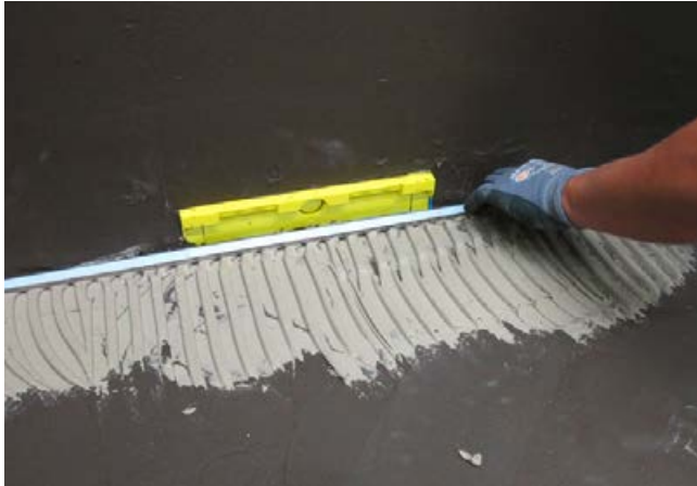
7 Vor dem Wandeinlaufelement wird eine Wassersammelschiene vollsatt mit Fliesenkleber (Sopro's No.1) auf der Verbundabdichtung verklebt.
