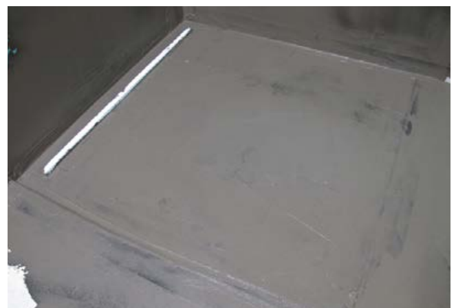
6 Fertig abgedichtete Fläche mit Sopro DichtSchlämme Flex RS, bereit für die Fliesenverlegung.
