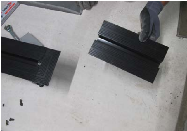
1 Das Rinnensystem ist auf die Belange des Raums (Duschfläche) kürzbar.
