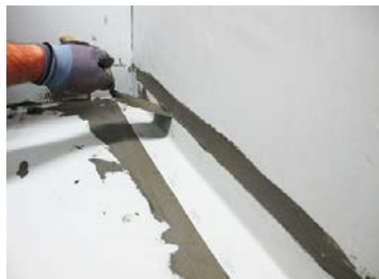
Dichtbänder und Formteile des AEB®HD-Systems lassen sich mit dem Sopro Fixier- & DichtKleber verleimen.
