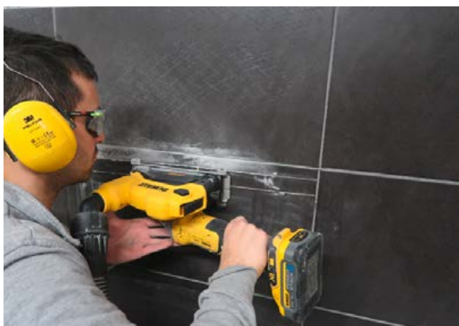
3 Einschneiden der betroffenen Fliese in einem Raster von ca. 5x5 cm.
