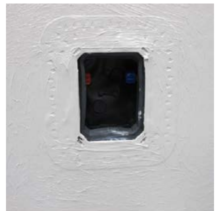
Sicheres Eindichten einer Wandarmatur (deren Manschette sich im Gehäuse befindet) mit Sopro Fixier- & DichtKleber oder Sopro DichtSchlämme Flex RS.
