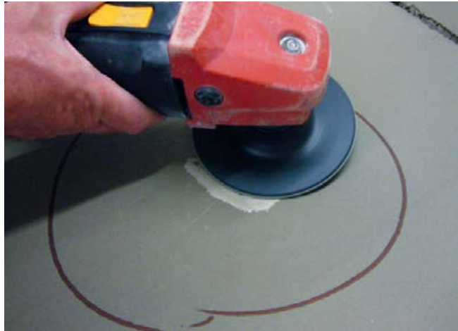
Anschleifen der Schnittkanten zur Herstellung einer Übergangszone.
