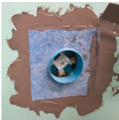
Wandunterputzarmaturen, die noch keine Manschetten mit elastischen Zonen besitzen.
