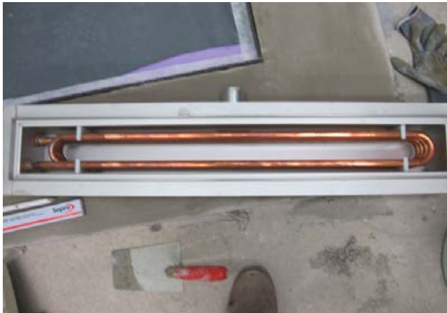
1 ACO Rinne mit Wärmetauscherkopperleitung zur Energieeinsparung. Über die Rinne findet eine Wärmerückgewinnung statt.
