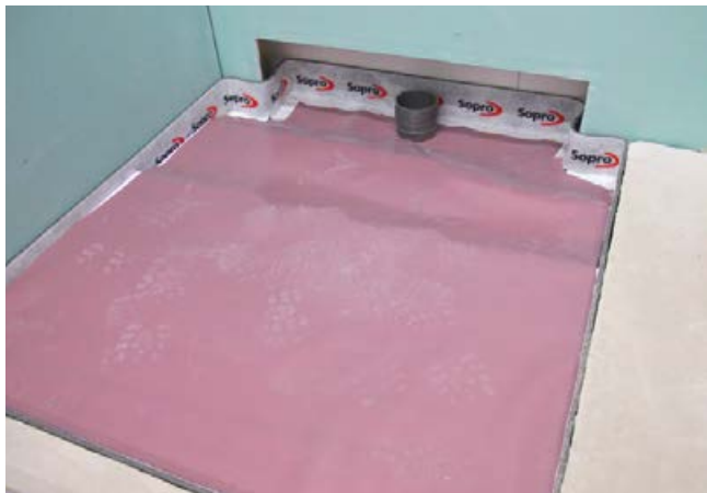
1 Vorbereitung der Duschecke mit Wandaussparung zur Aufnahme der Wandentwässerungsrinne.
