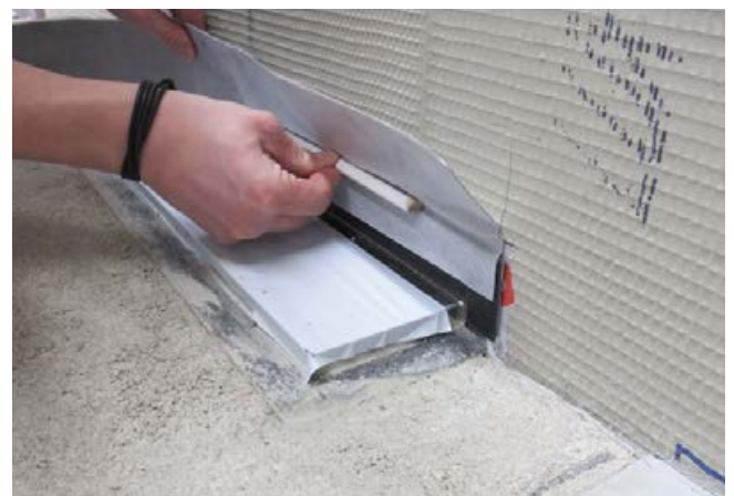
3 Verkleben des Sopro FlexDichtBandes mit Schlaufe als Übergang zwischen dem Metallflansch der Rinne und den angrenzenden Baustoffen.
