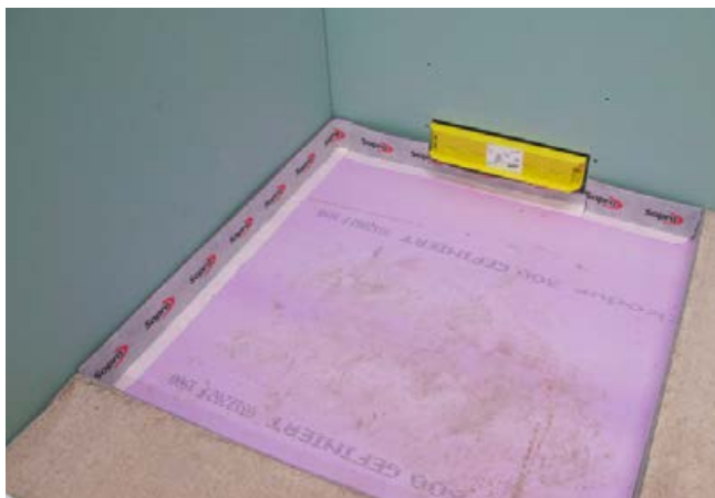
1 Wandeinlaufelement für Trockenbau- und Mauerwerkskonstruktionen (System Geberit) in Kombination mit schwimmender Estrichkonstruktion.
