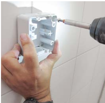
Montage der Steckdoseneinheit (Gira).
