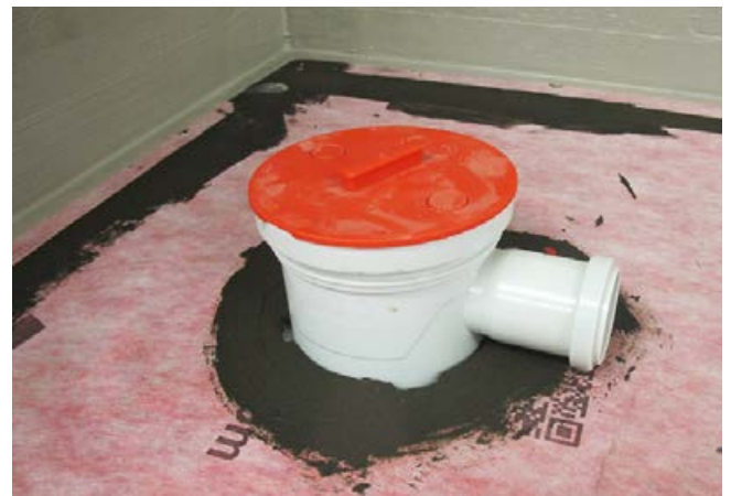
6 Montage des Zwischenentwässerungsaufsatzes.
