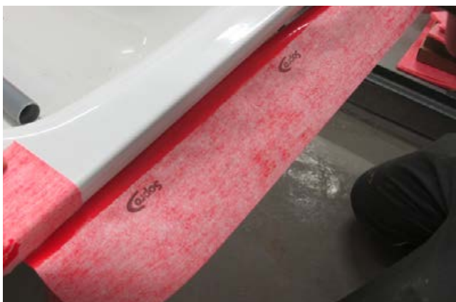
3 Das Sopro WannendichtBand ist mindestens 50mm überlappend an das Formteil Ecke anzukleben.
