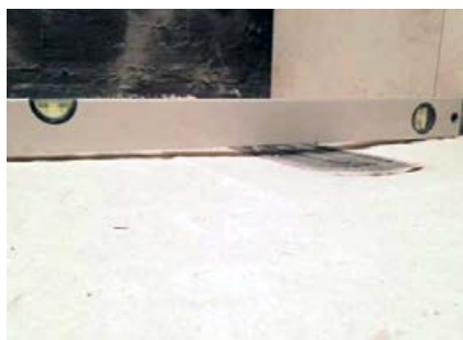
Gefälle in einer Dusche.
