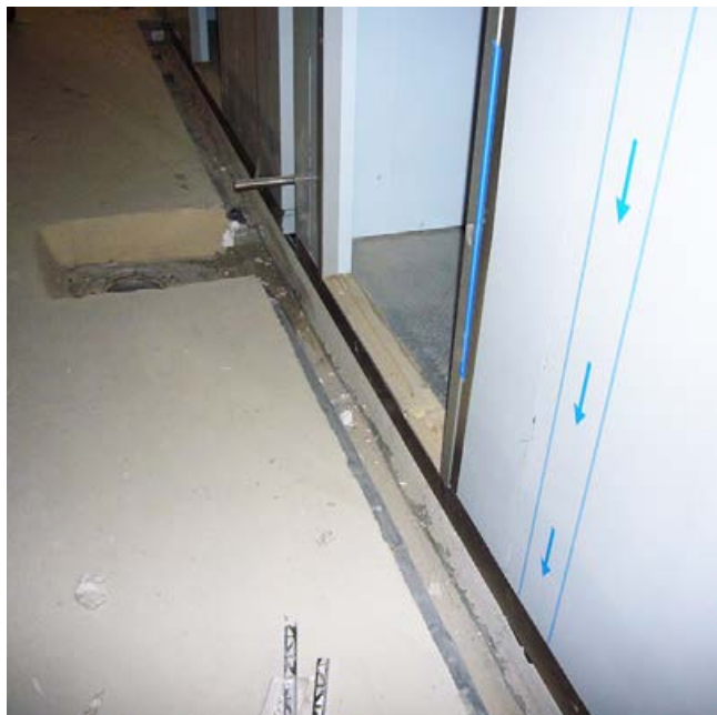
Kühlzelle in einer Großküche.
