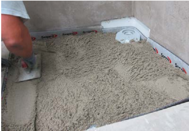
1 Vorbereitung der Eckentwässerung und Einbau des Estrichs Sopro Rapidur® M1/Sopro Rapidur® M5.
