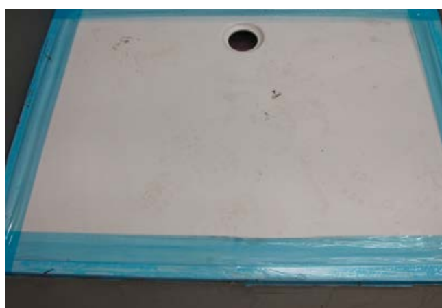
6 Die Duschfläche ist sauber und sicher in die Flächenverbundabdichtung eingebaut.
