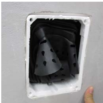
Sicheres Eindichten einer Wandarmatur (deren Manschette sich im Gehäuse befindet) mit Sopro Fixier- & DichtKleber oder Sopro DichtSchlämme Flex RS.
