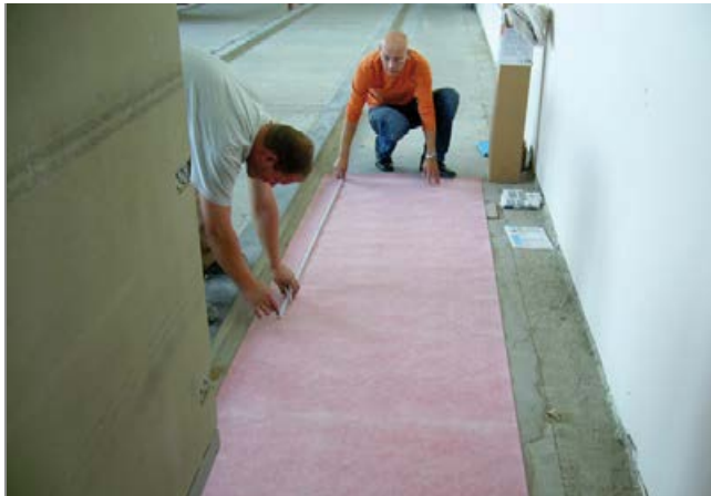
1 Zuschneiden der Sopro AEB® Abdichtungs- und Entkopplungsbahn für die anschließende Verlegung an Wand- und Bodenflächen.
