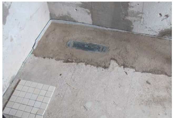
Duschfläche hergestellt aus Zementmörtel (Sopro Rapidur® M5).
