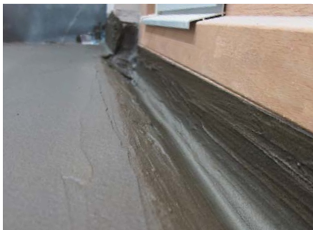
4 Abgedichtete Balkonfläche mit Anschluss an das Türelement.
