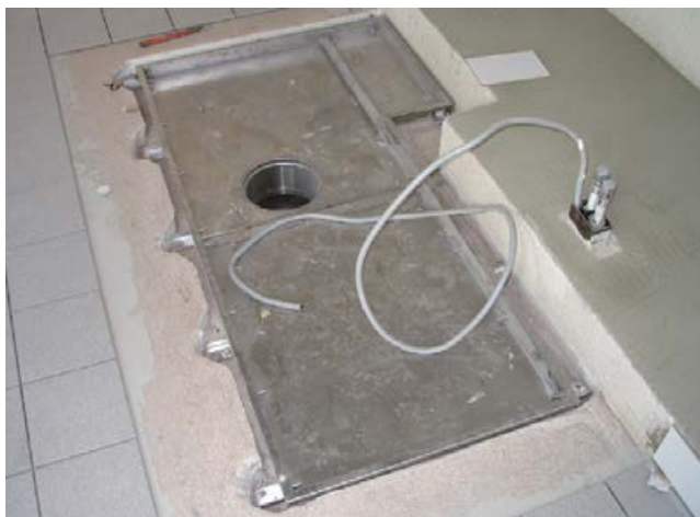
Eingesetzte Rinne in abgedichtete Rinnenmulde.
