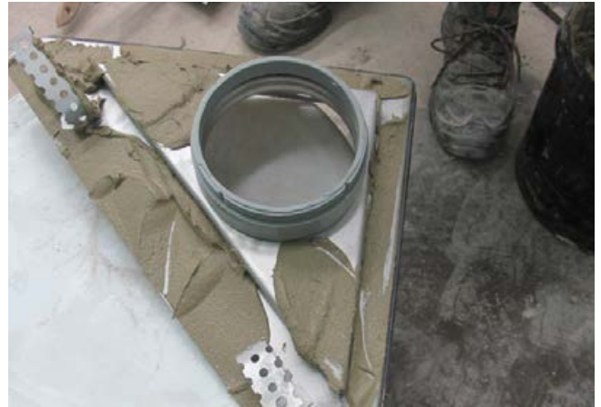
2 Zur Herstellung eines guten Haftverbundes zwischen Estrichmörtel und Eckentwässerungselement wird dieses rückseitig mit Sopro's No.1 abspachtelt.
