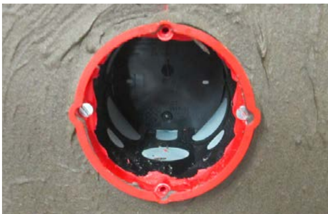
5 Eingedichtete Installationsdose (Firma Kaiser).
