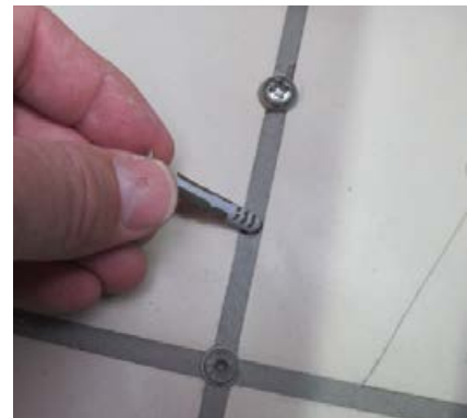
Einstecken des Dübels in das Bohrloch.
