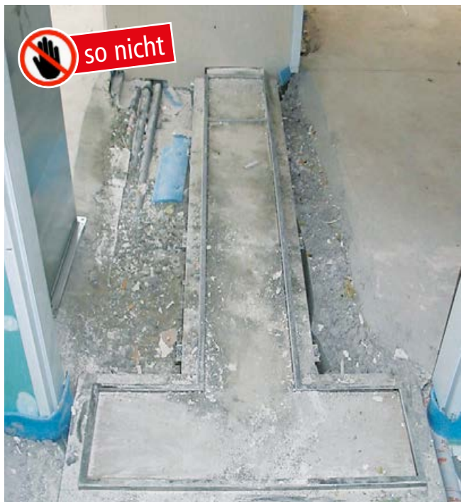
Türzarge und Rinne in Kombination – die Ausführung einer fachgerechten Abdichtung ist hier nicht möglich.
