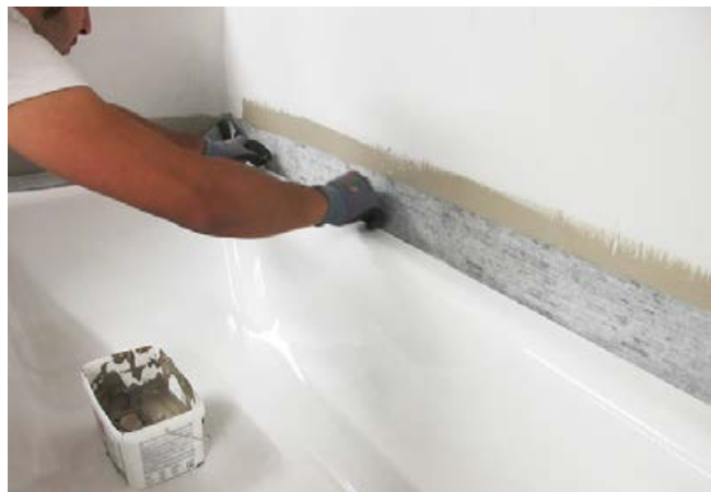
2 Eindichten des Franz Kaldewei GmbH & Co. KG-System-Bandes mit Sopro FlächenDicht flexibel.
