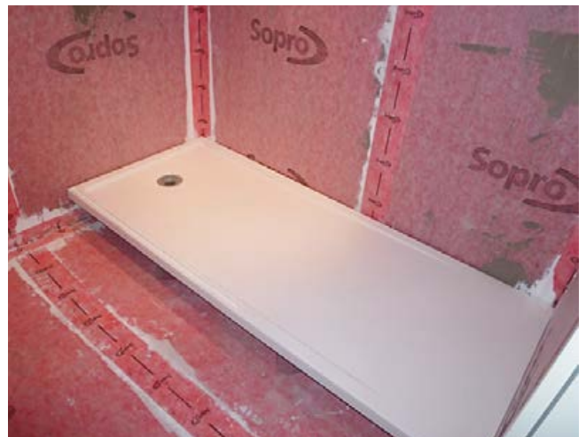
Abgedichtete Fläche, auf welcher die Duschwanne aufgestellt ist.
