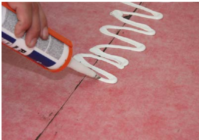
7 Auftragen des Sopro Racofix® Montageklebers zum Abdichten des Stoßbereiches.
