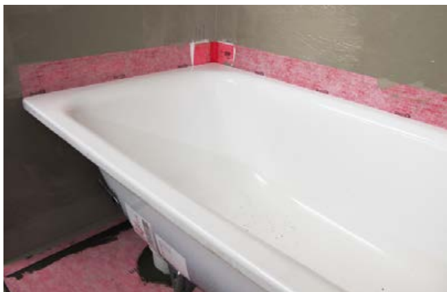
9 Wanne mittels Sopro Wannendicht-System eingedichtet. Die von der Wand kommende Abdichtung kann nun auf die Bänder appli- ziert werden.
