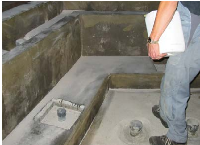
1 Aufbringen der Sopro EpoxiGrundierung, anschließendes Abstreuen mit Sopro Quarzsand fein.
