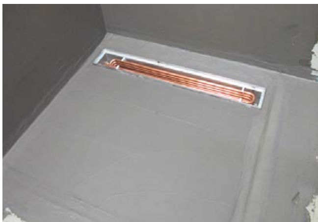
7 Abgedichtete Fläche mit der ACO Energiesparrinne.
