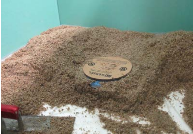
4 Ist der Aufbau sehr dünn, ist für die Herstellung des Estrichs ein harzgebundener Mörtel (Sopro BauHarz + EpoxiEstrichKorn) zu verwenden.
