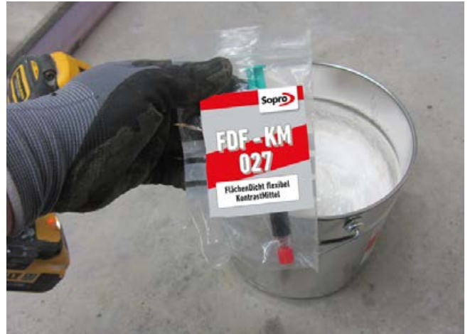
6 Sopro FlächenDicht flexibel Kontrastmittel kann dem Abdichtungsmaterial zugegeben werden, um eine bessere farbliche Unterscheidung zwischen Schicht 1 und Schicht 2 zu erhalten.
