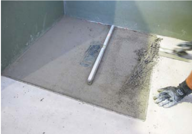
1 Einbau des Bodenablaufgehäuses in den schnell erhärtenden Estrich (Sopro Rapidur® M5).
