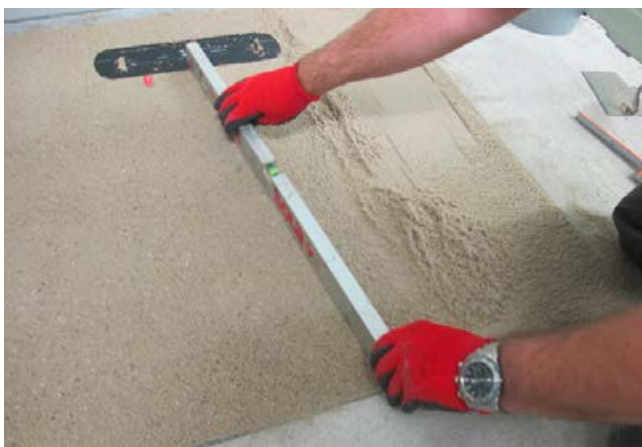
5 Der harzgebundene Mörtel lässt sich gut verarbeiten, abziehen und glätten.
