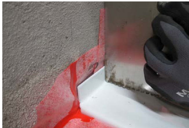
Wanne (Schmidlin) mit Zarge am Einbauort positioniert.
