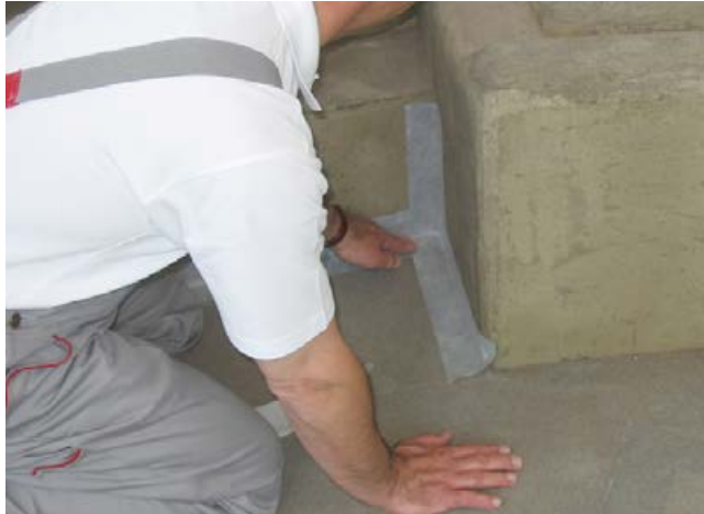
2 Verkleben von Sopro FlexDichtBand im Bereich von Bewegungsfugen.
