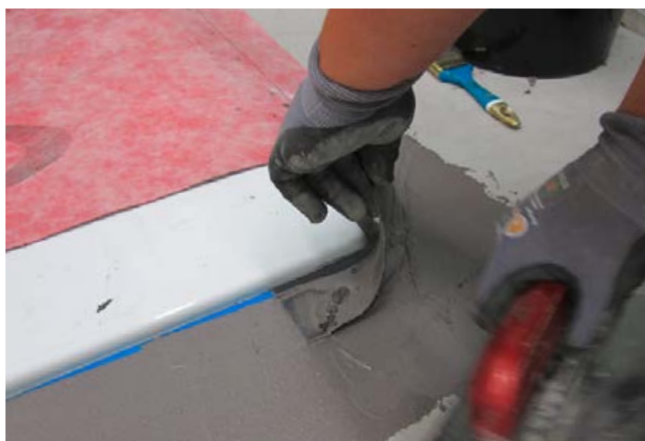
5 Umlaufend werden die Dichtbänder in die flüssige Flächenverbundabdichtung eingearbeitet.
