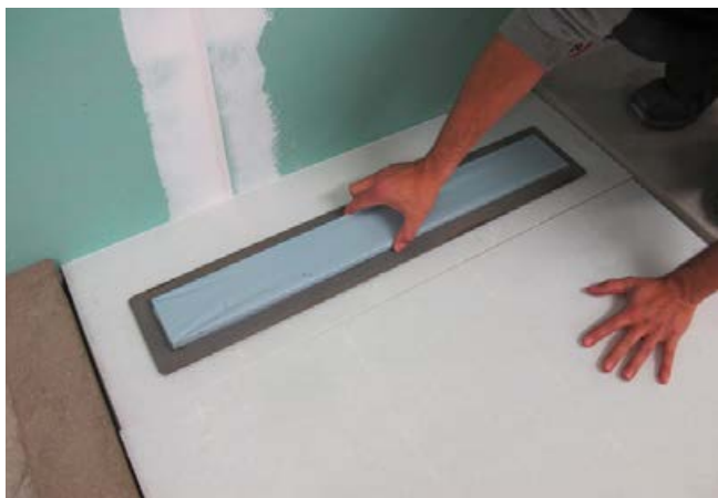
1 Einpassen der Rinne in das zuvor aufgestellte ACO Trockenbauelement.
