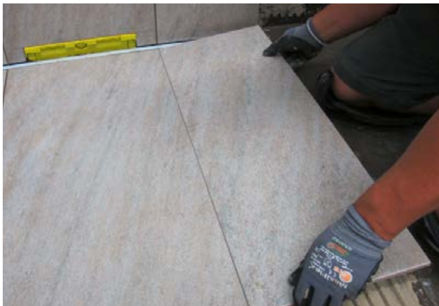
9 Die Fliesen werden an der Wassersammelschiene angearbeitet.
