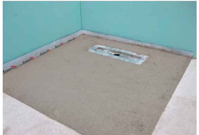
2 Duschfläche mit Gefälle zur Rinne, direkt in den frischen Estrich modelliert.
