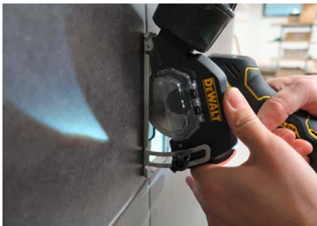
2 Einschneiden der umlaufenden Zementfuge, um die Fliese zu entspannen
