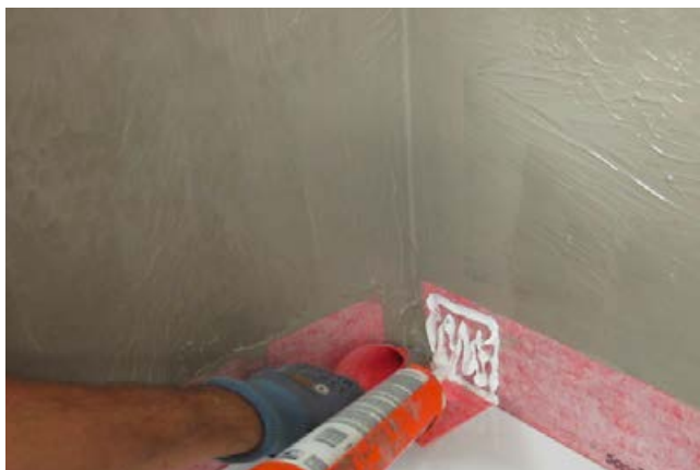
8 Wasserdichtes Verkleben der Formteile im Stoß-/Überlappungsbe- reich mit z. B. Sopro Racofix® Montagekleber.
