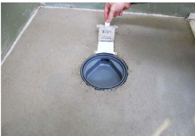
1 Punktablauf, eingebaut mit schnell erhärtenden Estrich (Sopro Rapidur® M5).
