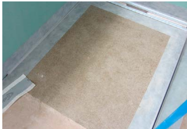
2 Die Rinne ist mit Sopro Rapidur® M1/Sopro Rapidur® M5 versetzt. Anschließend erfolgt die Verklebung der Dichtbänder.
