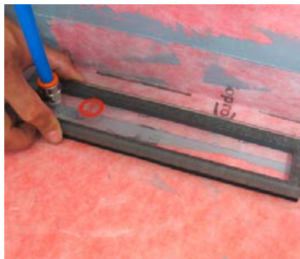
Alternativ mit der Unterdruckpumpe: Die Prüfschablone wird aufgelegt. Lässt sich ein Unterdruck (Vacuum) aufbauen, so ist der Stoß dicht. Wenn nicht, so ist eine Undichtigkeit gegeben, welche zu überarbeiten ist.
