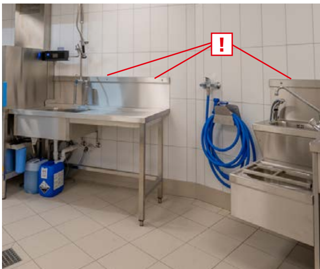
Bohrungen in der Großküchenwand zur Fixierung von Einrichtungsgegenständen.
