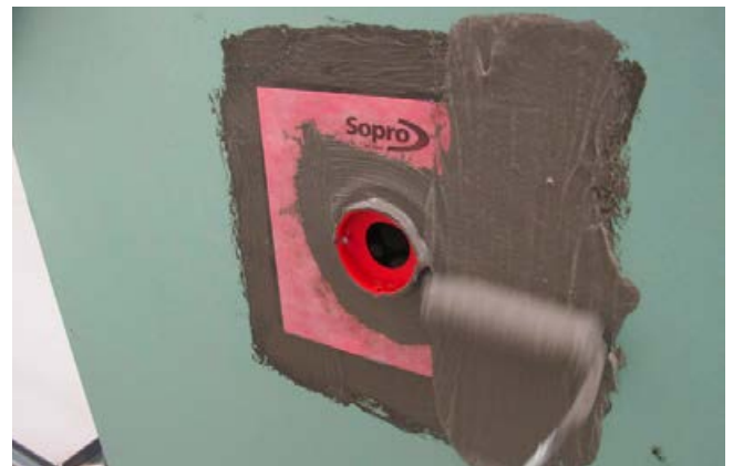
4 Eindichten der Sopro Manschette und dem Aufsatzring.
