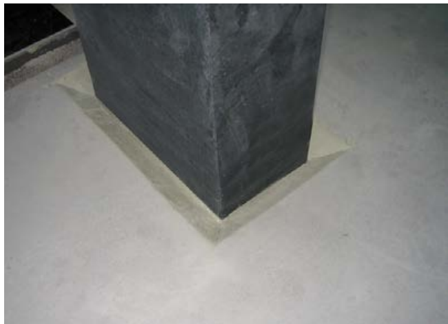
Ausgesparter Estrich an einer Stütze zur sockelfreien Anbindung der Abdichtung.
