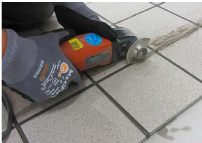
1 Herausschneiden der Fugen an der ersten Fliesenreihe.
