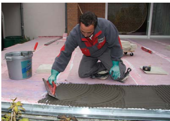
11 Aufkämmen von Sopro megaFlex S2 auf der abgedichteten Fläche.
