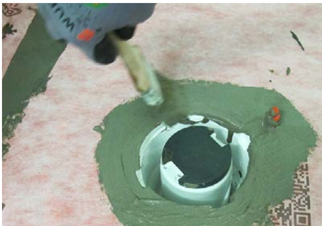
5 Die Durchdringung (Zwischenentwässerung) ist sorgfältig einzudichten.
