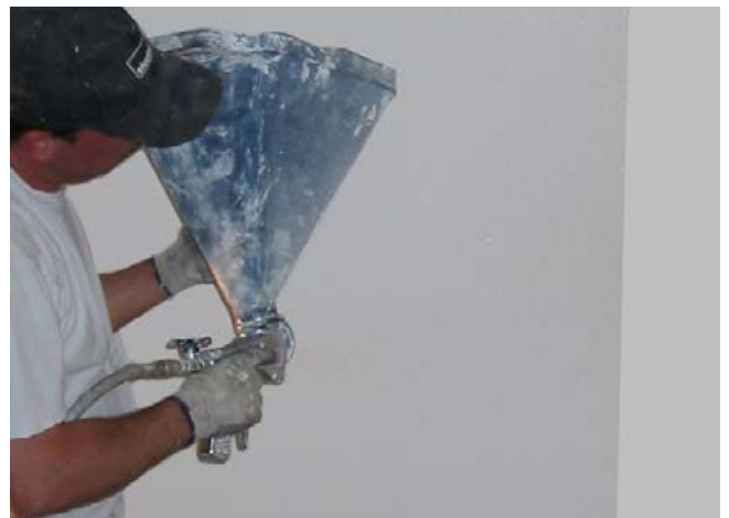
8 Aufbringen von Sopro Quarzsand grob als Haftbrücke in die frische zweite Sopro PU-FlächenDicht Abdichtungsschicht.
