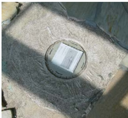
System ACO: Aufstockelement nun eingebaut und in die Flächenverbundabdichtung integriert.
