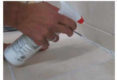
Aufsprühen des Sopro Glättmittels zur leichten Bearbeitung der Fugendichtstoffoberfläche.
