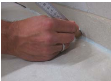
Abziehen des Überschussmaterials mittels Spachtel.
