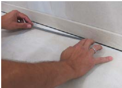
Hinterfüllschnur einlegen.
