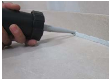
Einbringen des Dichtstoffs Sopro SanitärSilikon mittels Sopro Silikonspritze.
