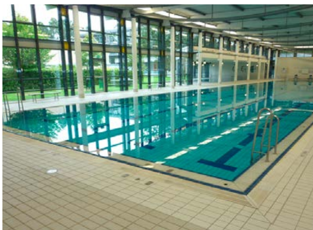
Hochfester, zementärer Fugenmörtel in der Kombination mit der üblichen Schwimmbadkeramik im Unterwasserbereich.
