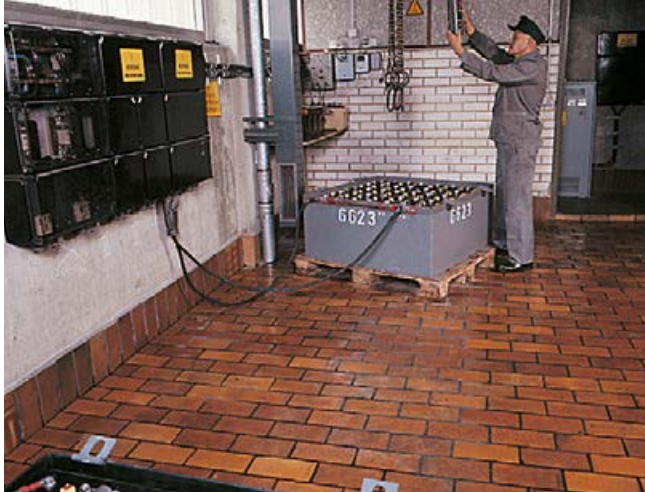
Reaktionsharzverfugung in Bereichen mit hoher Säure- und Chemikalienbelastung, z. B. Batterieladerraum.
