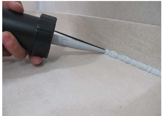
Einbringen des Dichtstoffes mittels Spritze in die Bewegungsfuge.
