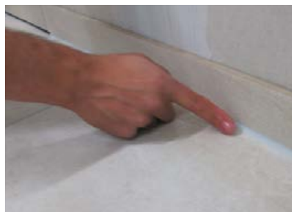
Nachglätten mit der Hand – Fertig!
