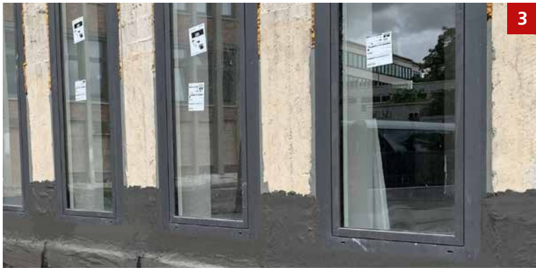
Fassade mit Verblendmauerwerk: Anschluss an Fenster mit RahmenDichtband
