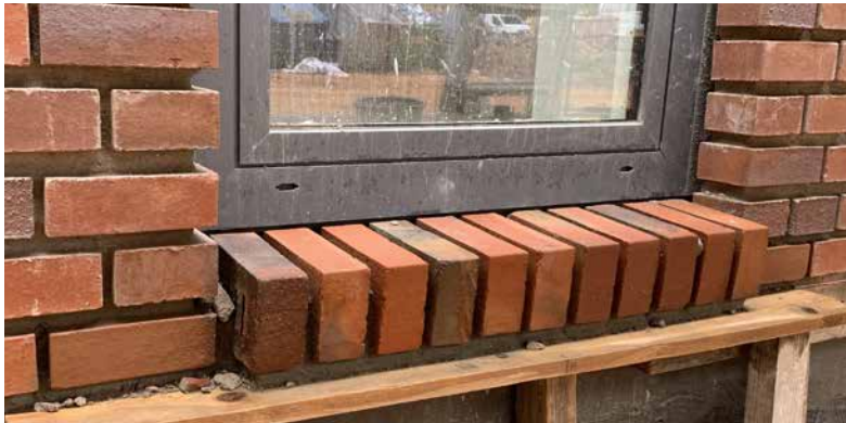
Fassade mit Verblendmauerwerk: Anschluss an Fenster mit RahmenDichtband
