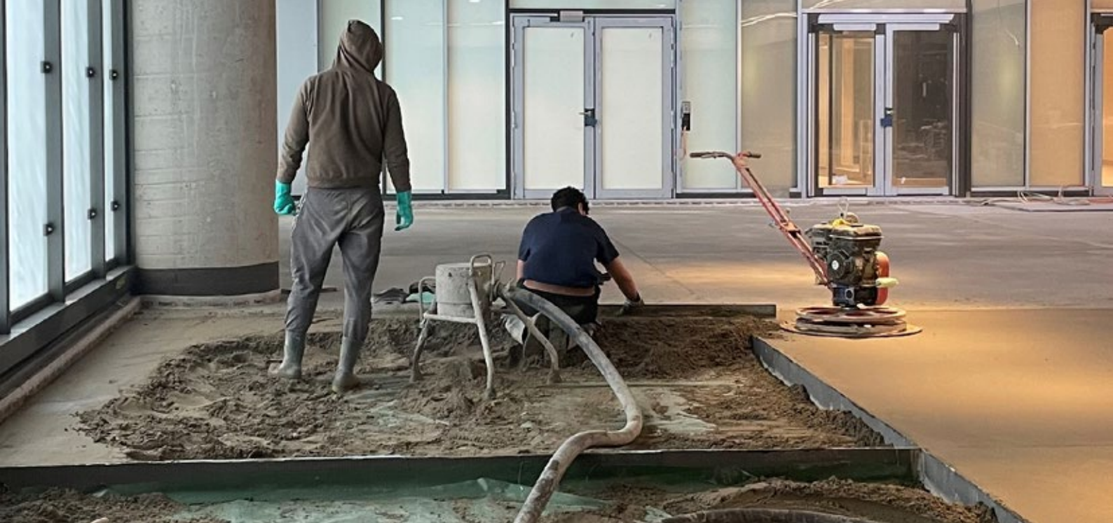
Einbau eines schwindarmen Zement-Schnellestrichs
