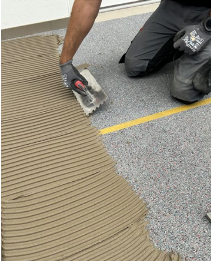
Auf die verlegte Entkopplungsmatte wird anschließend ein Fliesenkleber aufgezehnt.
