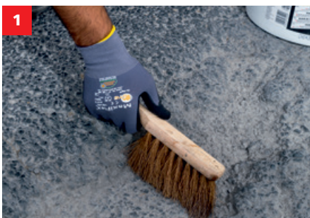
1 Reinigen der Schadstelle
