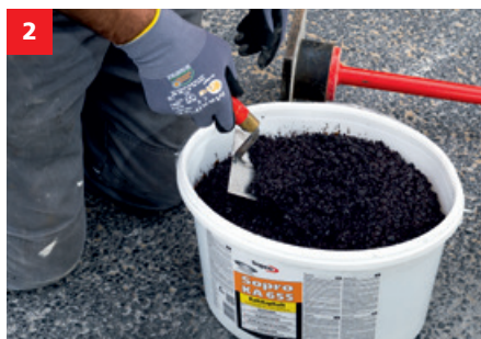
2 Sopro KaltAsphalt einbringen
